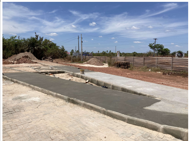
Fig. 10 – execução de calçada
