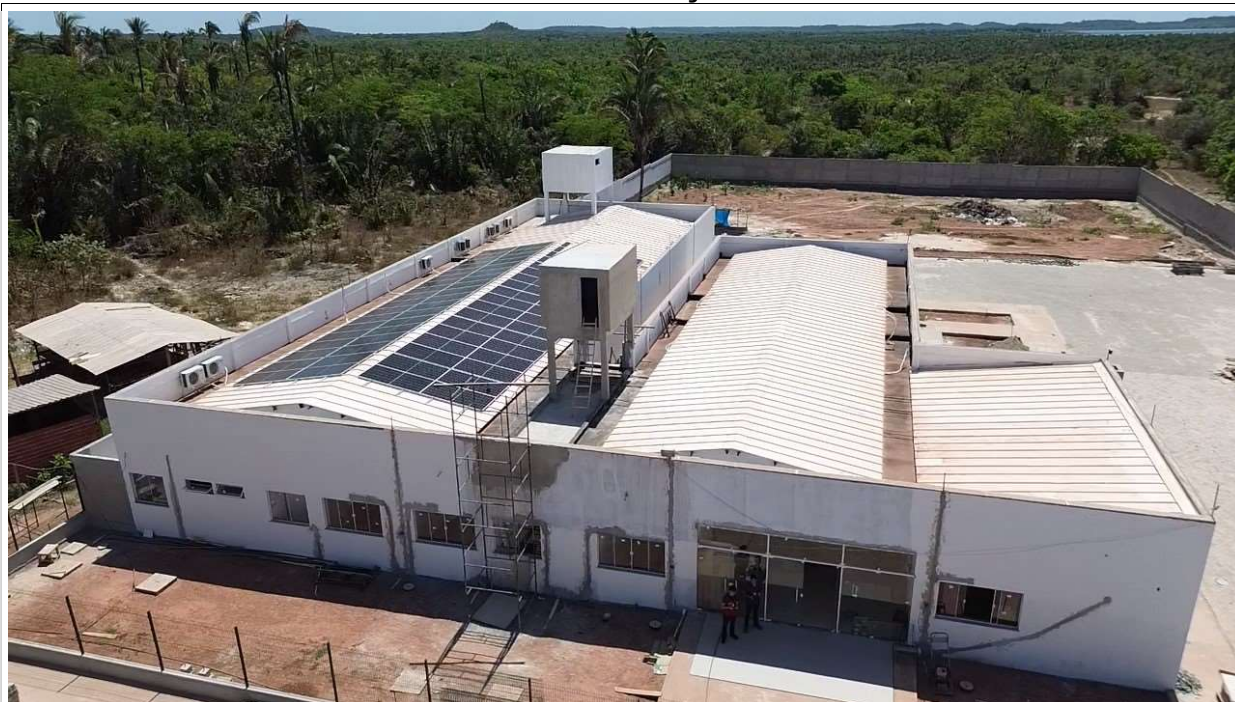
Fig. 1 – Vista aérea da obra
