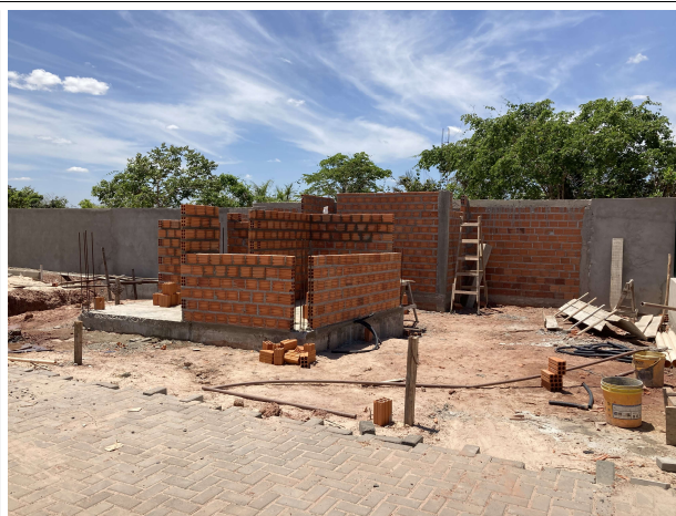
Fig. 4 – construção da guarita
