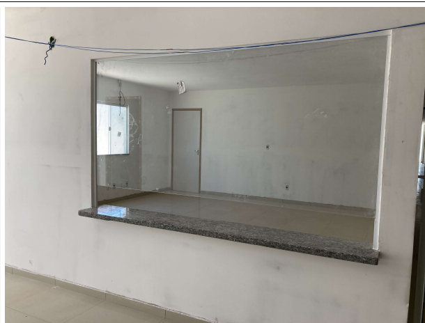
Fig. 6 – execução de esquadrias e granito
