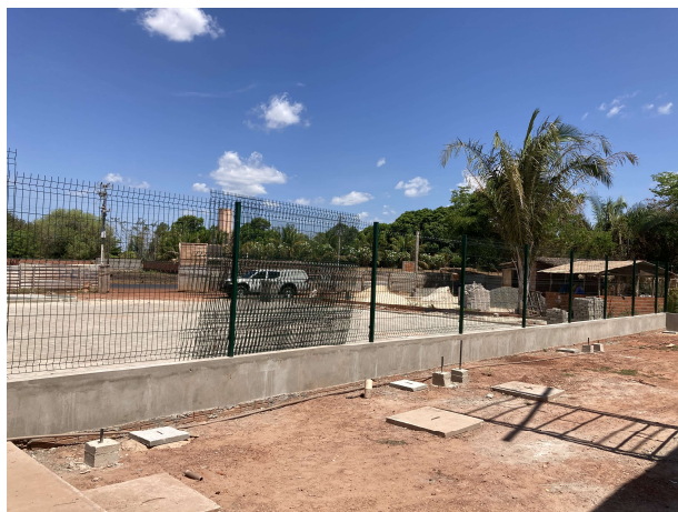
Fig. 11 – execução de gradil
