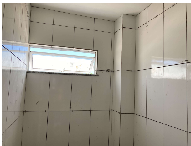
Fig. 8 – execução de revestimentos
