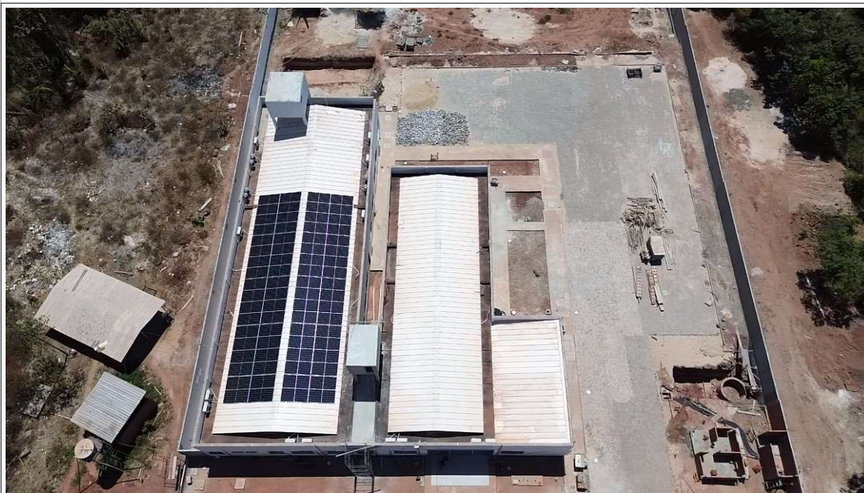
Fig. 2 – Execução de sistema fotovoltaico e reservatórios
