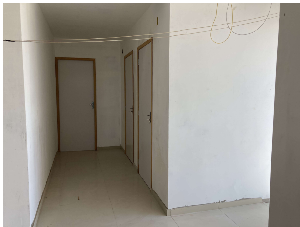
Fig. 9 – pintura e esquadrias de madeira
