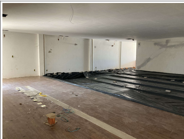
Fig. 7 – execução de piso vinílico
