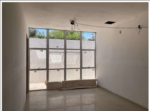
Fig. 14 – execução de esquadrias de vidro
