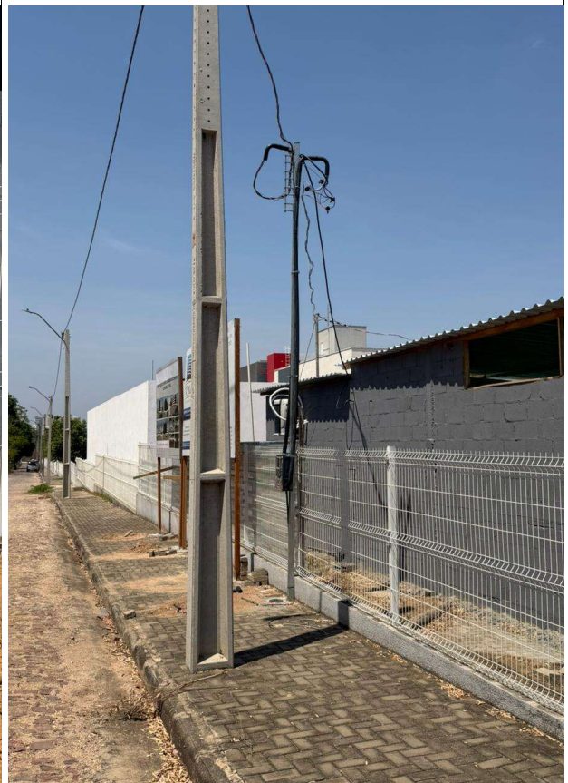
Foto 11– Instalação provisória de energia.
