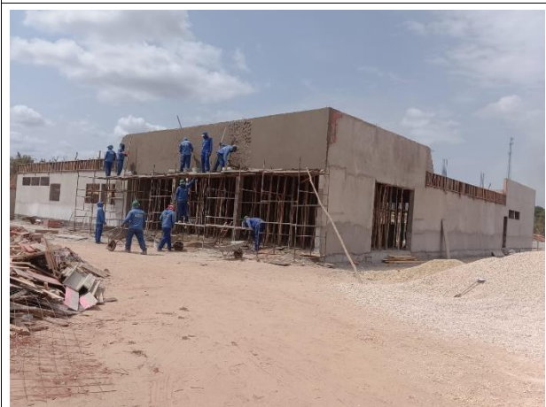
Fig. 3 – Platibanda e revestimento externo em execução.
