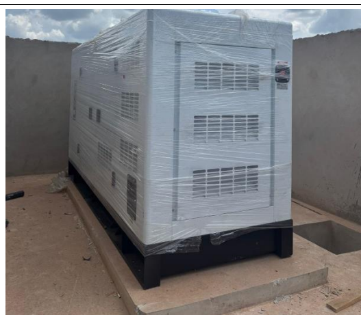
Fig. 2 – Gerador posicionado na obra.
