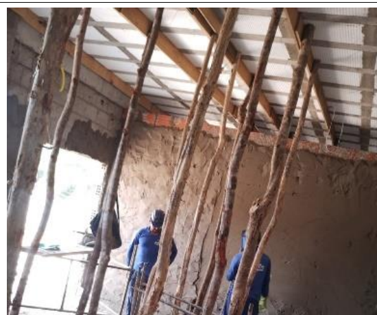
Fig. 4 – Superestrutura e revestimento em execução.
