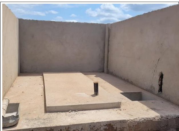
Fig. 1 – Base do gerador executada.
