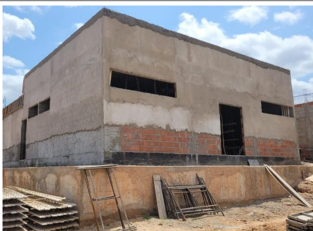
Fig. 3 – Execução de alvenaria e revestimento.
