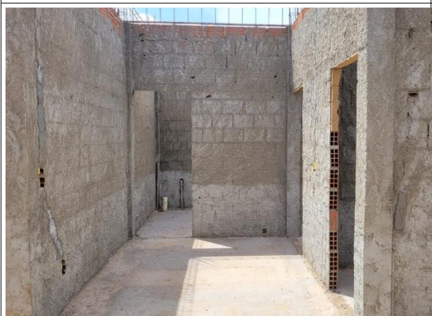
Fig. 11 – Alvenaria e revestimentos em execução.
