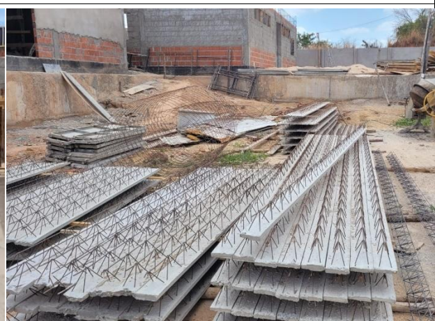
Fig. 8 – Vigotas pré-moldadas em execução.
