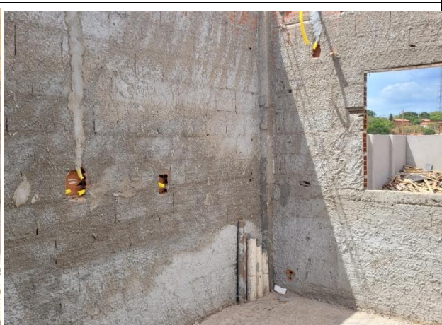
Fig. 14 – Instalações e alvenarias em execução.
