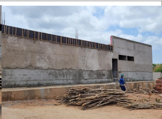
Fig. 10 – Alvenarias e revestimentos em execução.
