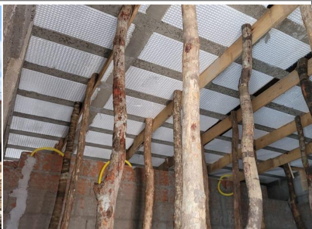
Fig. 4 – Laje bidirecional executada.
