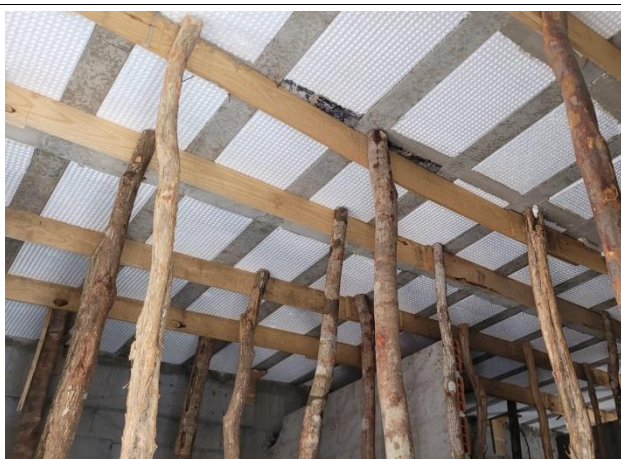
Fig. 5 – Laje bidirecional executada.
