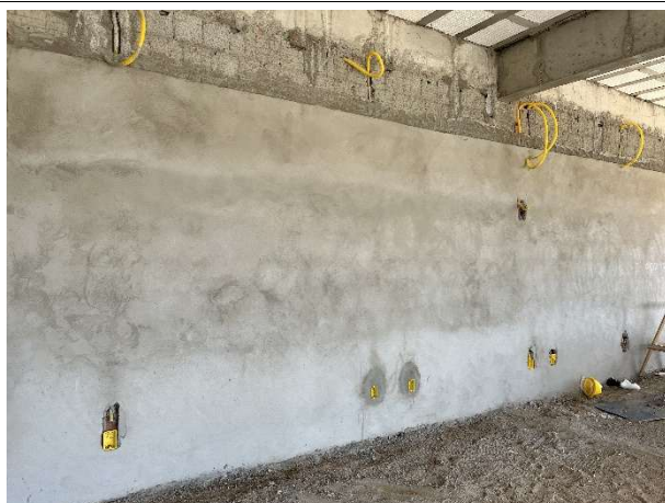
Foto 5 – Revestimentos/instalações elétricas e lógicas
