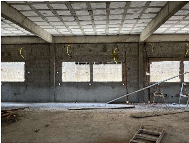
Foto 9 – Contrapiso/instalações elétricas e lógicas
