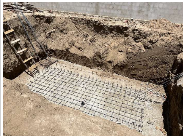
Foto 12 – Cisterna de reuso (instalações hidrossanitárias)
