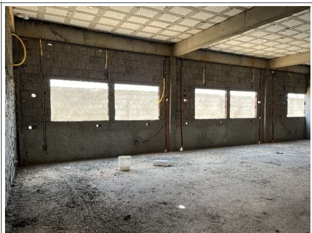
Foto 8 – Contrapiso/instalações elétricas e lógicas
