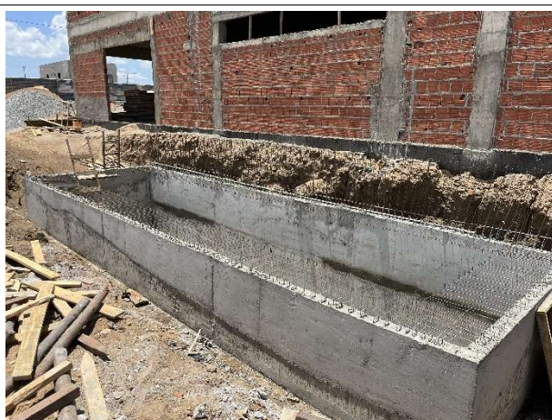
Foto 7 – Cisterna de água fria (instalações hidrossanitárias)
