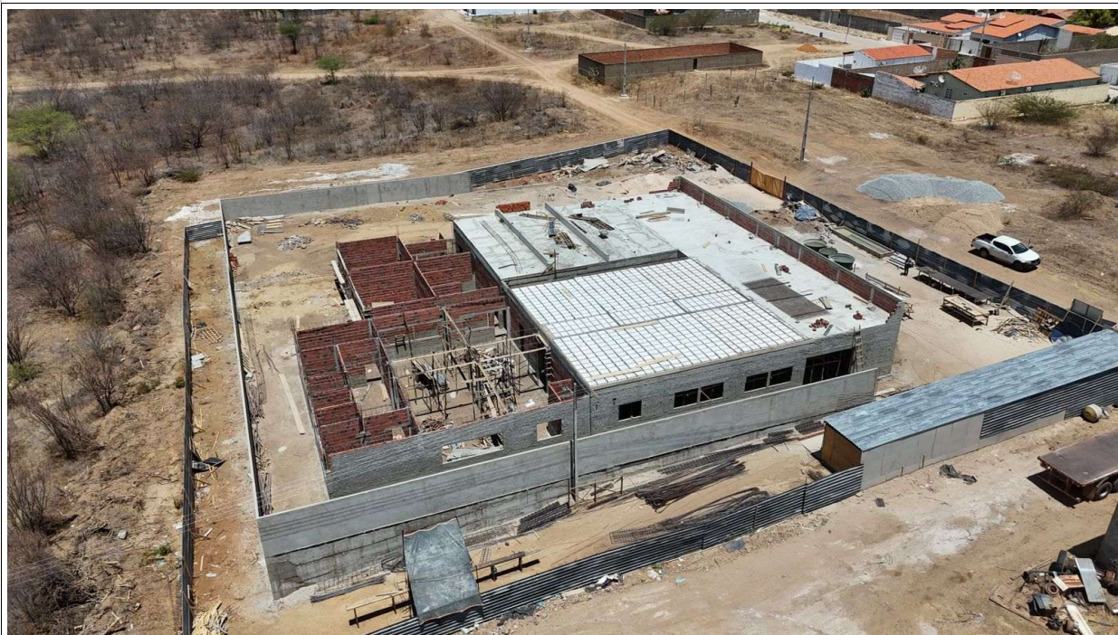
Foto 2 – Vista aérea da obra em 03/10/2025
