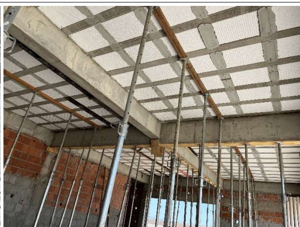
Foto 6 – Execução de laje treliçada (superestrutura)
