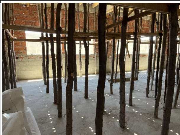
Foto 11 – Execução de contrapiso (pavimentação)
