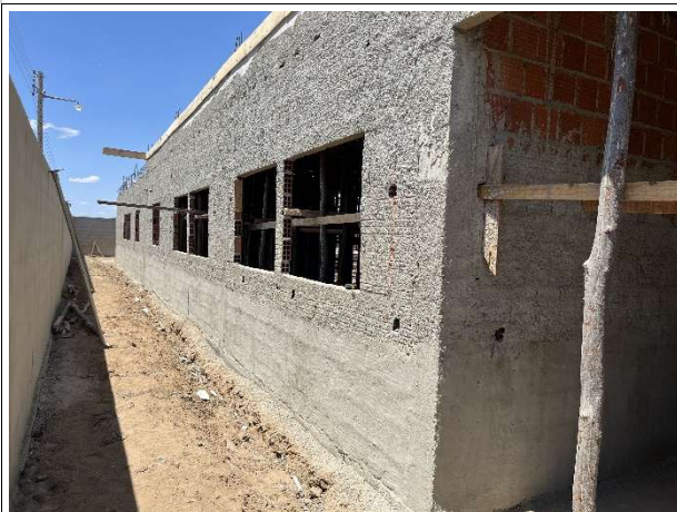
Foto 13 – Execução de alvenaria e revestimentos
