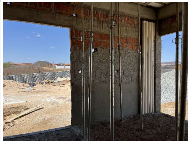
Foto 10 – Alvenaria e instalações pluviais
