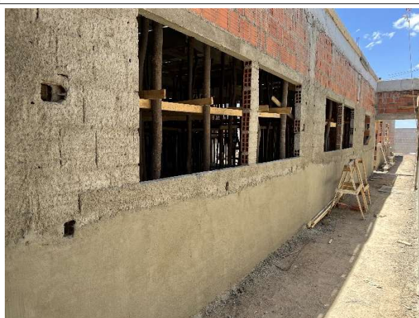
Foto 8 – Execução de alvenaria e revestimentos
