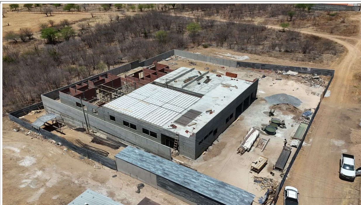
Foto 1 – Vista aérea da obra em 03/10/2025
