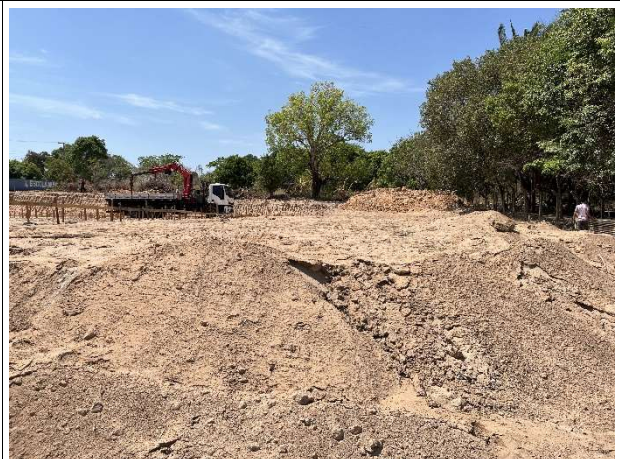
Fig. 12 – Regularização do terreno
