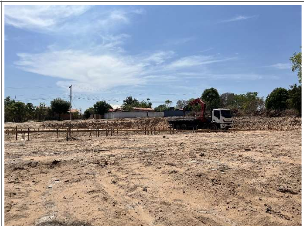
Fig. 8 – Regularização do terreno/terraplanagem
