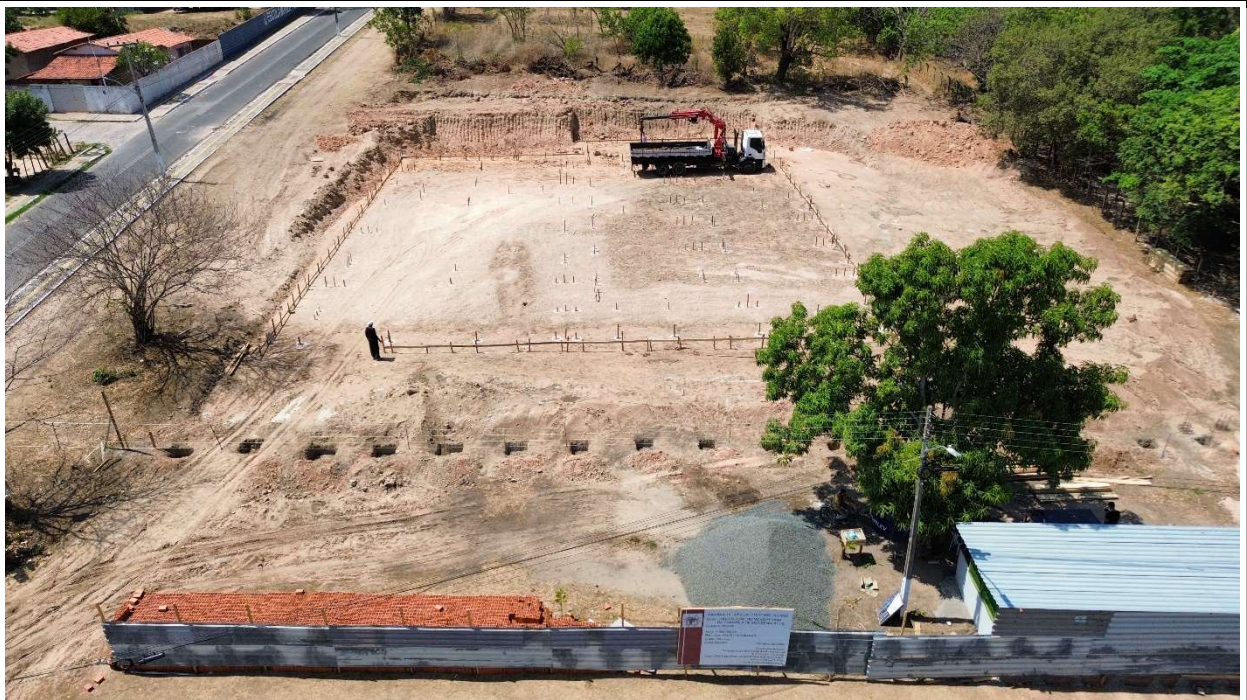
Fig. 1 – Vista aérea da obra em 16/10/2025
