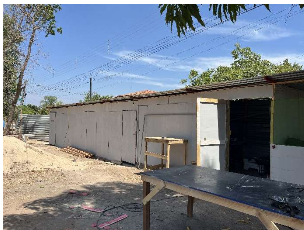
Fig. 9 – Estruturas de apoio do canteiro
