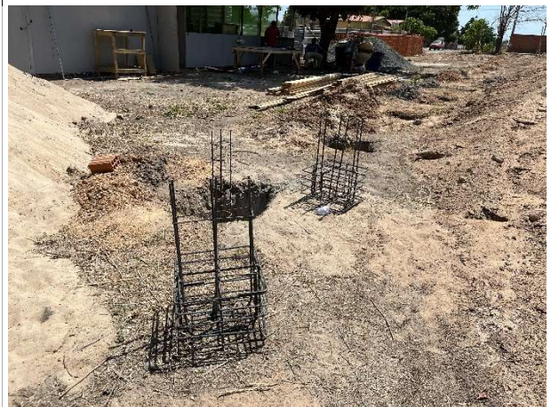
Fig. 6 – Execução de escavações e fundações
