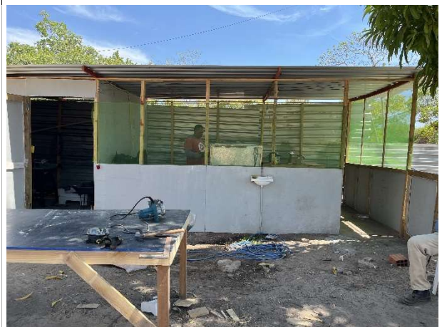
Fig. 10 – Estruturas de apoio do canteiro
