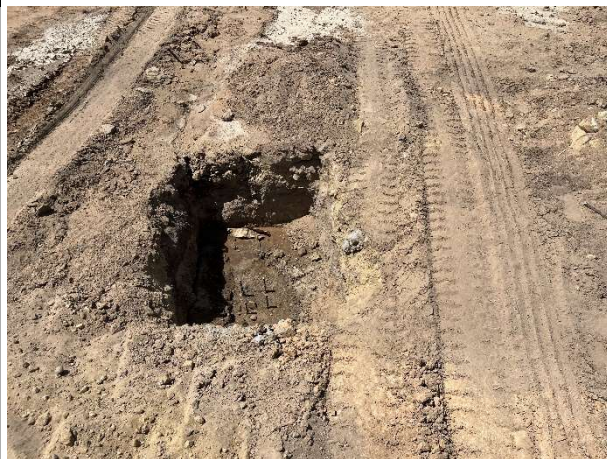
Fig. 5 – Execução de escavações e fundações
