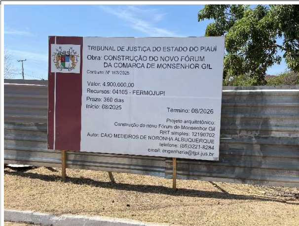
Fig. 3 – Placa da obra
