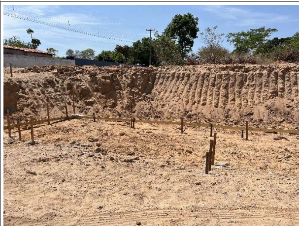
Fig. 7 – Regularização do terreno/terraplanagem
