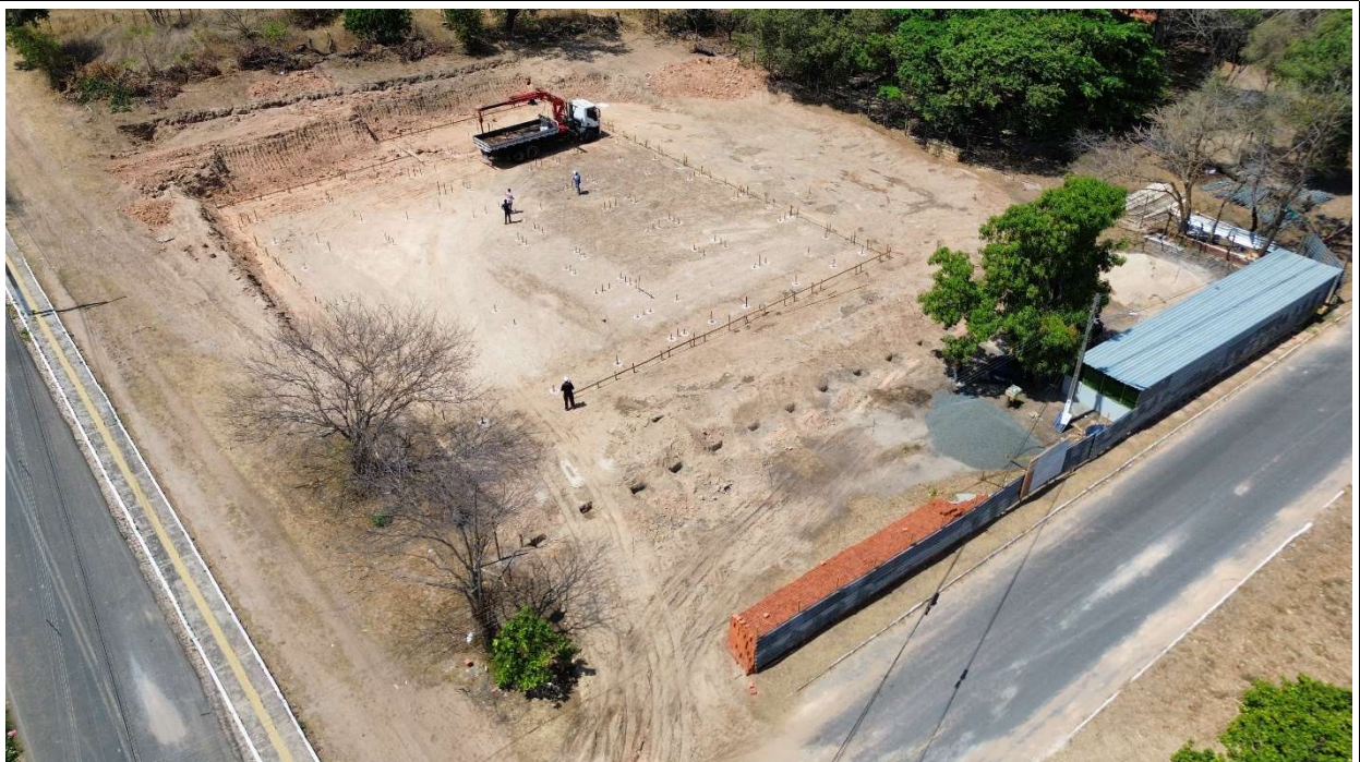
Fig. 2 – Vista aérea da obra em 16/10/2025
