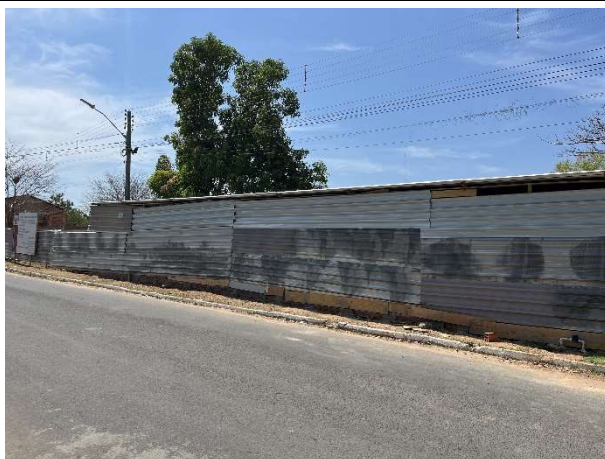
Fig. 11 – Instalação de tapumes
