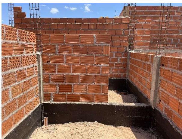
Fig. 7 – Impermeabilização de vigas (infraestrutura)
