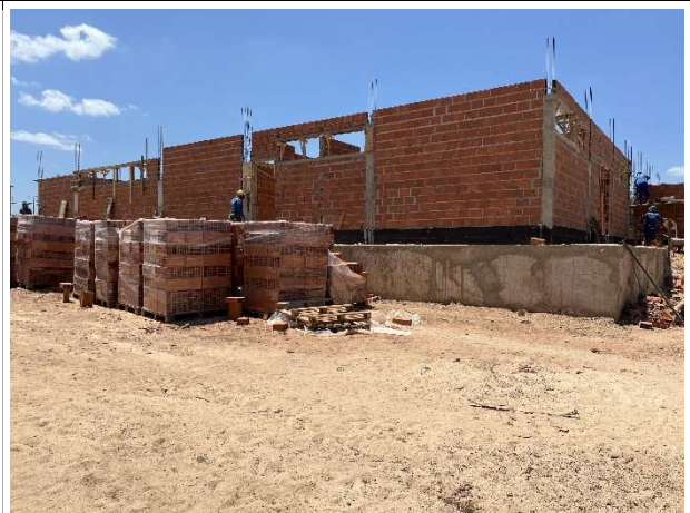
Fig. 12 – Vista posterior da futura edificação
