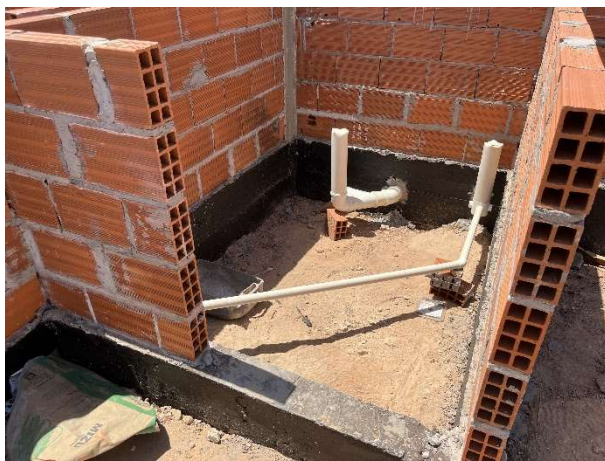
Fig. 9 – Execução de instalações sanitárias
