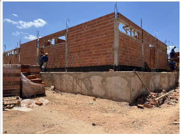
Fig. 4 – Infraestrutura do muro de arrimo, alvenaria
