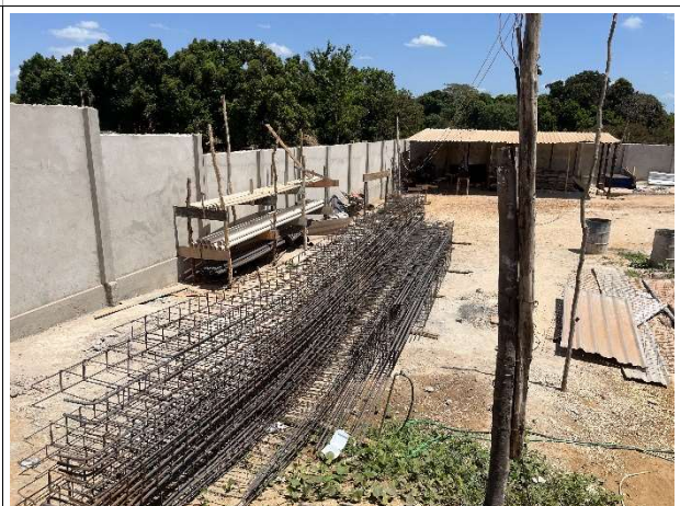
Fig. 14 – Infraestrutura do muro
