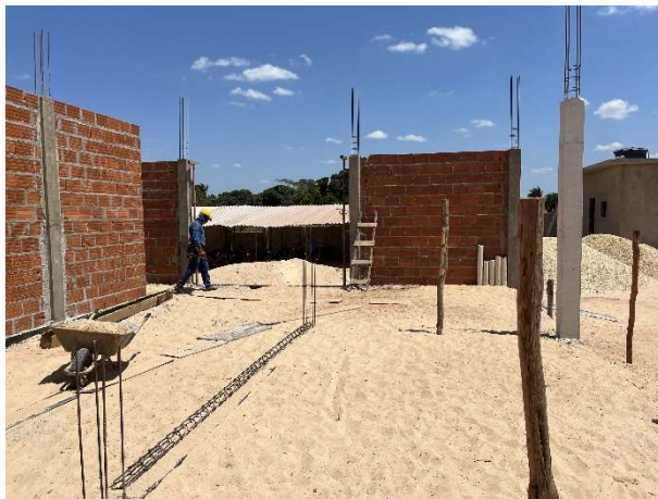
Fig. 3 – Execução de aterro de caixão (infraestrutura)
