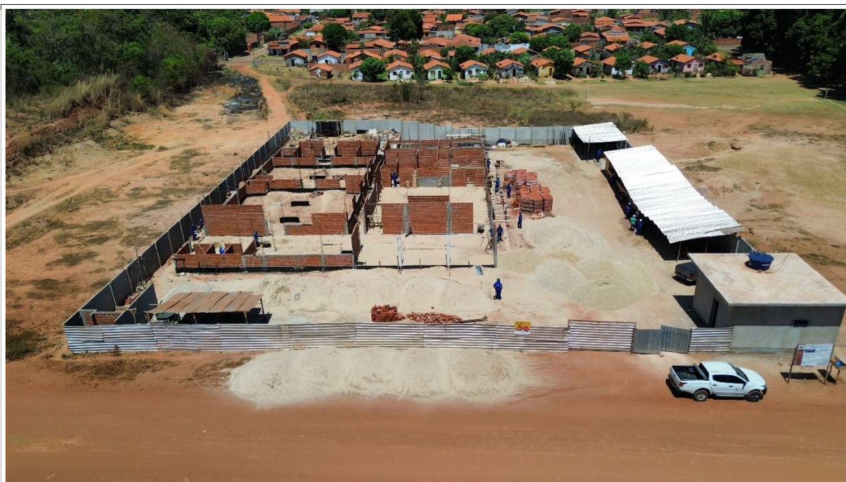
Fig. 1 – Vista aérea da obra em 01/10/2025
