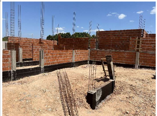
Fig. 6 – Execução de superestrutura e alvenaria
