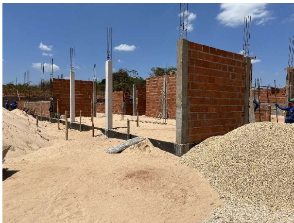
Fig. 5 – Execução de superestrutura e alvenaria
