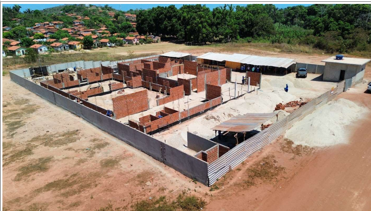
Fig. 2 – Vista aérea da obra em 01/10/2025
