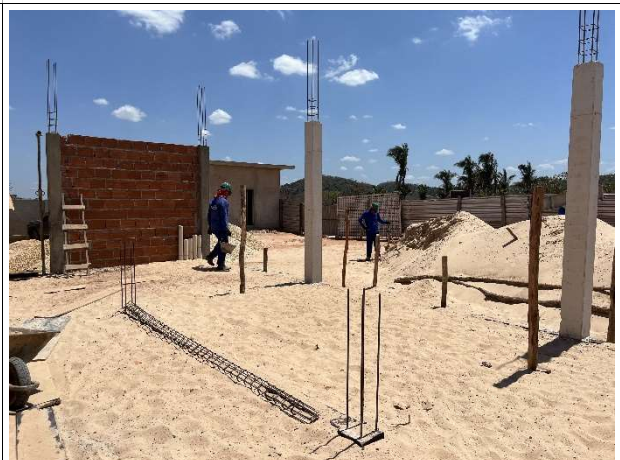
Fig. 8 – Armação e concretagem de pilares
