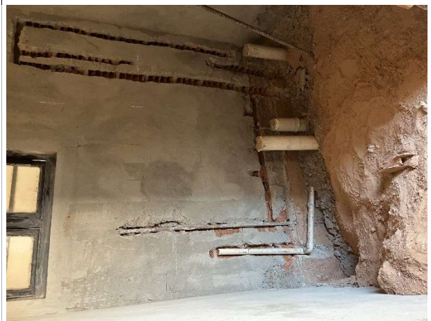
Fig. 10 – Execução de instalações sanitárias
