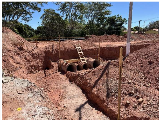
Foto 10 – Infraestrutura (movimento de terra/tubulões)
