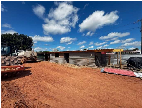
Foto 15 – Estruturas de apoio do canteiro de obras (serviços preliminares)
