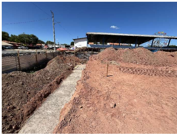
Foto 9 – Infraestrutura (fundação do muro de arrimo)
