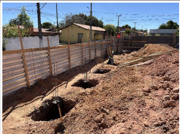
Foto 12 – Execução de escavações e fundações
