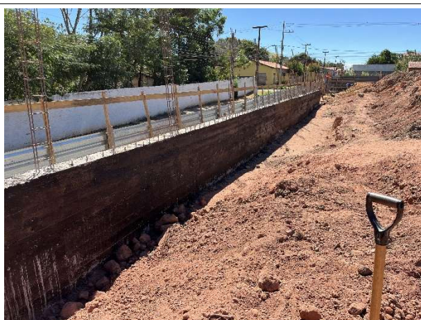
Foto 7 – Estrutura do muro de arrimo/contenção
