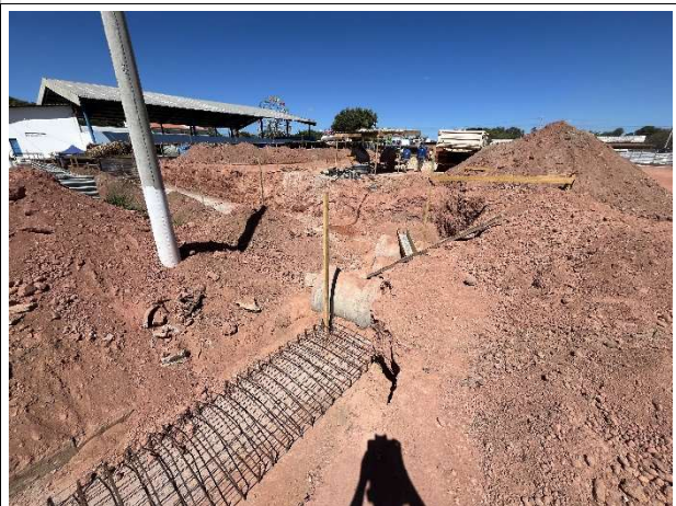
Foto 14 – Infraestrutura (muro de arrimo/tubulões)
