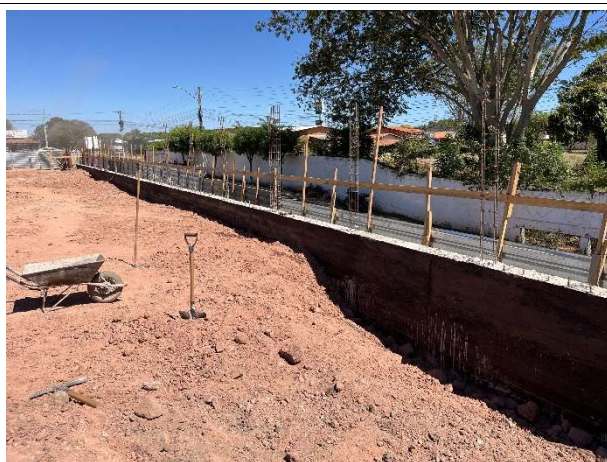
Foto 13 – Movimento de terra/muro de arrimo
