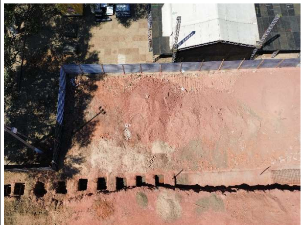
Foto 18 – Execução de infraestrutura do muro
