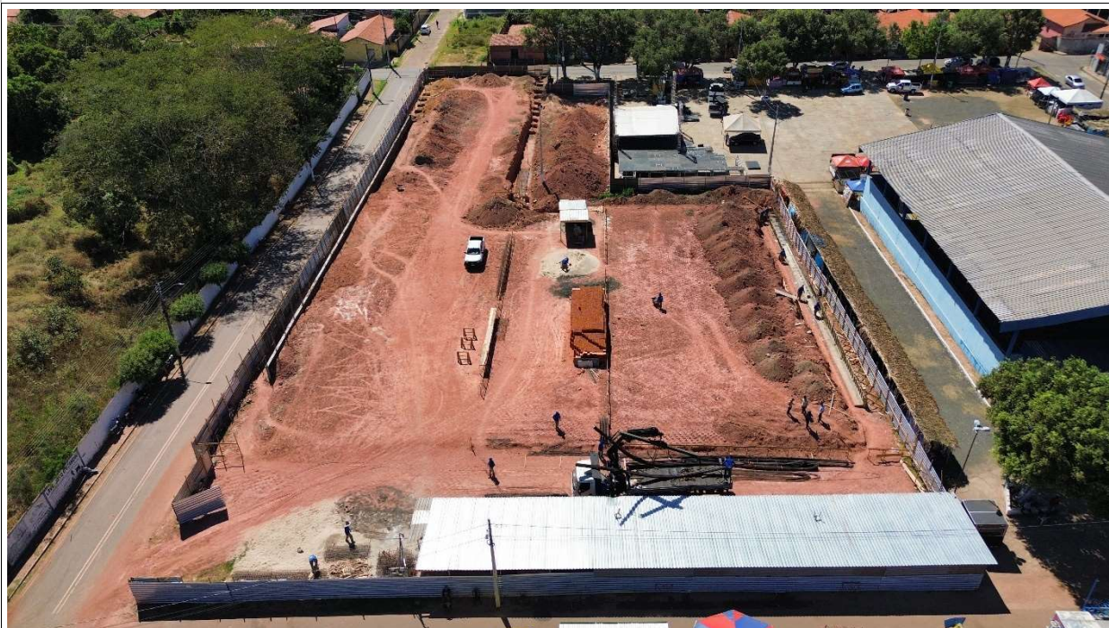
Foto 2 – Vista aérea da obra em 29/07/2025
