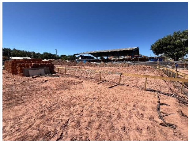
Foto 4 – Locação da edificação do Fórum
