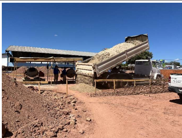
Foto 5 – Execução de terraplanagem/movimento de terra
