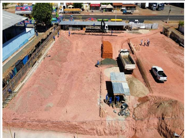
Foto 6 – Execução de terraplanagem/movimento de terra
