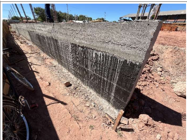
Foto 8 – Estrutura do muro de arrimo/contenção
