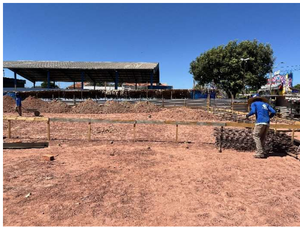
Foto 3 – Locação da edificação do Fórum
