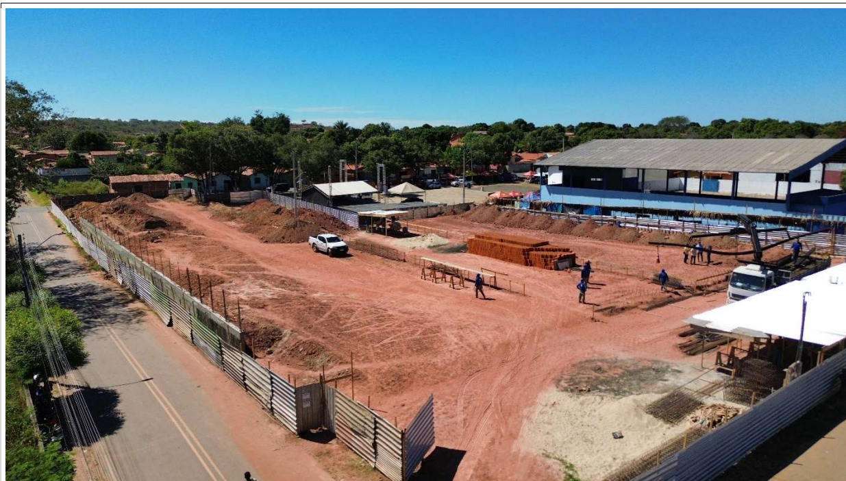
Foto 1 – Vista aérea da obra em 29/07/2025
