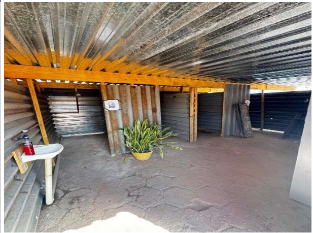
Foto 16 – Estruturas de apoio do canteiro de obras (serviços preliminares)
