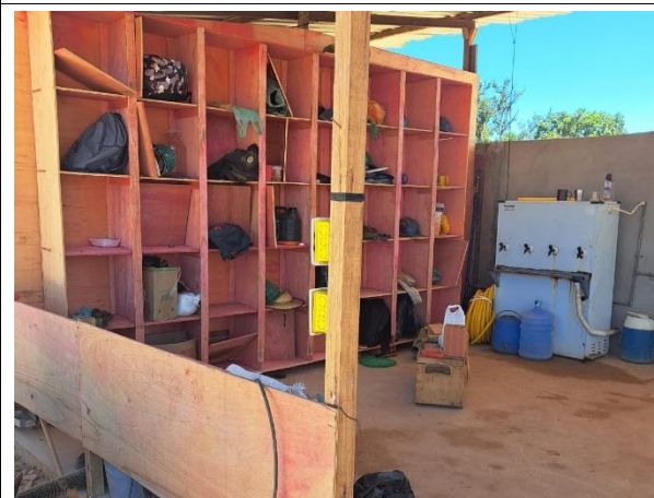
Fig. 14 – Instalações do canteiro de obras.
