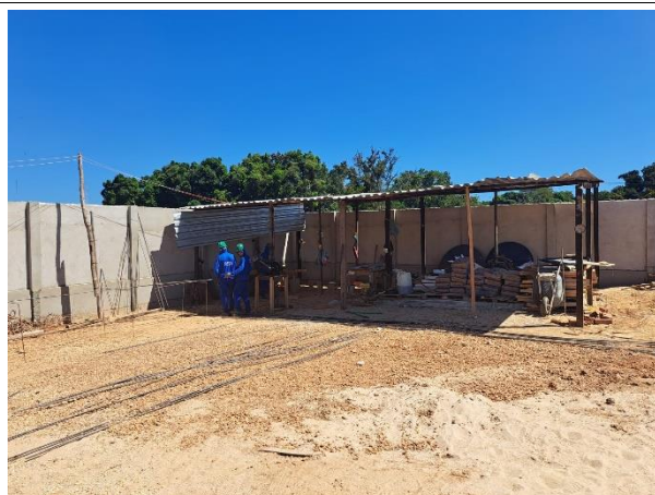
Fig. 11 – Materiais e armaduras em execução.
