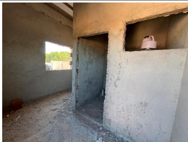
Fig. 7 – Vista interna da guarita/lixeria.
