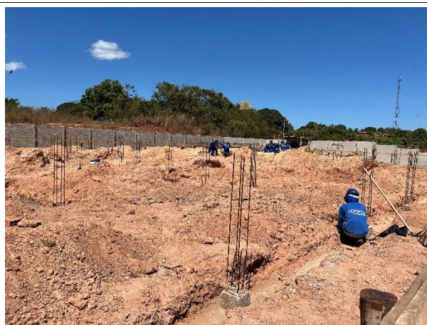
Fig. 13 – Fundação em execução.
