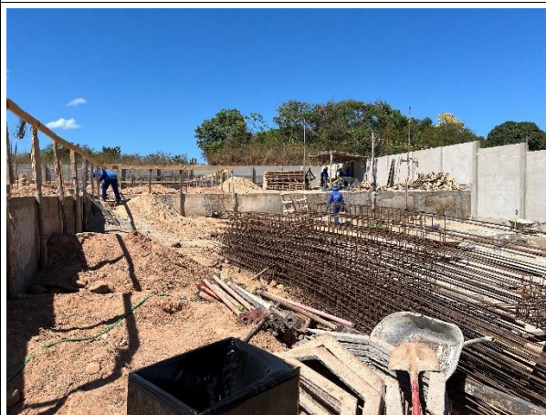
Fig. 12 – Vista posterior da futura edificação.
