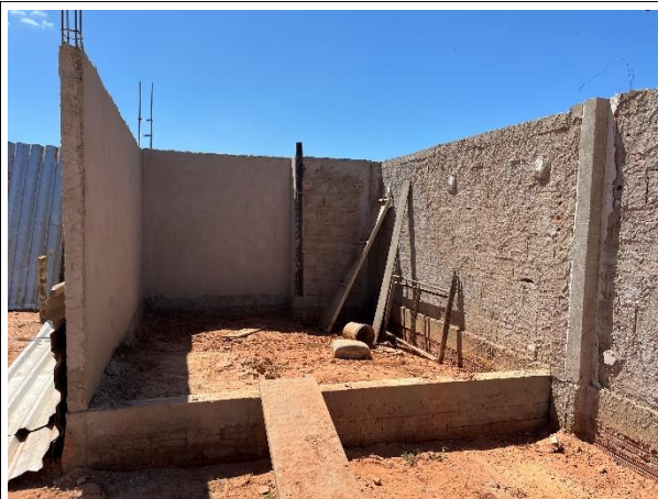
Fig. 10 – Muro e casa do gerador em execução.
