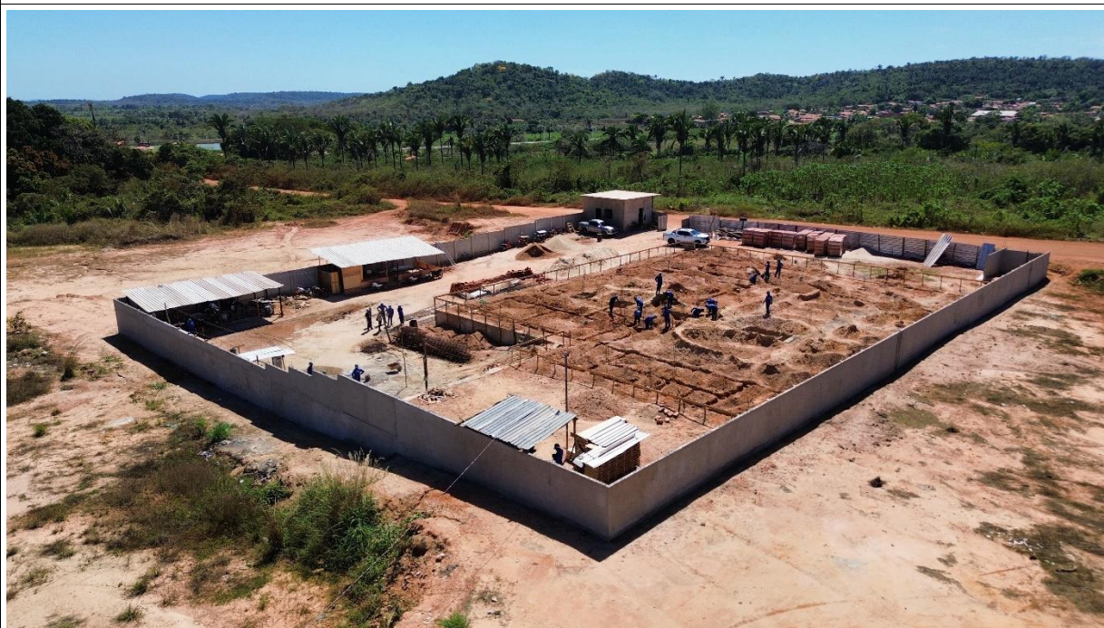
Fig. 2 – Muro sendo executado. Locação da obra e execução das vigas de fundação.
