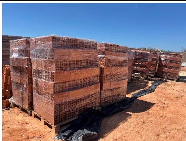
Fig. 9 – Materiais postos na obra.
