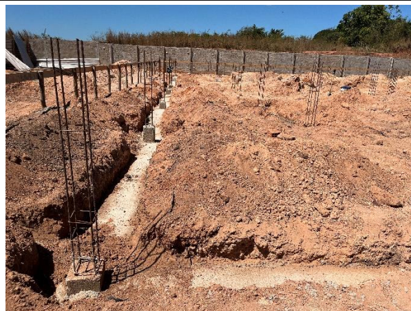
Fig. 6 – Vigas de fundação e espera dos pilares.
