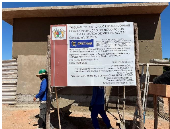
Fig. 4 – Placa da obra.
