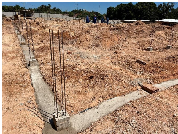
Fig. 5 – Vigas de fundação e espera dos pilares.
