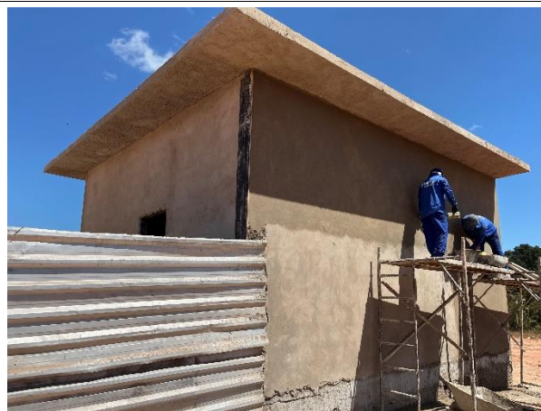
Fig. 8 – Revestimento da guarita/lixeria.
