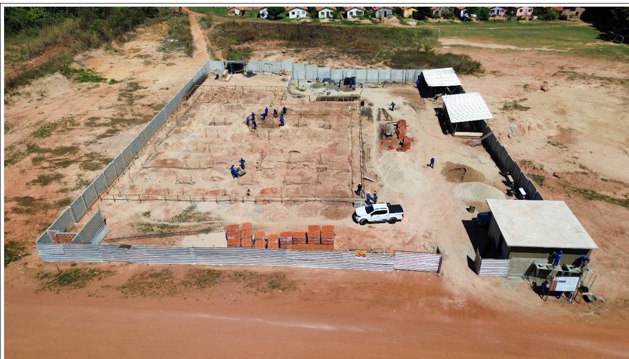
Fig. 1 – Vista aérea da obra em 21/08/2025.
