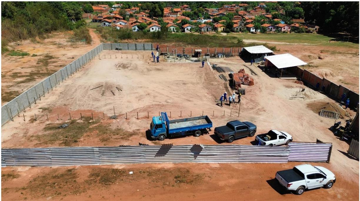
Fig. 1 – Canteiro de obras instalado e terraplenagem executada.
