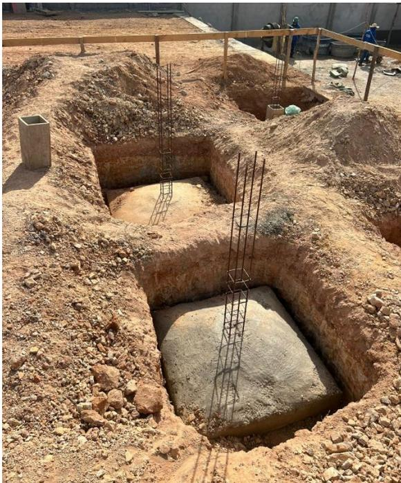
**Fig. 9 – Fundações concretadas.**
