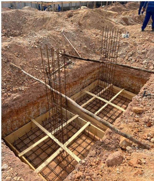
Fig. 3 – Escavação e execução de fundações.
