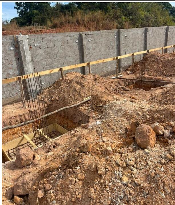
Fig. 5 – Locação das fundações, execução das escavações e formas das fundações.
