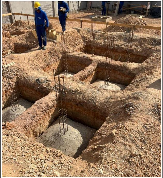
**Fig. 8 – Fundações concretadas.**
