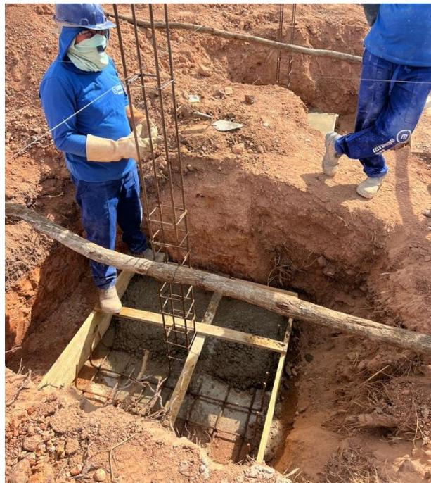
**Fig. 7 – Concretagem das fundações.**
