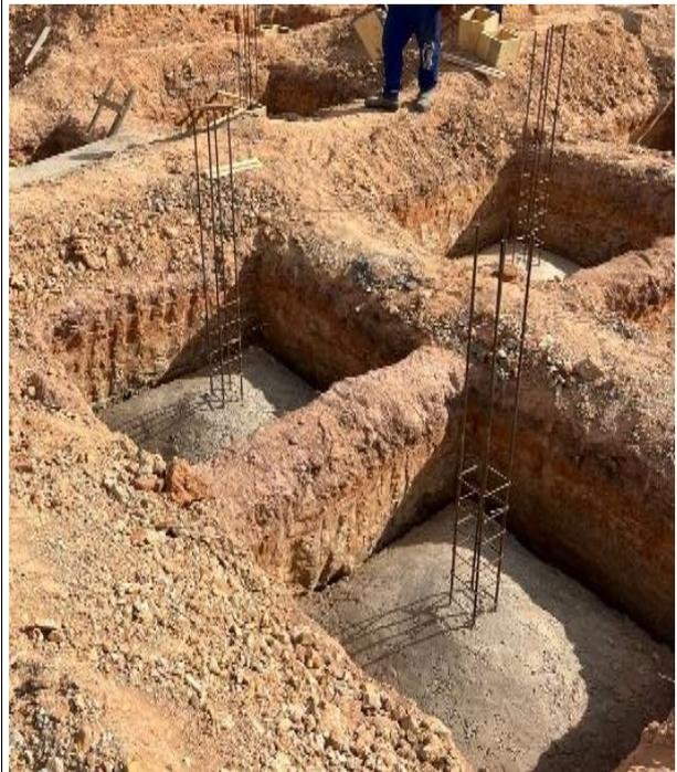
**Fig. 10 – Fundações concretadas.**
