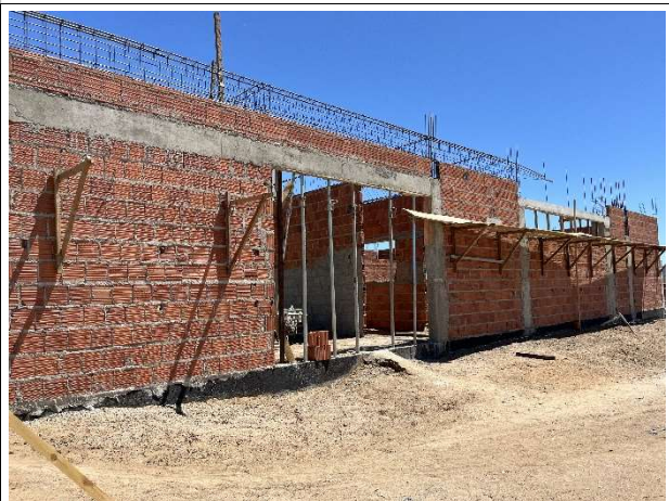
Foto 8 – Execução de superestrutura e alvenaria
