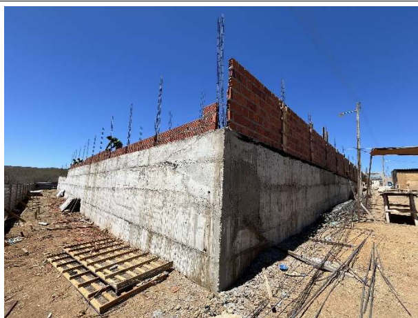
Foto 5 – Infraestrutura (muro de arrimo) e alvenaria
