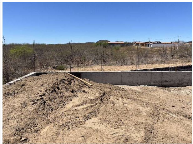
Foto 10 – Infraestrutura (terraplanagem/muro de arrimo)
