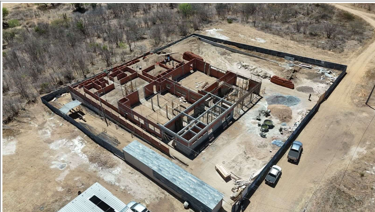
Foto 2 – Vista aérea da obra em 18/08/2025
