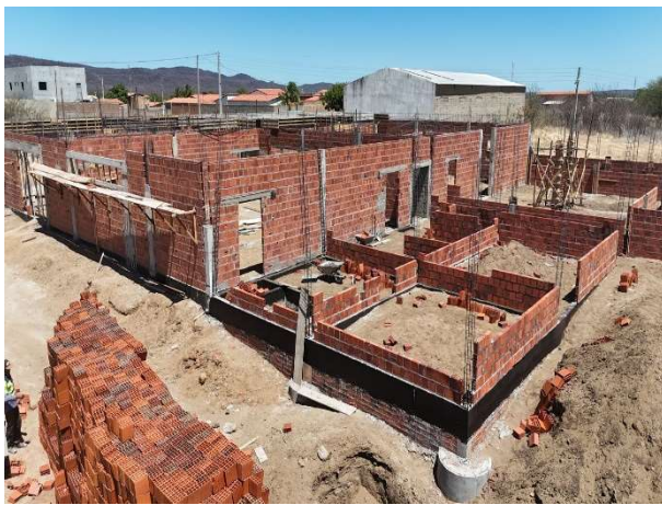
Foto 9 – Baldrame/fundação/terraplanagem
