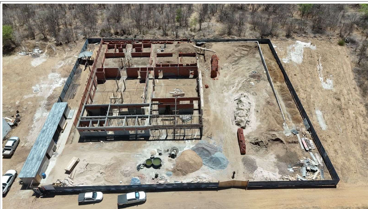
Foto 1 – Vista aérea da obra em 18/08/2025
