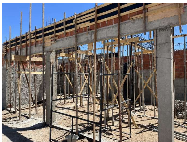
Foto 7 – Execução de superestrutura
