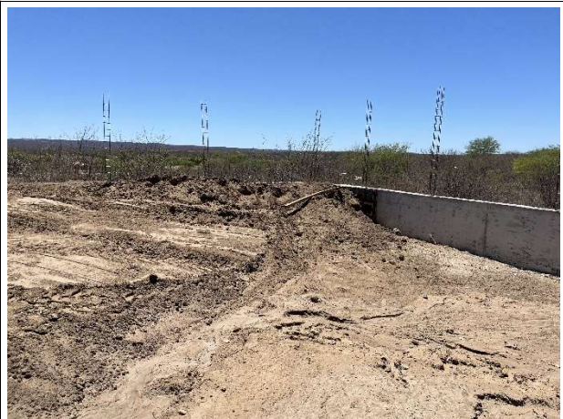
Foto 14 – Infraestrutura (terraplanagem/muro de arrimo)
