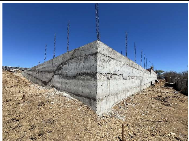
Foto 6 – Execução de infraestrutura (muro de arrimo)
