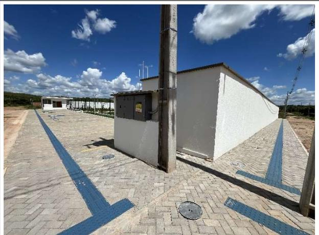
Fig. 24 – Quadro de medição/piso tátil
