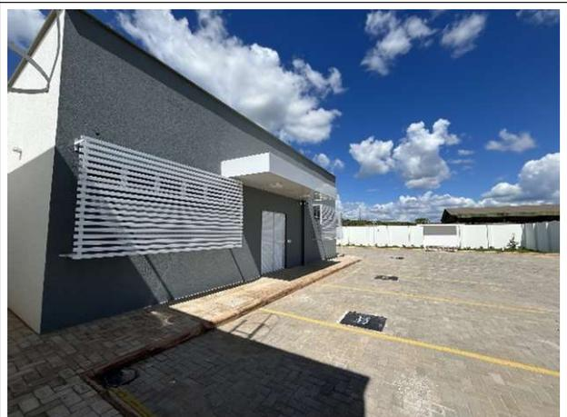
Fig. 20 – Execução de pintura, brises e marquise de ACM
