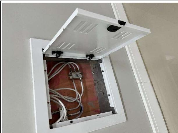
Fig. 13 – Instalações de antena de TV
