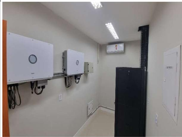
Fig. 9 – Inversores fotovoltaicos e rack de cabeamento
