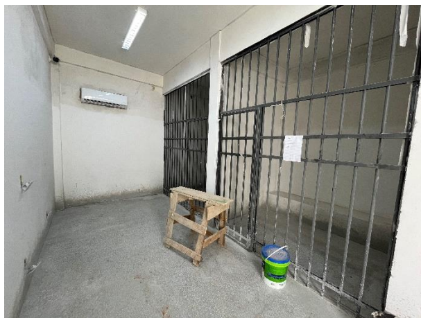
Fig. 13 – Celas em execução.
