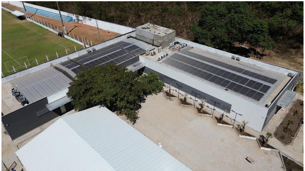
Fig. 1 – Vista aérea da obra em 28/08/2025
