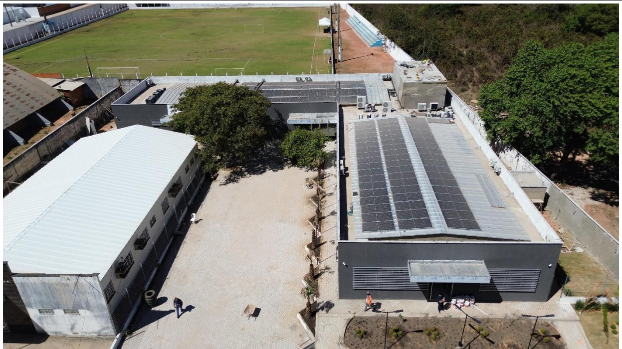
Fig. 2 – Vista aérea da obra em 28/08/2025
