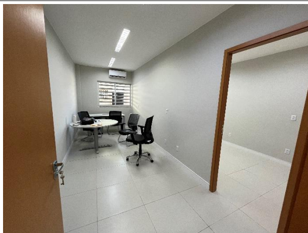
Fig. 15 – Revestimentos internos e esquadrias.
