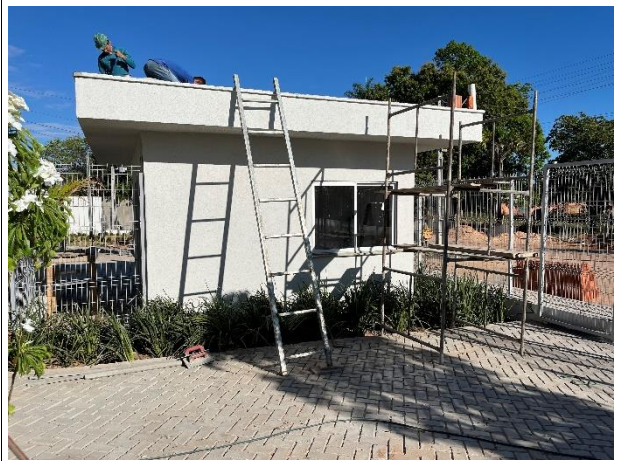
Fig. 12 – Guarita em execução.
