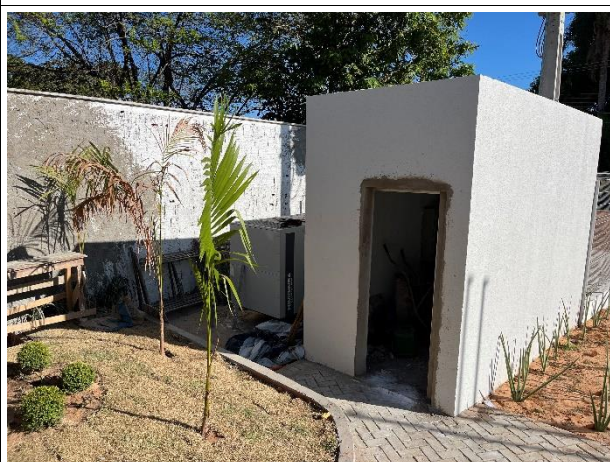
Fig. 8 – Sala do rack externo em execução.
