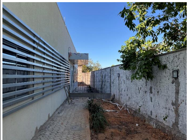
Fig. 14 – Muro lateral, brises, fechamento e marquise.
