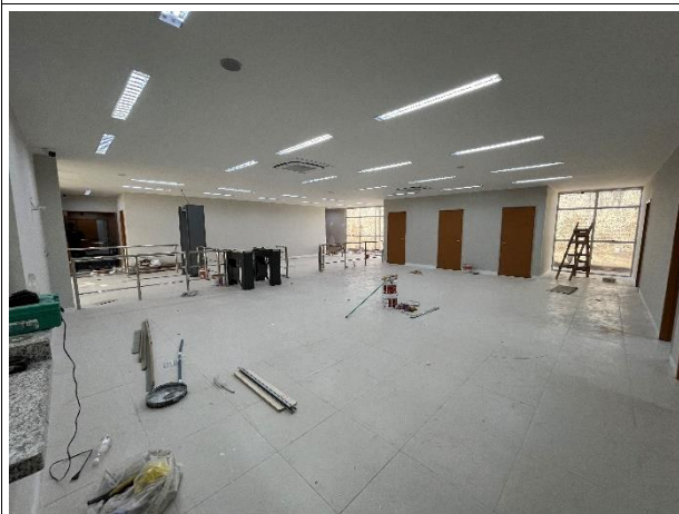
Fig. 9 – Hall de entrada.
