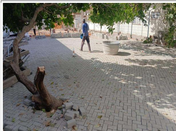
Fig. 3 – Assentamento de pavimento intertravado
