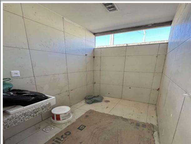
Fig. 6 – Execução de revestimento cerâmico e instalações
