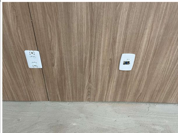
Fig. 13 – Revestimento em MDF
