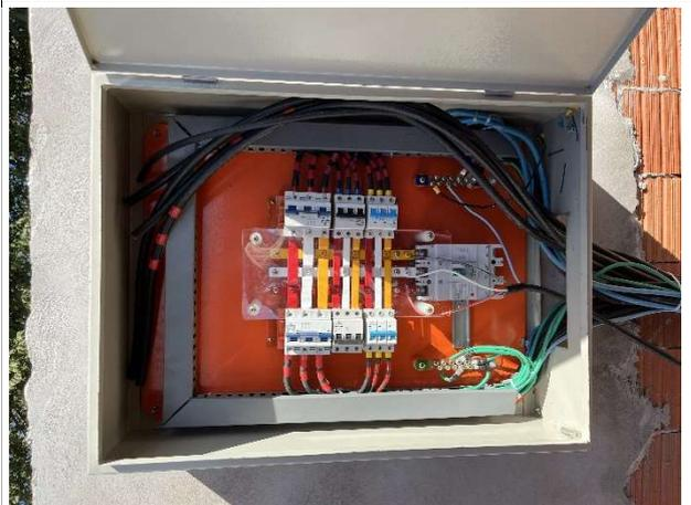
Fig. 14 – Montagem de quadro de instalações elétricas
