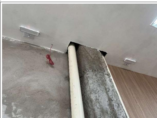
Fig. 17 – Instalação de água pluvial/iluminação de emergência
