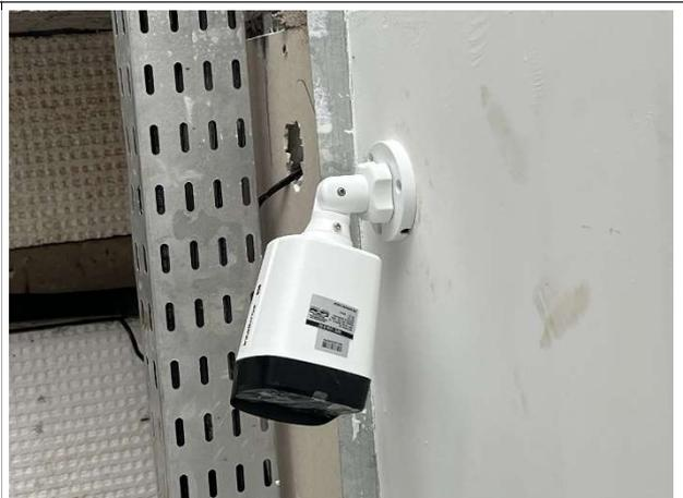
Fig. 16 – Execução de instalação de CFTV
