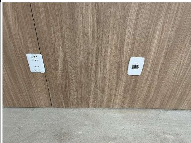
Fig. 15 – Revestimento em MDF e instalação de sonorização
