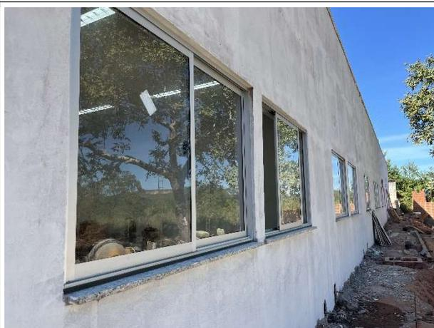
Fig. 4 – Instalação de esquadrias de alumínio e vidro
