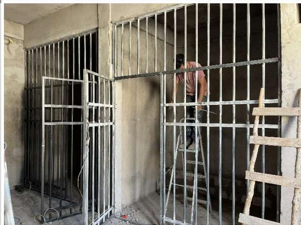
Fig. 13 – Instalação de esquadrias metálicas
