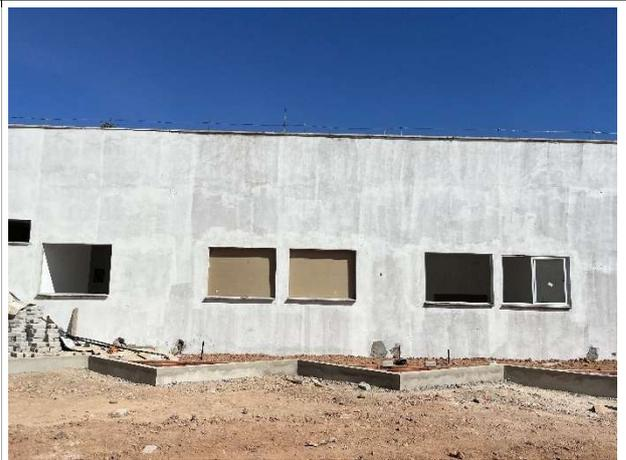
Fig. 16 – Execução de selador e instalação de SPDA
