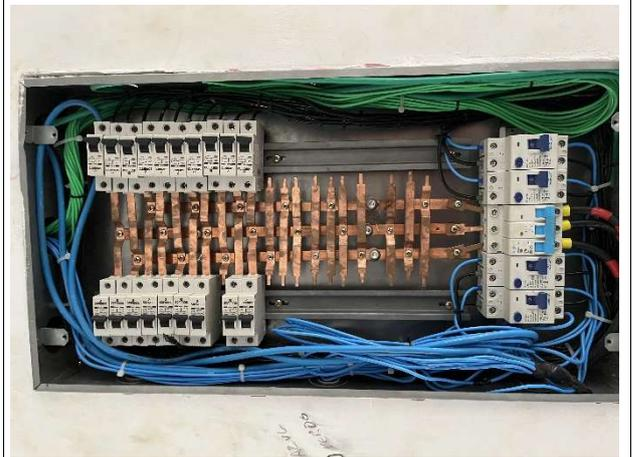
Fig. 20 – Instalação elétrica de neutro/terra corrigida
