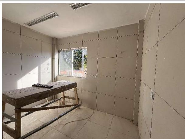
Fig. 6 – Execução de paredes e revestimento cerâmico
