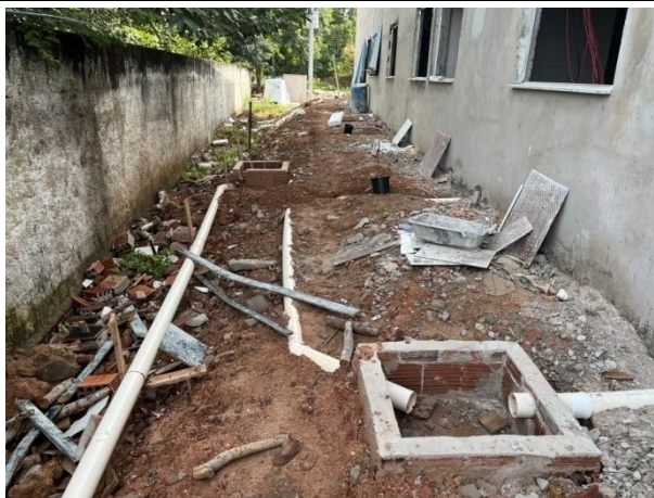
Fig. 11 – Execução de instalações pluviais
