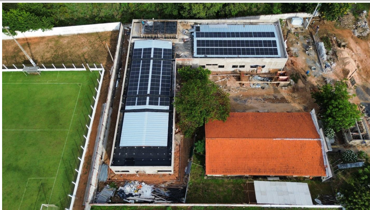
Fig. 2 – Vista aérea da obra em 29/04/2025
