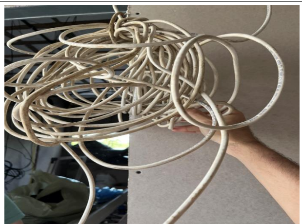
Fig. 14 – Lançamento de cabos de antena de TV
