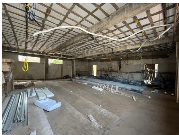
Fig. 7 – Contrapiso e instalações elétricas/climatização do Tribunal do Júri
