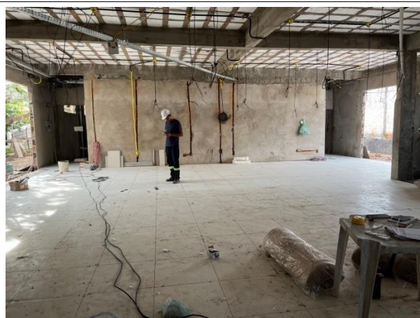
Fig. 6 – Execução de revestimento de piso e instalações
