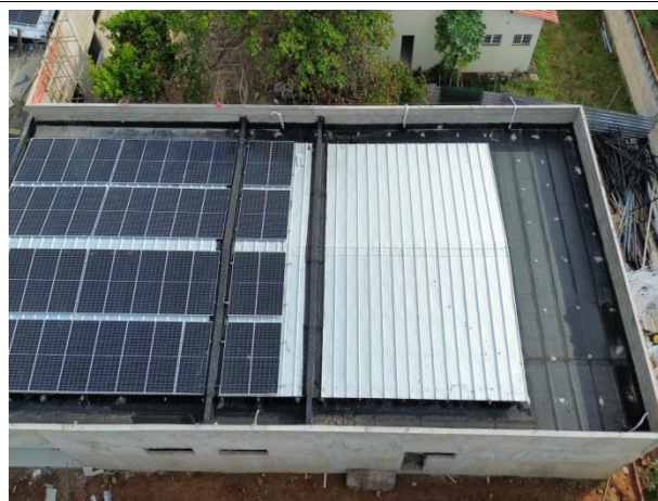
Fig. 4 – Cobertura, impermeabilização e placas fotovoltaicas
