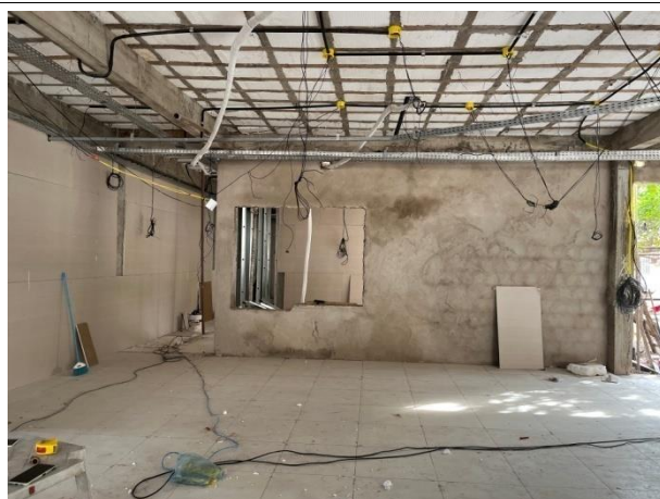
Fig. 5 – Execução de piso, parede de drywall e instalações
