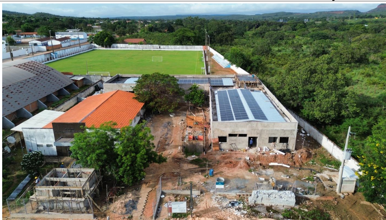
Fig. 1 – Vista aérea da obra em 29/04/2025
