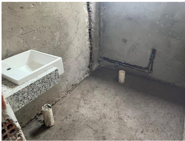
Fig. 9 – Execução de instalações hidrossanitárias
