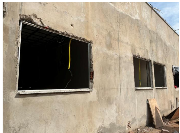
Fig. 12 – Assentamento de peitoril de granito
