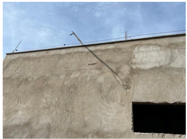
Fig. 16 – Execução de malha de captação de SPDA
