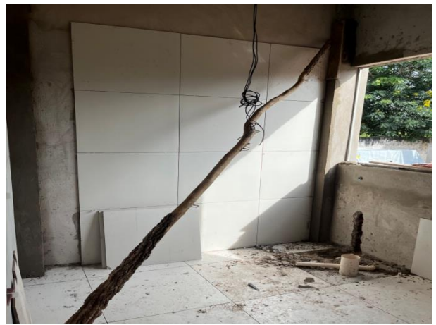
Fig. 10 – Execução de revestimentos de parede
