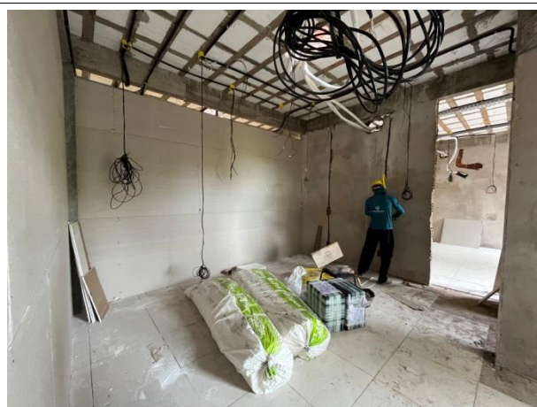
Fig. 8 – Paredes de drywall e instalações elétricas/cabeamento estruturado
