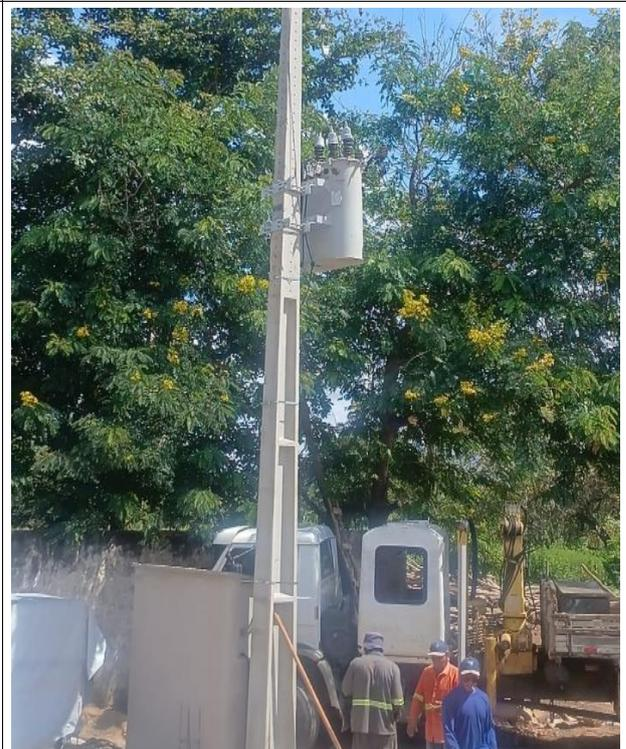
Fig. 12 – Instalação da subestação aérea.
