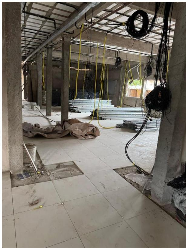
Fig. 13 – Execução de pisos cerâmicos e instalações elétricas e lógicas.
