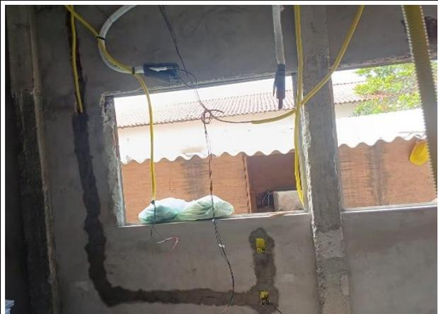
Fig. 8 – Instalações elétricas, lógicas e de climatização.
