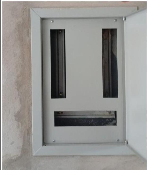
Fig. 10 – Instalações elétricas em execução. Quadro de distribuição sendo instalado.
