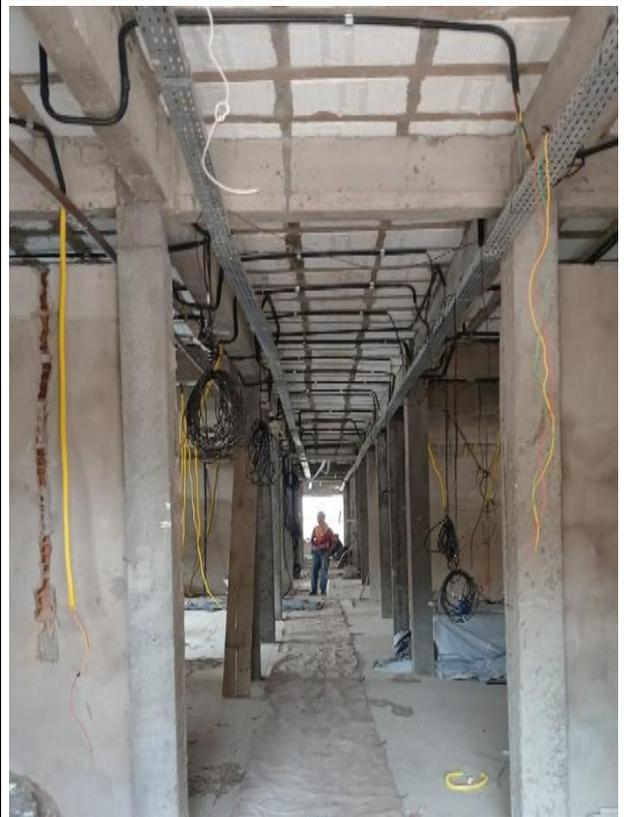
Fig. 14 – Execução de paredes, instalações elétricas e lógicas, contra-piso, cabeamento de antena de TV.
