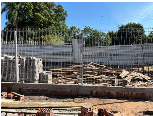
Fig. 9 – Execução de mureta e esquadrias metálicas (gradil)
