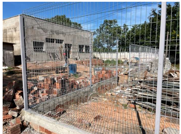
Fig. 10 – Execução de mureta e esquadrias metálicas (gradil)
