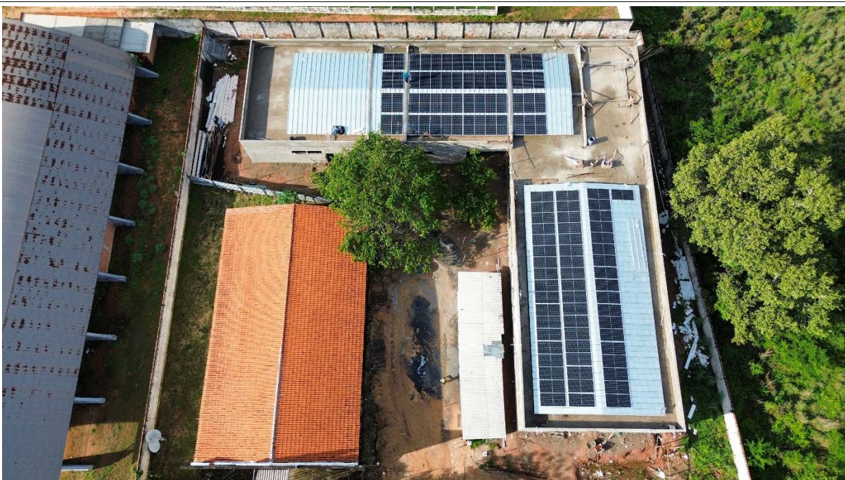
Fig. 2 – Vista aérea da obra em 26/03/2025
