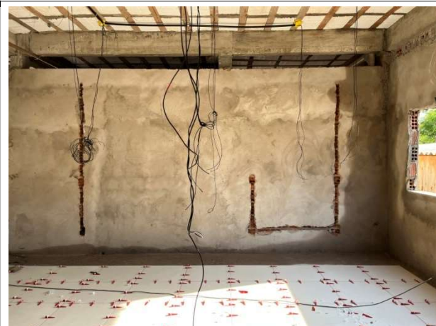
Fig. 6 – Paredes, revestimento, piso e instalações
