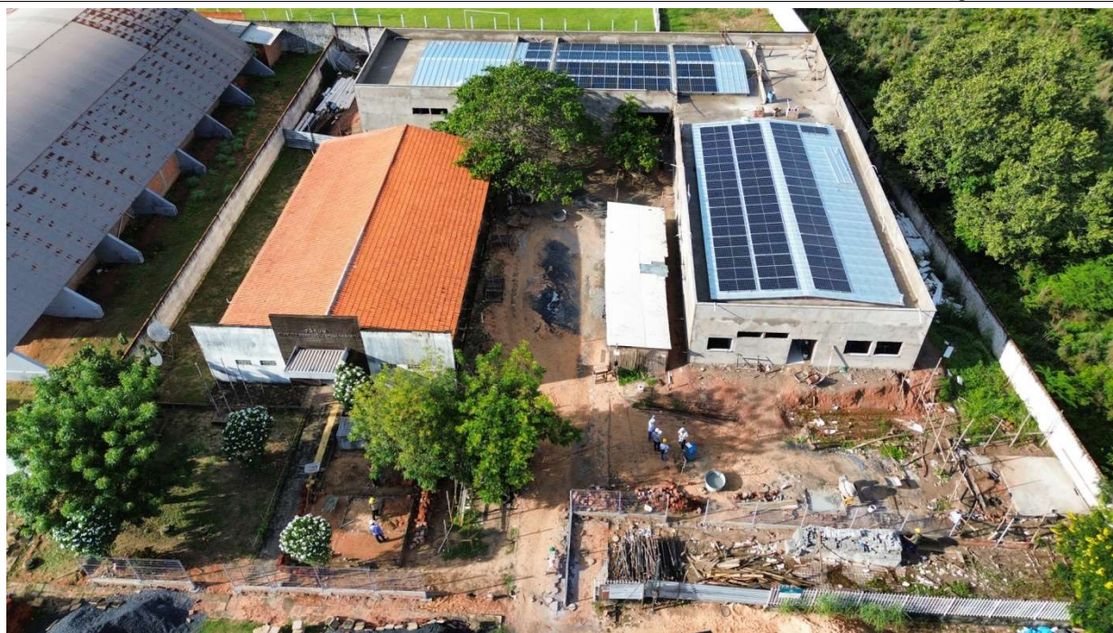
Fig. 1 – Vista aérea da obra em 26/03/2025
