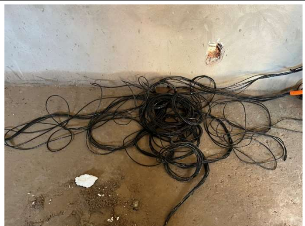
Fig. 12 – Execução de instalações de cabeamento estruturado
