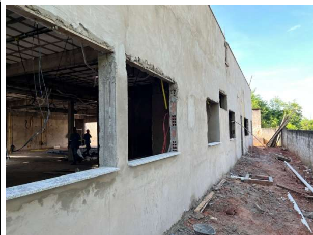
Fig. 8 – Execução de paredes e revestimentos (reboco)
