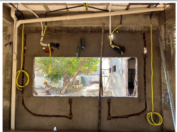
Fig. 14 – Execução de instalações elétricas e pluviais
