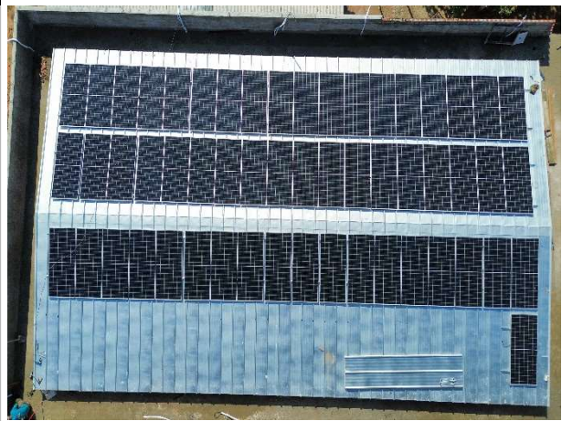
Fig. 4 – Execução de cobertura e placas fotovoltaicas
