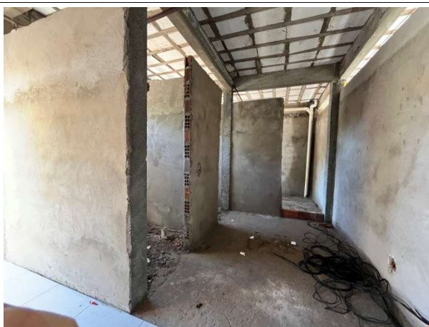
Fig. 7 – Execução de paredes e revestimentos (reboco)
