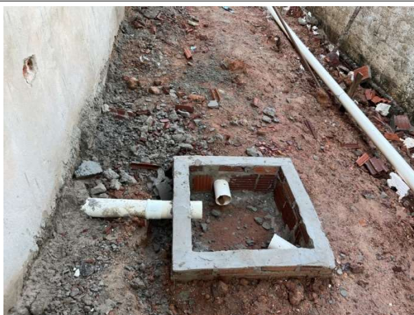
Fig. 11 – Execução de instalações hidrossanitárias
