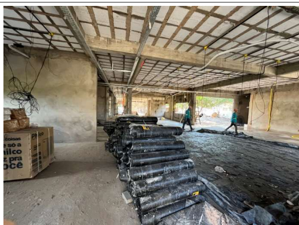
Fig. 11 – Execução de laje treliçada (superestrutura)
