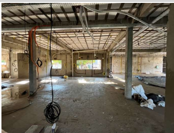
Fig. 7 – Contrapiso (pavimentação) e instalações elétricas/lógicas
