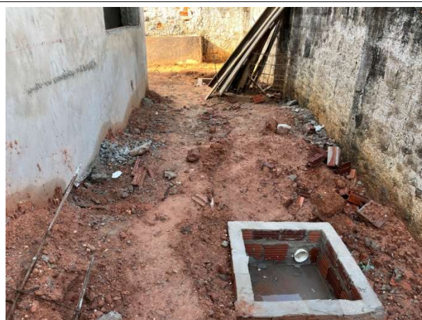
Fig. 14 – Execução de instalações hidrossanitárias
