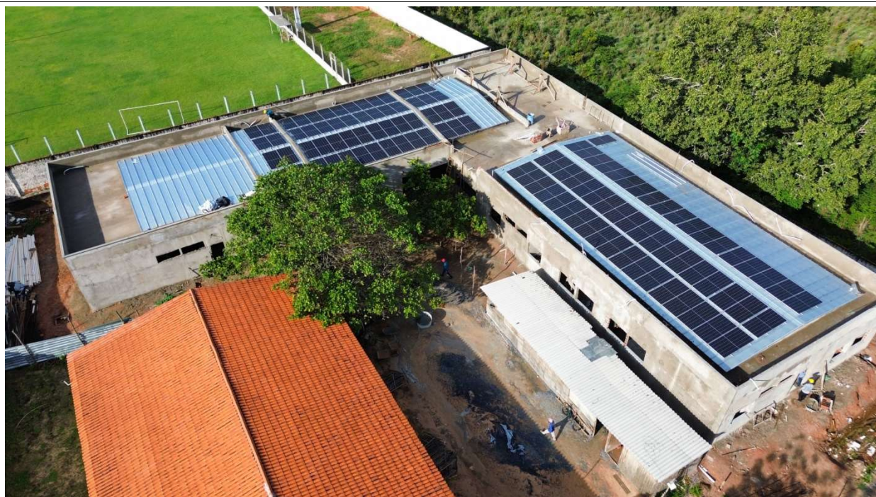
Fig. 2 – Vista aérea da obra em 26/03/2025
