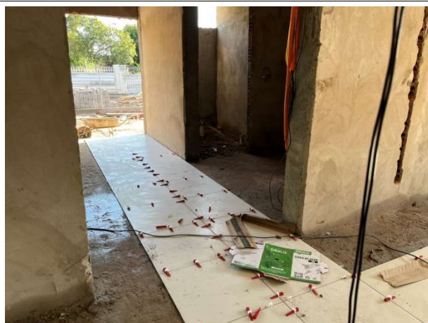
Fig. 9 – Execução de piso cerâmico
