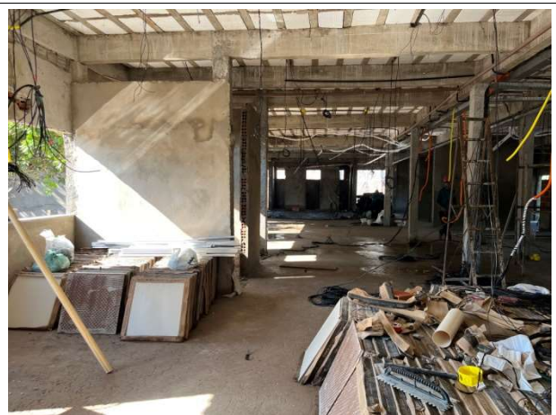
Fig. 8 – Contrapiso (pavimentação) e instalações elétricas/lógicas
