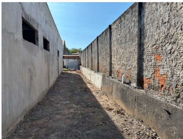
Fig. 5 – Execução de muro de arrimo (superestrutura)
