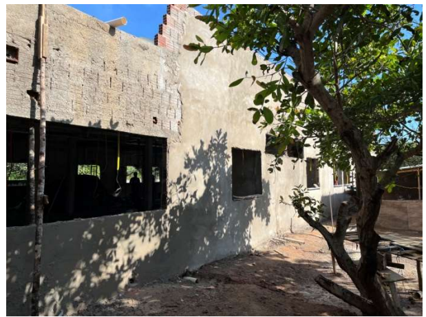
Fig. 4 – Execução de paredes e revestimentos (reboco)
