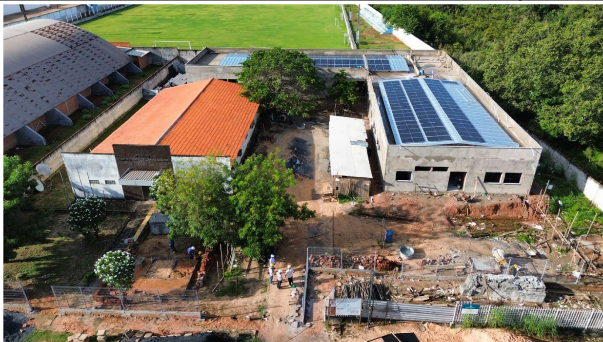
Fig. 1 – Vista aérea da obra em 26/03/2025
