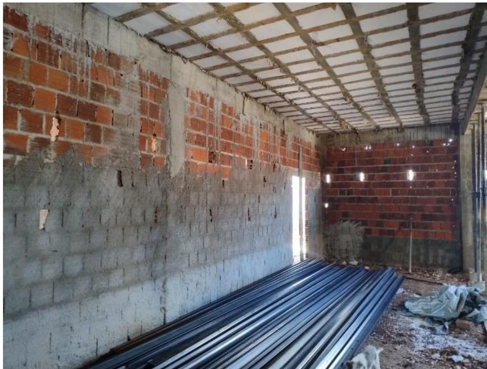
Fig. 4 – Superestrutura: Lajes, vigas e pilares executados. Paredes e painéis: alvenarias externas executadas e parcialmente chapiscadas.
