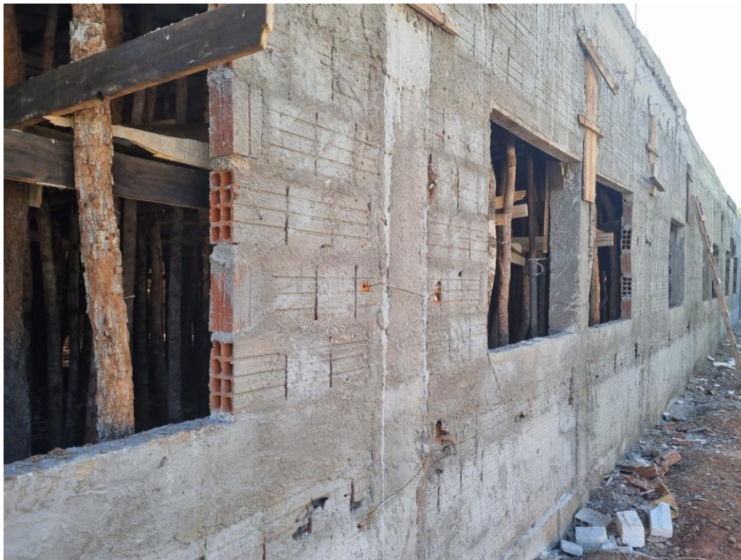
Fig. 7 – Paredes e painéis: Paredes externas executadas, vergas executadas, chapisco executado.
