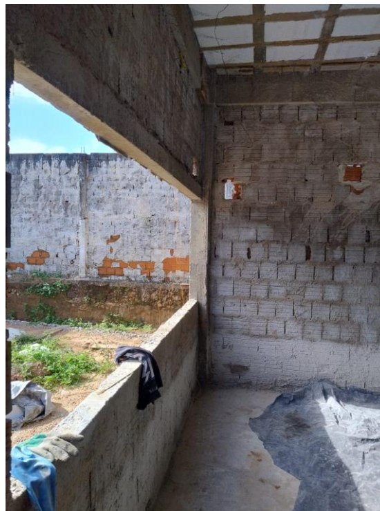
Fig. 3 – Pavimentação: Contrapiso Executado. Paredes e painéis: Paredes executadas e chapiscadas, verga da abertura executada.
