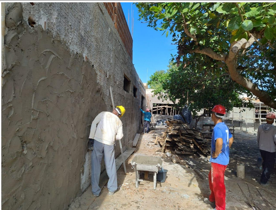
Fig. 8 – Paredes e painéis: Revestimento das paredes externas sendo executado.
