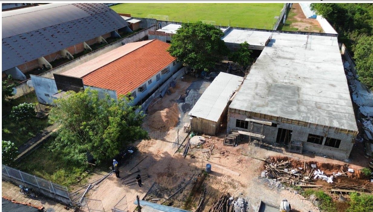
Fig. 1 –Superestrutura: Laje inteiramente concretada. Paredes e painéis: alvenarias externas executadas.
