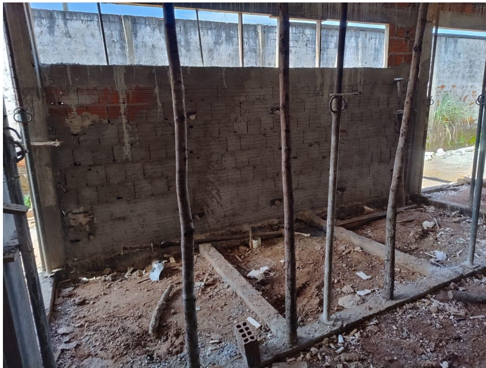
Fig. 9 – Instalações hidrossanitárias: Tubulação de esgoto enterradas.
