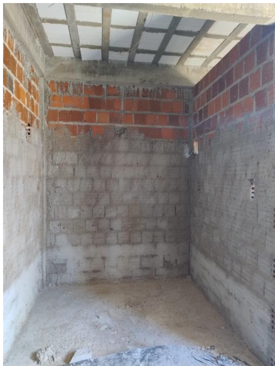
Fig. 2 – Superestrutura: Lajes e vigas executadas. Pavimentação: Contrapiso executado. Paredes e painéis: parede executada e contrapiso em execução.
