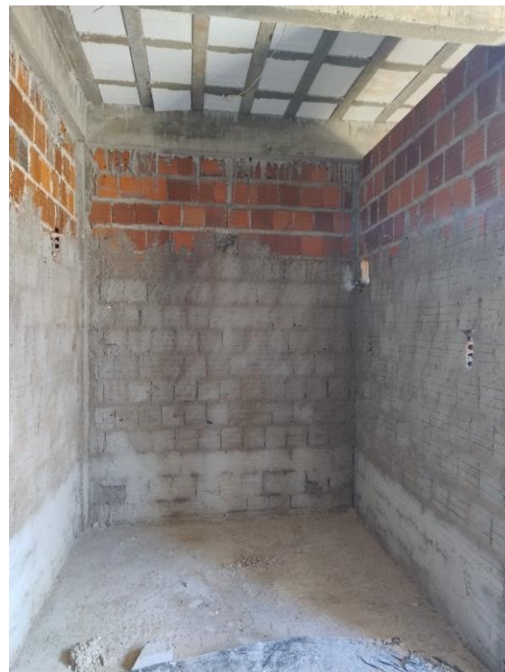
Fig. 6 – Superestrutura: Lajes e vigas executadas. Paredes e painéis: Alvenarias executadas e parcialmente chapiscadas. Pavimentação: Contrapiso executado.
