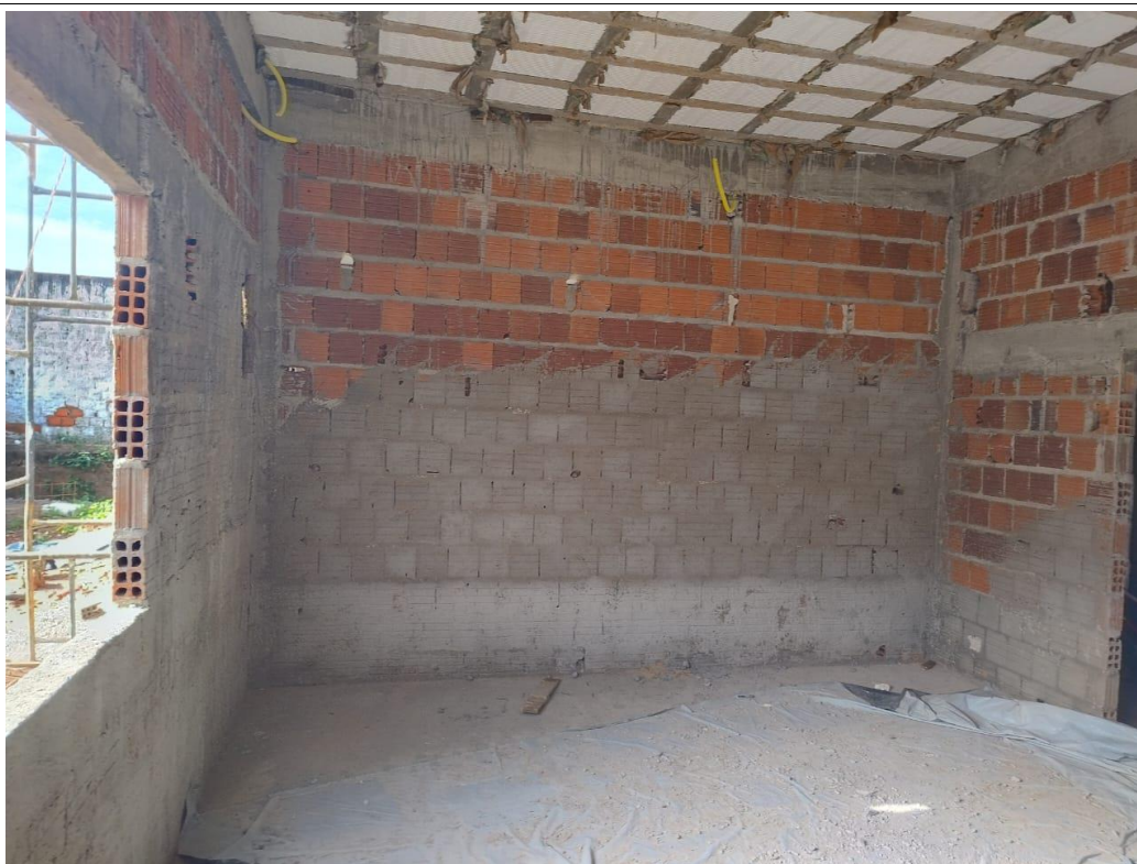
Fig. 10 – Superestrutura: Lajes e vigas executadas. Pavimentação: Contrapiso executado. Paredes e painéis: parede executada e contrapiso em execução. Instalações elétricas: Eletrodutos sendo distribuídos.
