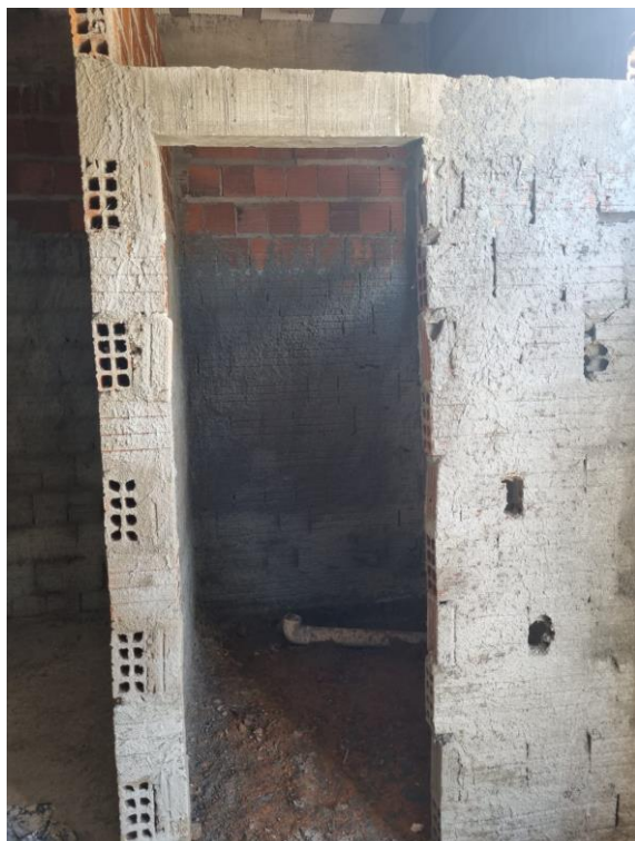
Fig. 5 – Instalações Hidrossanitárias: Instalação de esgoto posicionada. Paredes e painéis: Parede executada e chapiscada.
