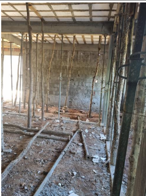
Fig. 2 – Infraestrutura: Baldrame executados. Superestrutura: Vigas e Lajes concretadas.
