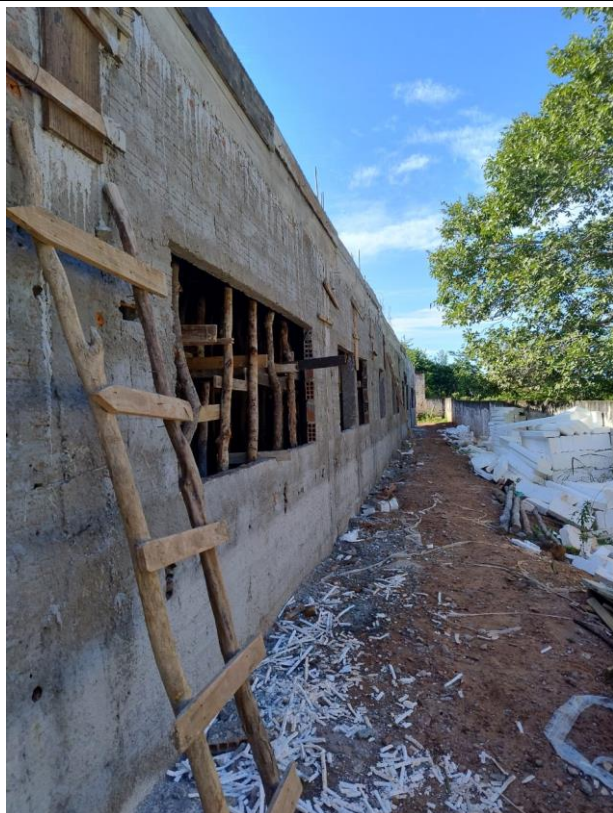
Fig. 7 – Paredes e painéis: Paredes executadas e chapiscadas.
