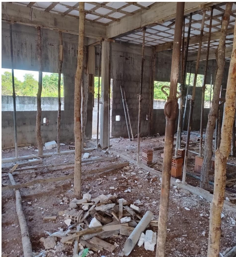
Fig. 1 – Superestrutura: Lajes concretadas e escoradas. Infraestrutura: Baldrame executados.
