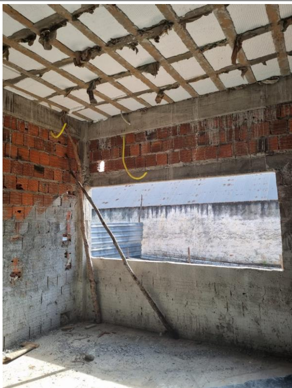
Fig. 5 – Paredes e painéis: Paredes externas executadas e parcialmente chapiscadas. Superestrutura: Lajes e vigas executadas.
