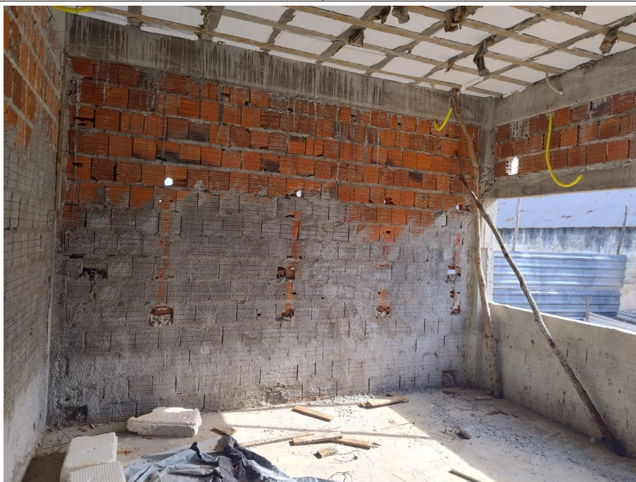
Fig. 9 – Superestrutura: Lajes concretadas e já com retirada de escoras. Paredes e painéis: Alvenarias executadas e parcialmente chapiscadas.
