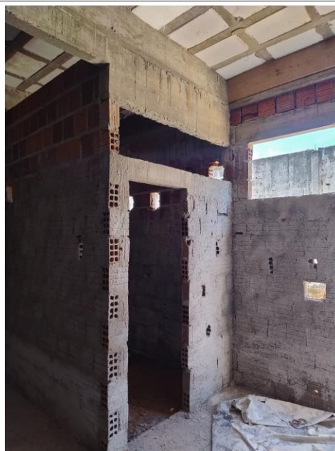
Fig. 3 – Paredes e painéis: Alvenarias executadas e chapiscadas.
