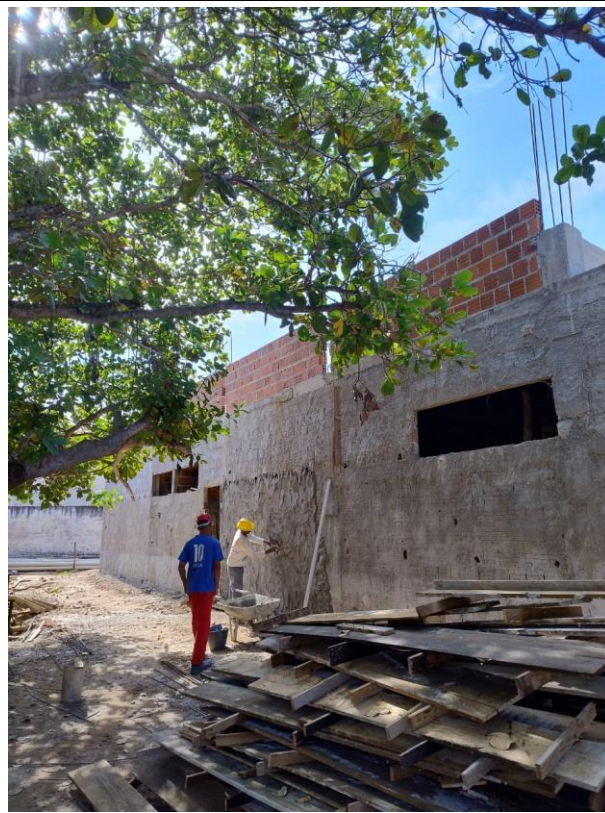
Fig. 8 – Paredes e painéis: Paredes executadas e chapiscadas e platibanda sendo executada.
