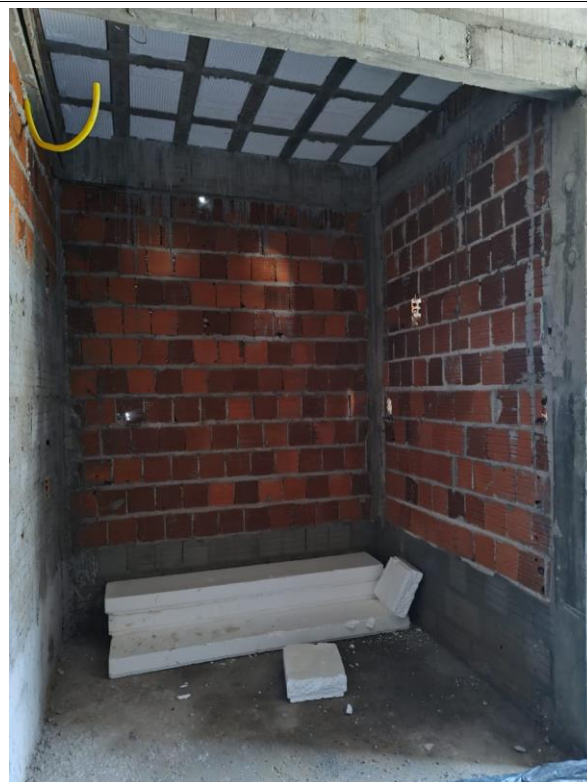
Fig. 6 – Paredes e painéis: Paredes executadas. Superestrutura: Vigas, lajes e pilares executados
