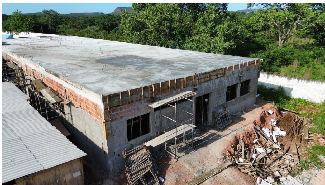
Fig. 4 – Superestrutura: Lajes e vigas concretadas. Infraestrutura: Aterro executado.
