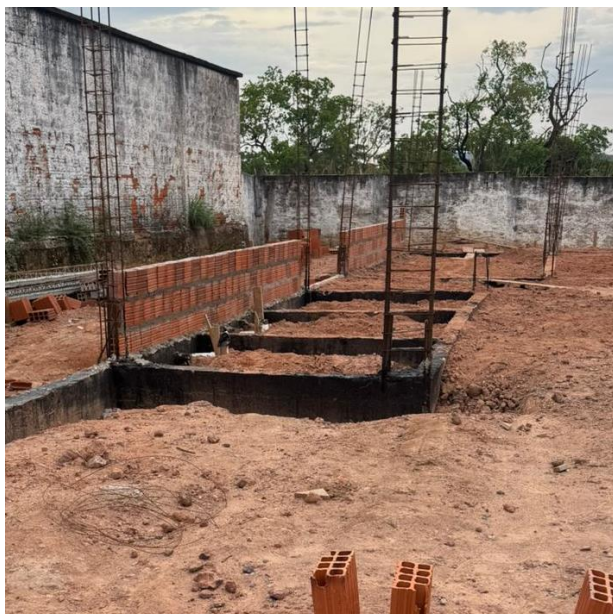
Fig. 2 – Impermeabilização de vigas baldrame.
