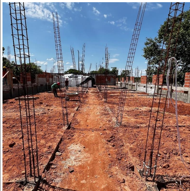
Fig. 3 – Execução de vigas baldrame.
