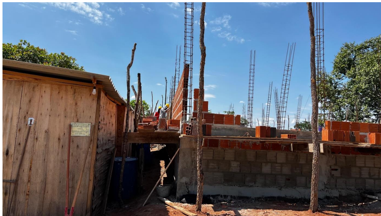
Fig. 4 – Execução de alvenaria de vedação e pilares.
