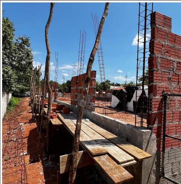
Fig. 4 – Execução de alvenaria de vedação e pilares.
