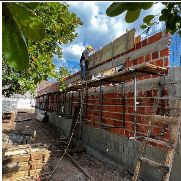
Fig. 4 – Execução de alvenaria de vedação e pilares.
