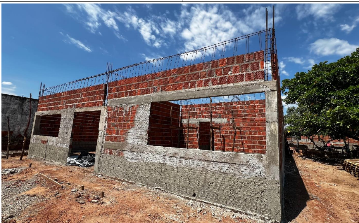
Fig. 7 – Execução de pilares e vigas.
