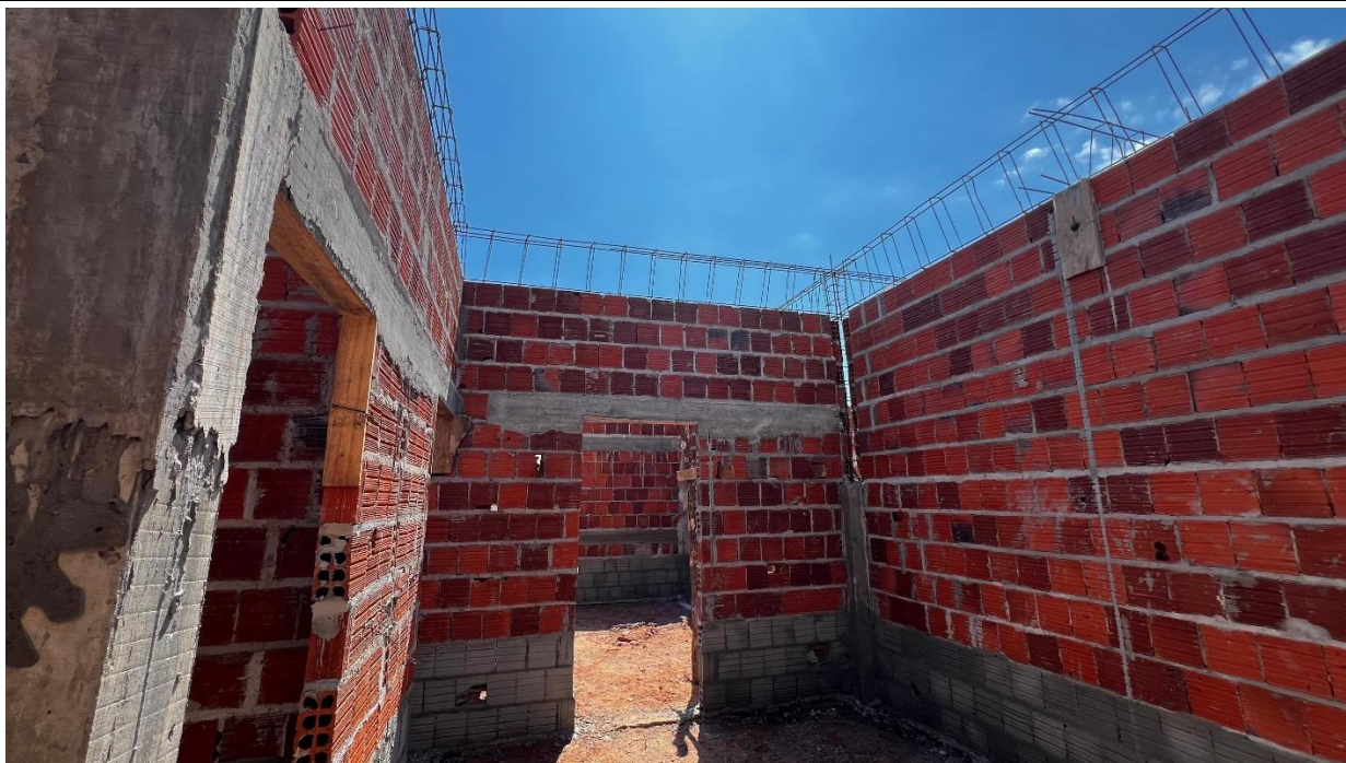
Fig. 10 – Armação para vigas.
