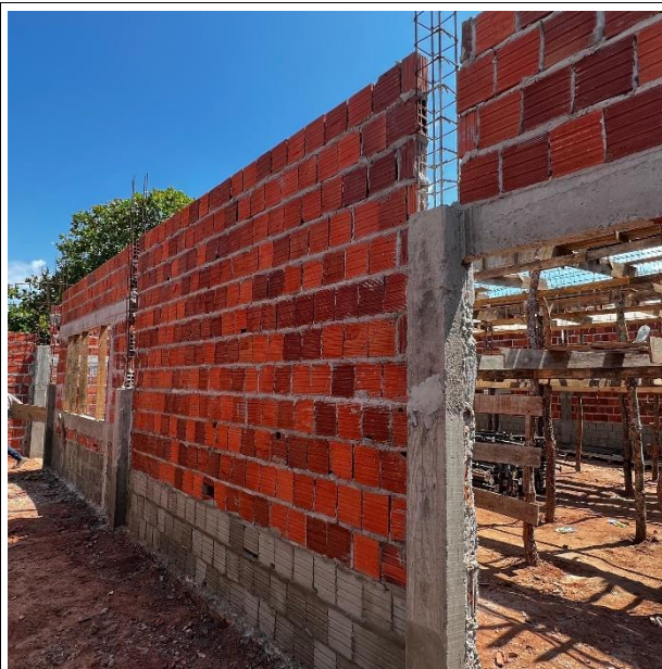
Fig. 8 – Execução de alvenaria de vedação.
