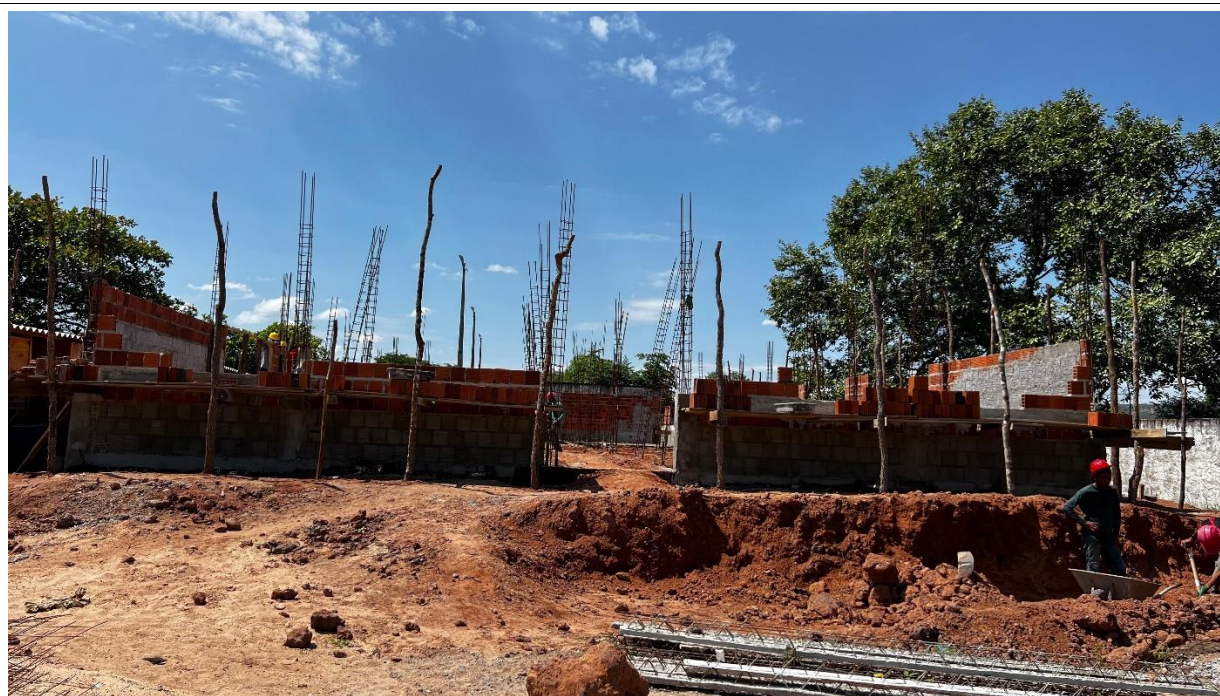
Fig. 1 – Alvenaria de vedação e movimento de terra.
