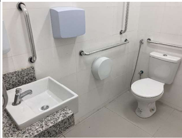
Fig. 9 – Instalações hidrossanitárias e revestimentos
