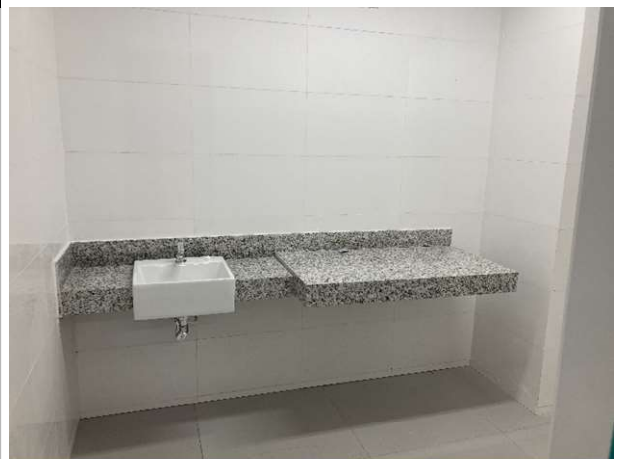
Fig. 12 – Instalações hidrossanitárias e revestimentos
