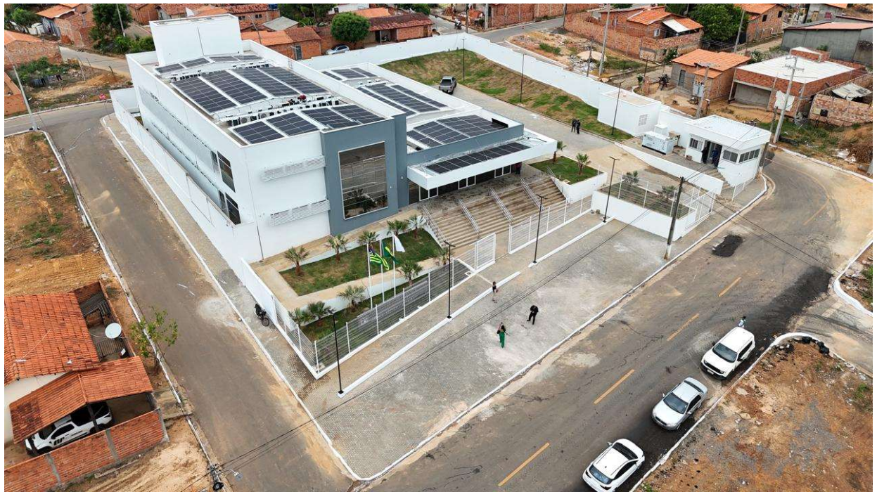
Fig. 1 – Vista aérea da obra
