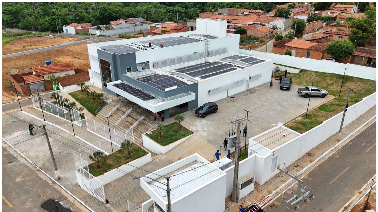
Fig. 2 – Vista aérea da obra
