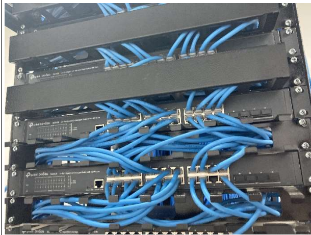
Fig. 15 – Cabeamento estruturado (instalação de lógica)
