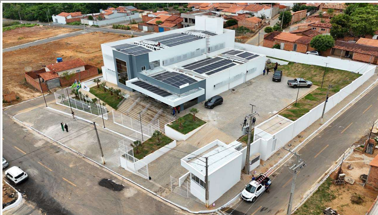
Fig. 1 – Vista aérea da obra
