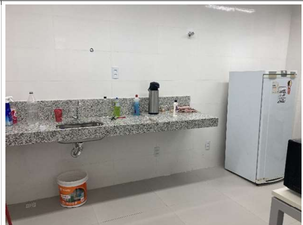
Fig. 12 – Instalações hidrossanitárias e revestimentos
