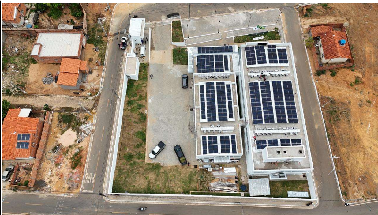
Fig. 2 – Vista aérea da obra
