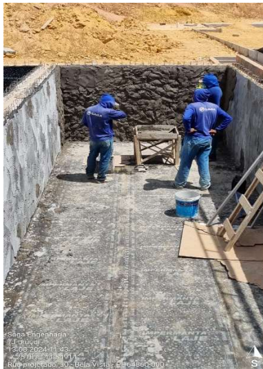
Fig. 5 – 6.0 IMPERMEABILIZAÇÃO
