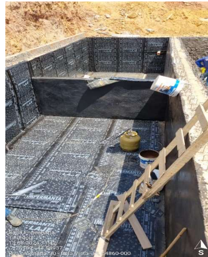
Fig. 6 – 6.0 IMPERMEABILIZAÇÃO
