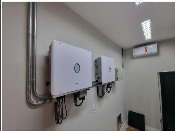
Fig. 9 – Inversores fotovoltaicos
