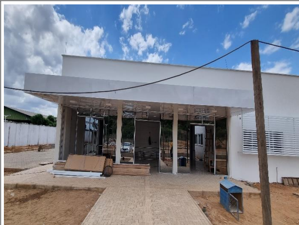
Fig. 4 – Marquise/Esquadrias de Vidro/Paredes
