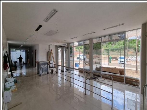
Fig. 12 – Piso/Forro/Esquadrias/Controle de Acesso
