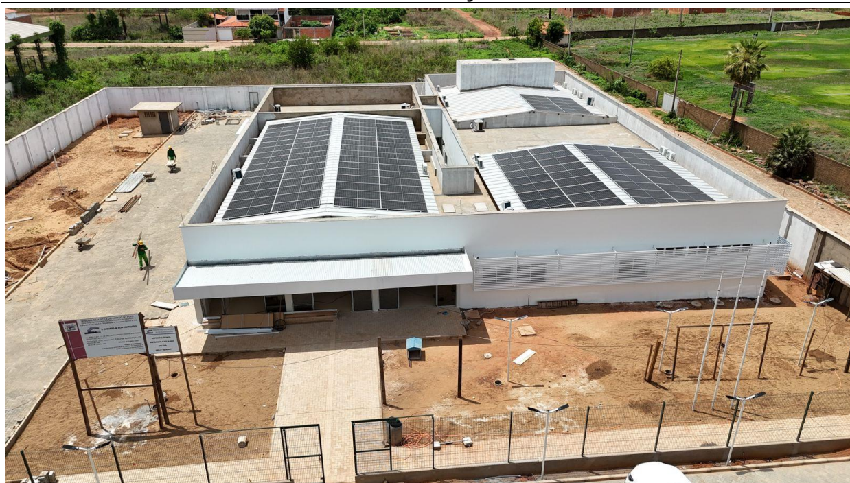
Fig. 1 – Vista aérea da obra
