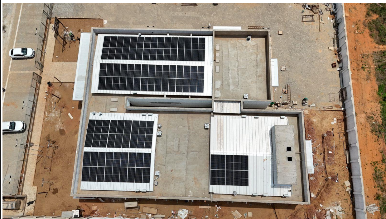
Fig. 2 – Vista aérea da obra
