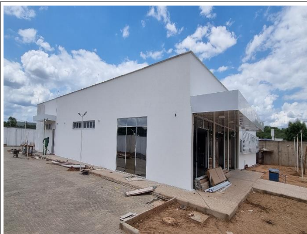
Fig. 4 – Marquise/Esquadrias de Vidro/Paredes
