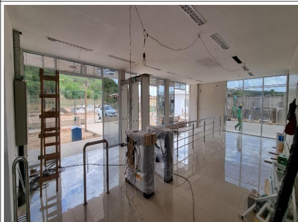
Fig. 12 – Piso/Forro/Esquadrias/Controle de Acesso
