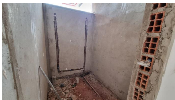
Fig. 10 – Instalações hidrossanitárias
