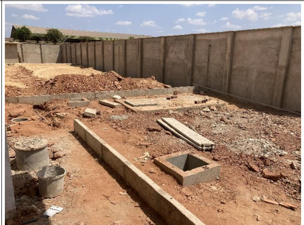
Fig. 14 – Execução de meio fio/Instalações sanitárias
