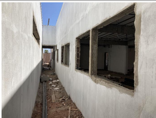
Fig. 5 – Superestrutura/Paredes/Revestimentos/Emassamento
