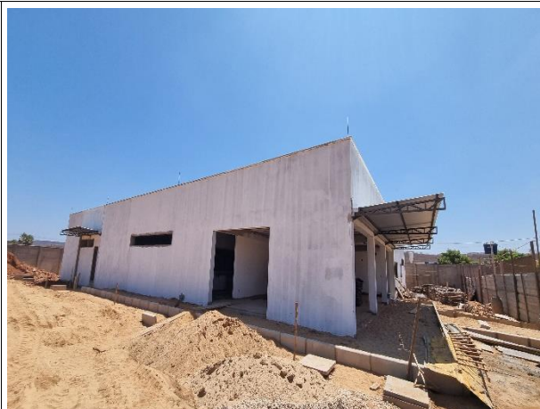
Fig. 10 – Execução de coberturas metálicas
