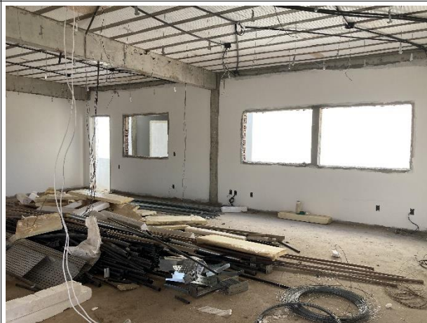
Fig. 8 – Execução de instalações e emassamento
