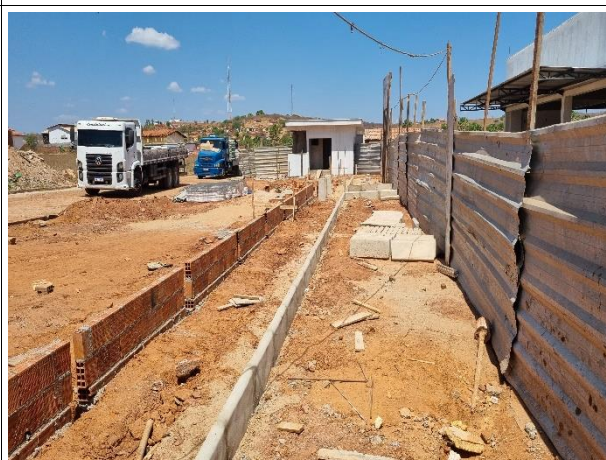
Fig. 14 – Execução de meio fio
