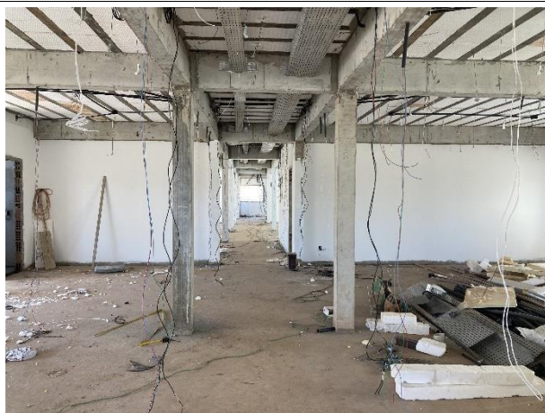
Fig. 7 – Execução de instalações e emassamento
