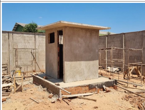
Fig. 12 – Casa de bombas
