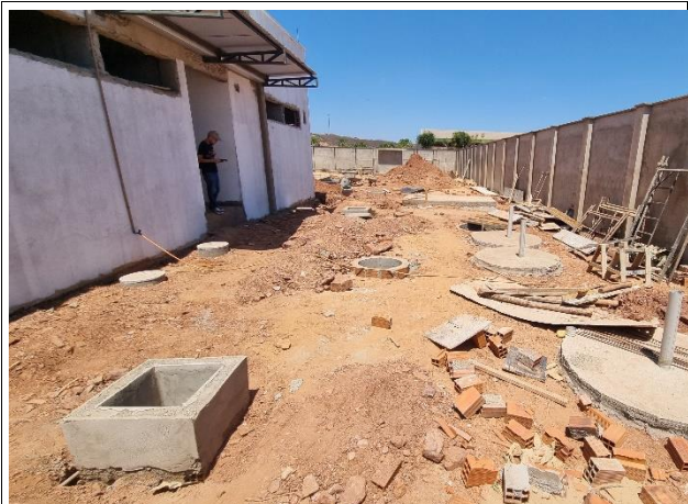
Fig. 15 – Execução de instalações sanitárias
