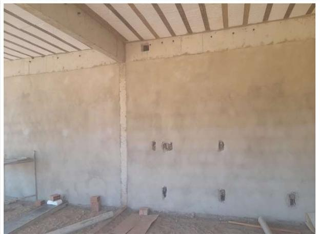
Fig. 12 – Execução de revestimentos e instalações
