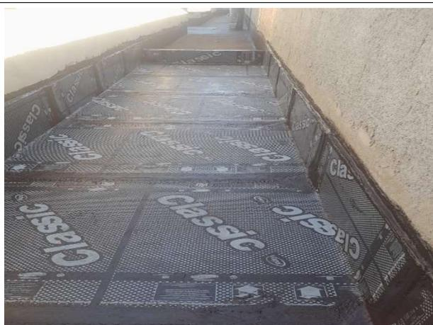
Fig. 19 – Impermeabilização de calhas pluviais
