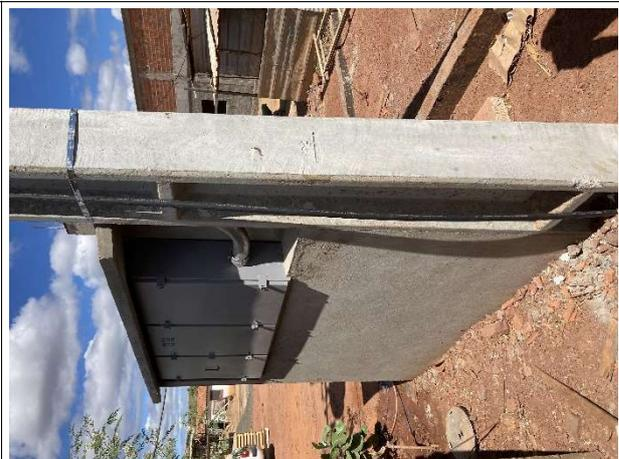
Fig. 8 – Entrada de medição de energia
