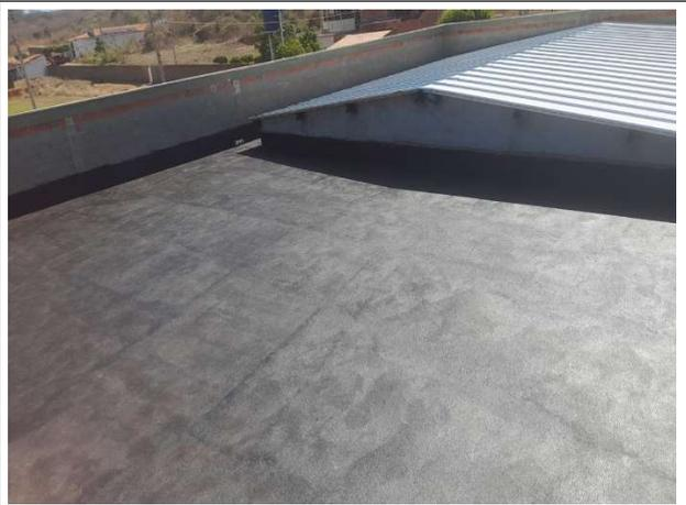
Fig. 18 – Impermeabilização da cobertura
