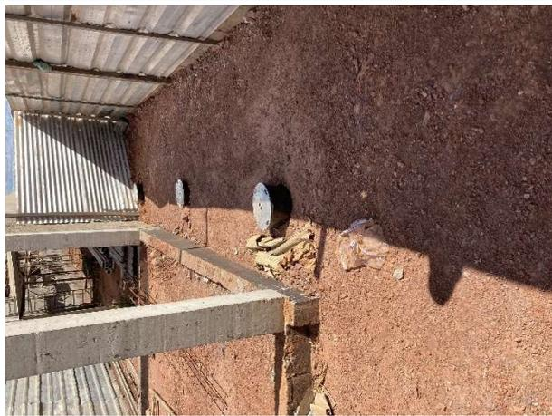
Fig. 9 – Execução de malha de aterramento
