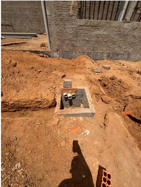
Fig. 11 – Caixa de instalações pluviais
