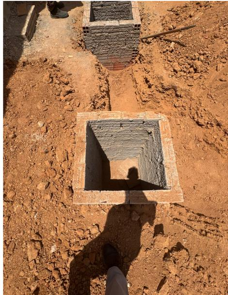
Fig. 12 – Caixa de instalações pluviais
