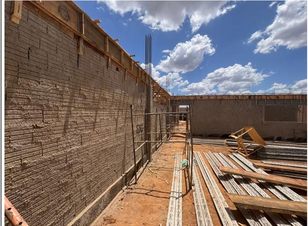
Fig. 8 – Alvenaria e superestrutura
