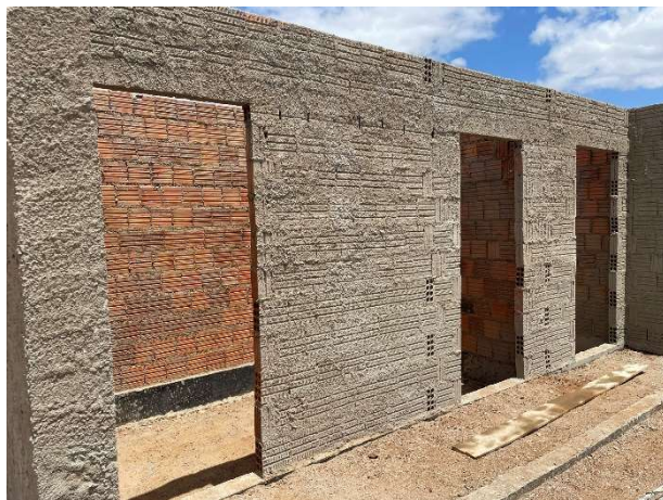
Fig. 3 – (3.0 Paredes e Painéis)
