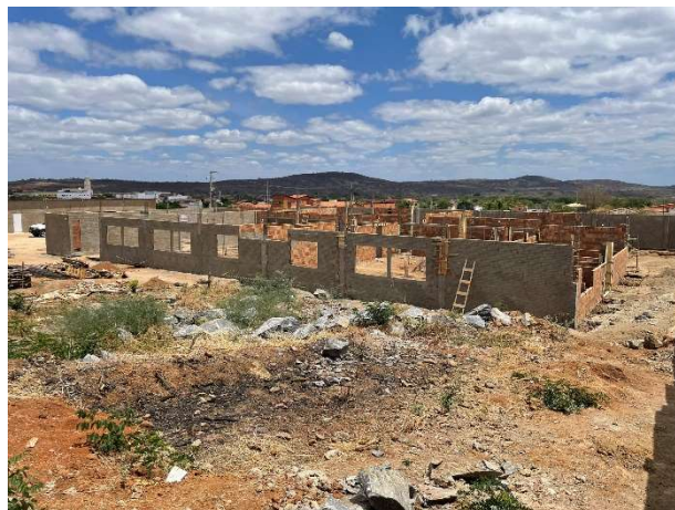
Fig. 4 – (3.0 Paredes e Painéis)
