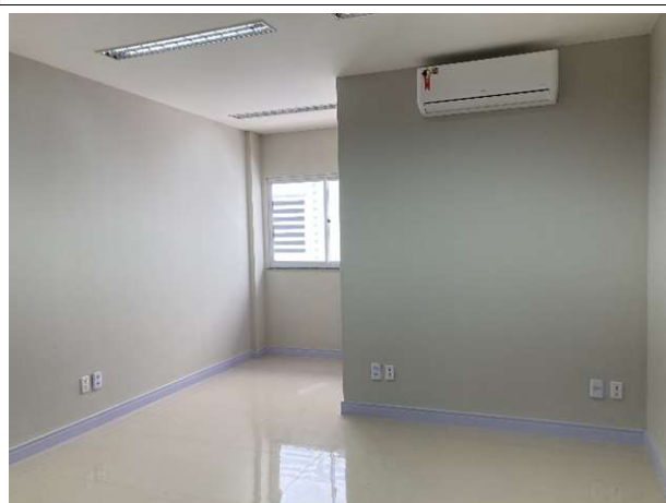
Fig. 8 – ar condicionado, pintura e instalações elétricas
