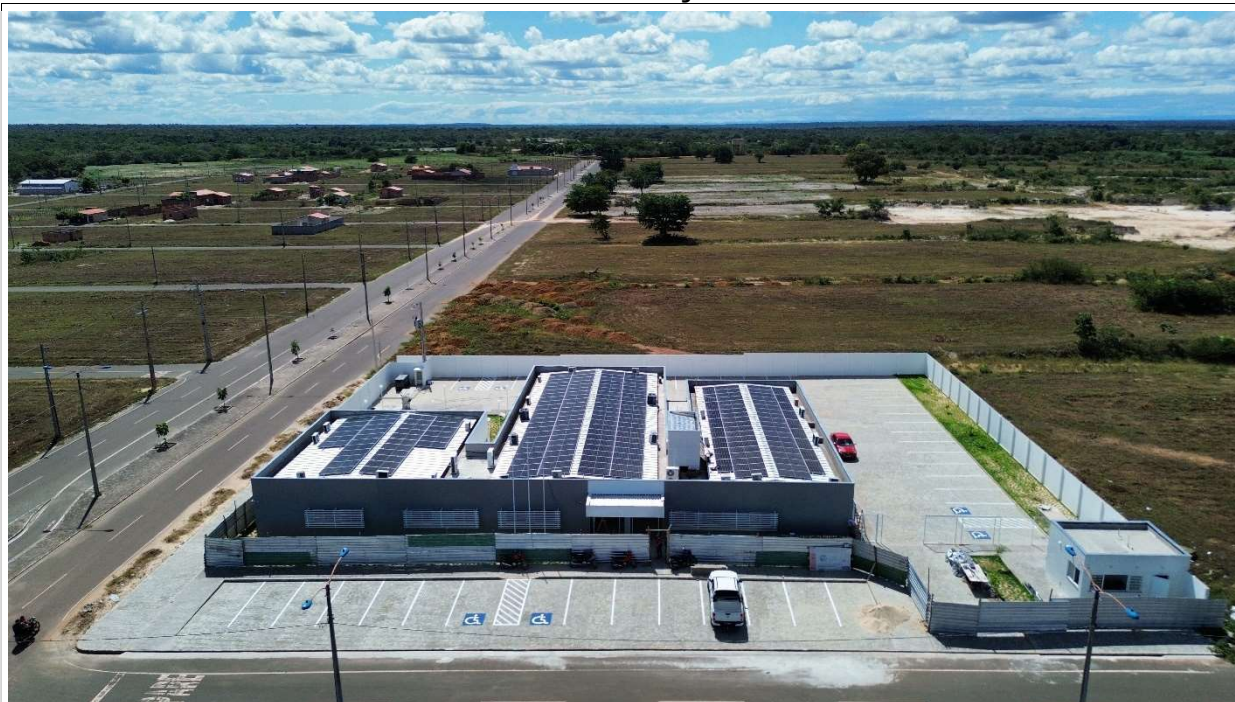
Fig. 1 – Vista aérea da obra
