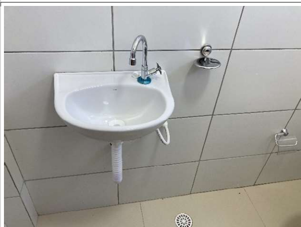
Fig. 11 – revestimentos e instalações hidrossanitárias
