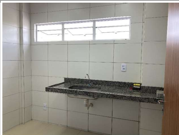
Fig. 9 – revestimentos e instalações hidrossanitárias
