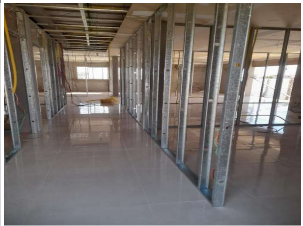
Fig. 4 – piso e perfis das paredes de drywall
