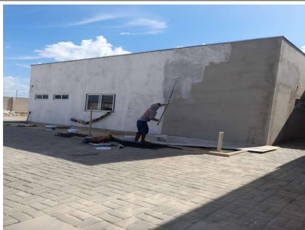
Fig. 5 – pintura da fachada e pavimento intertravado
