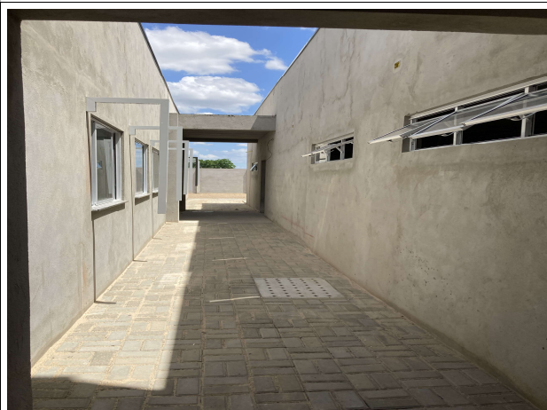
Fig. 14 – execução de calçada e esquadrias
