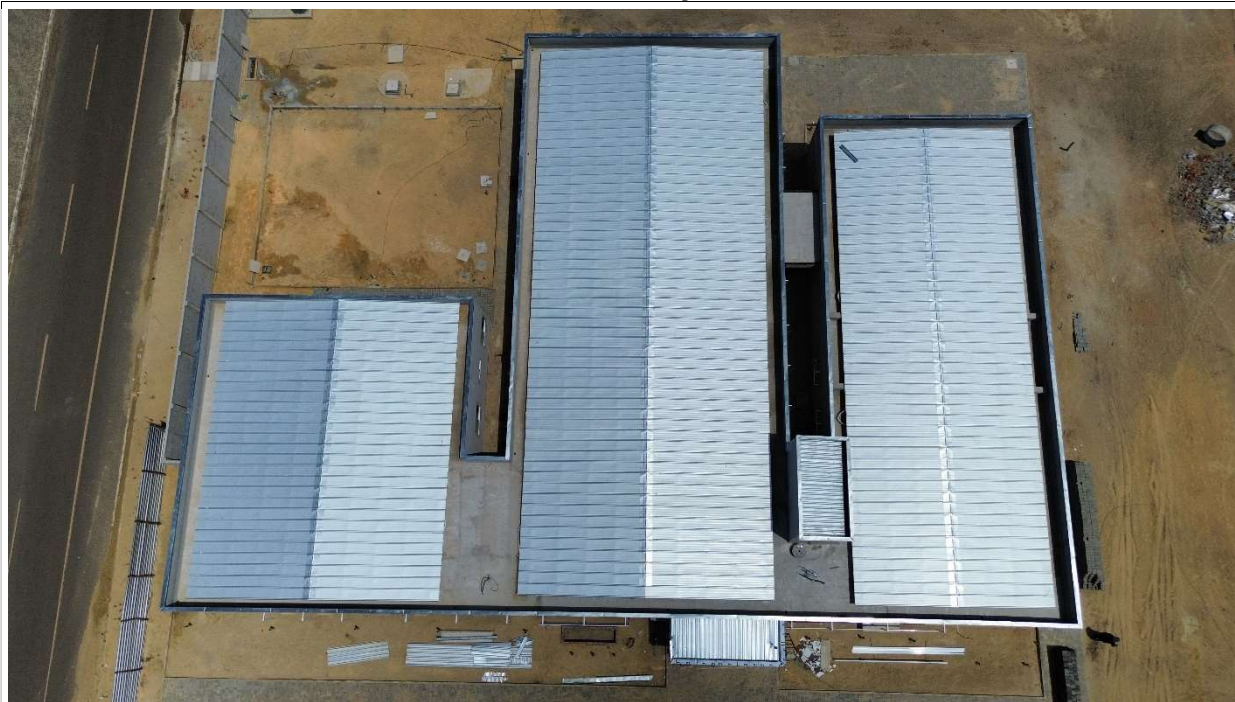
Fig. 1 – Execução de impermeabilização/superestrutura/cobertura
