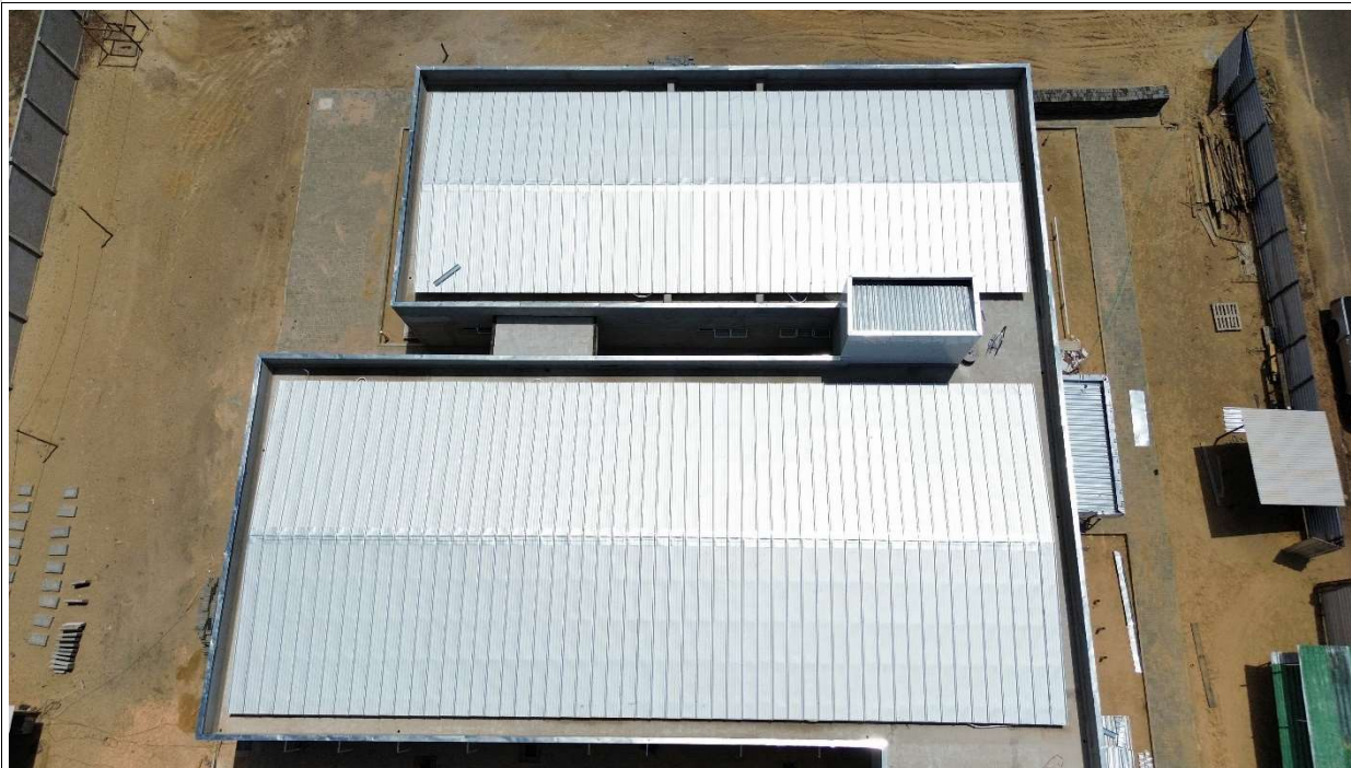
Fig. 2 – Execução de impermeabilização/superestrutura/cobertura
