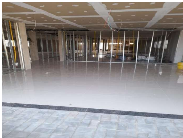
Fig. 3 – execução de instalações, forro e piso
