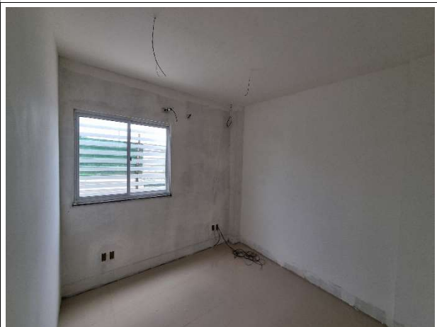
Fig. 8 – paredes, forro e instalações elétricas
