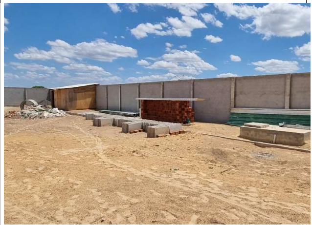
Fig. 10 – movimentação de terra para pavimentação
