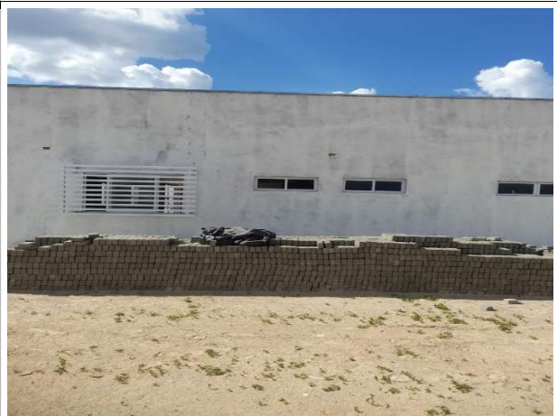
Fig. 6 – esquadrias e emassamento da fachada
