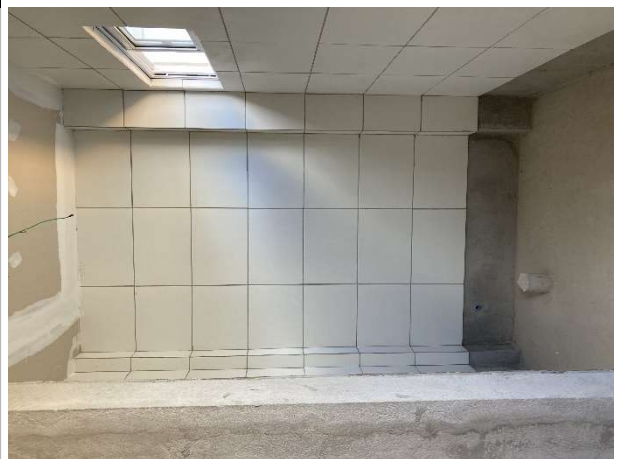
Fig. 12 – revestimento e instalações hidrossanitárias
