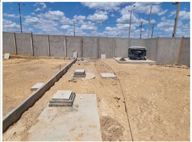
Fig. 10 – execução de instalações hidrossanitárias
