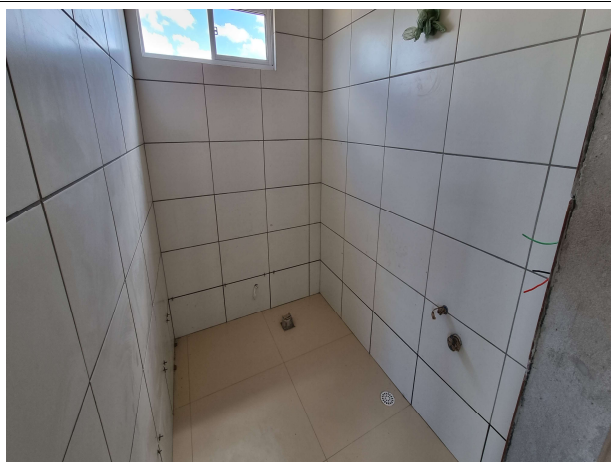
Fig. 15 – execução de revestimentos e instalações sanitárias
