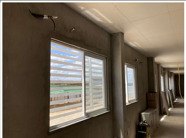
Fig. 12 – execução de instalações de ar condicionado
