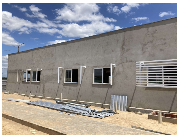
Fig. 7 – execução de brise e esquadrias
