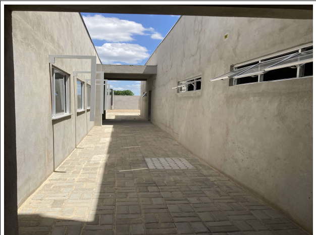
Fig. 14 – execução de calçada e esquadrias
