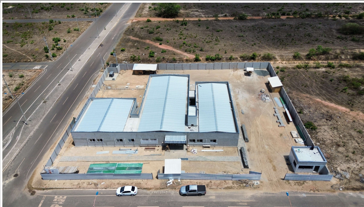
Fig. 1 – Vista aérea da obra
