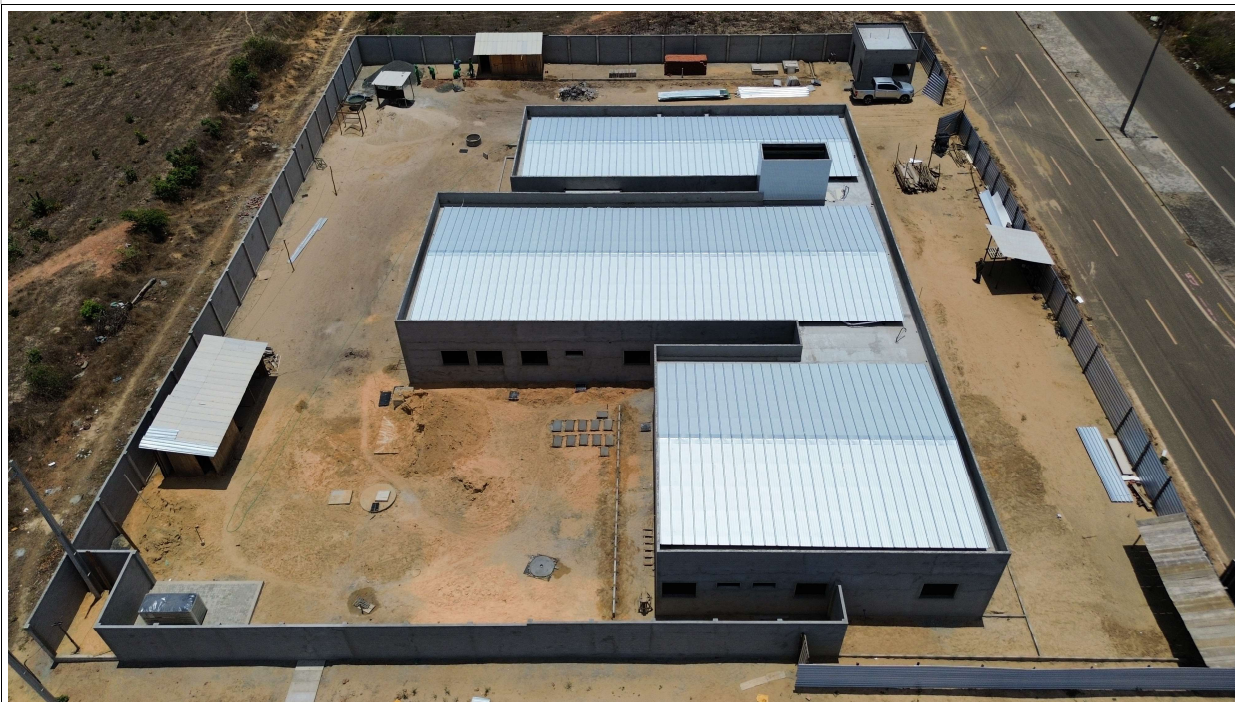
Fig. 2 – Vista aérea da obra
