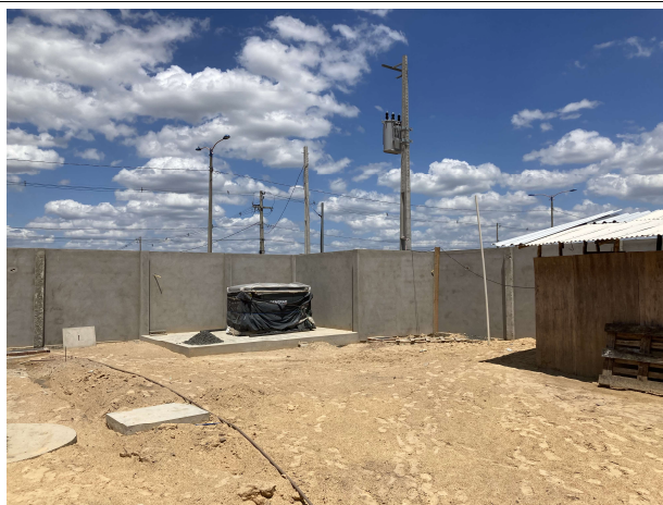
Fig. 11 – execução de subestação e gerador
