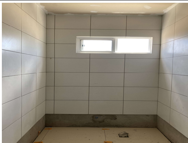
Fig. 13 – execução de revestimentos, forro e piso
