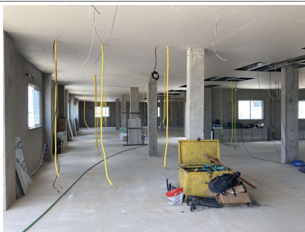
Fig. 5 – execução de forro, instalações elétricas e lógicas
