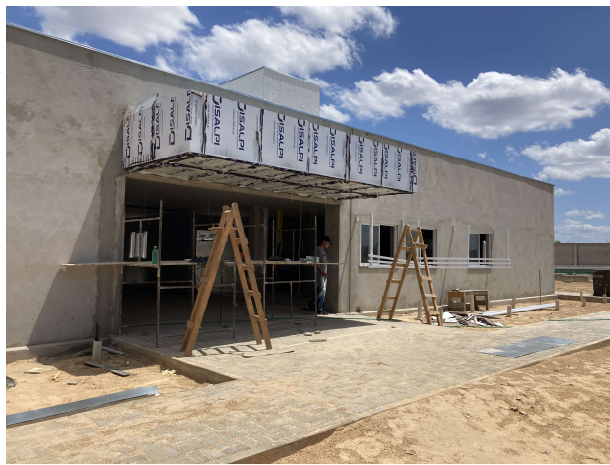
Fig. 3 – brise e esquadrias da fachada frontal
