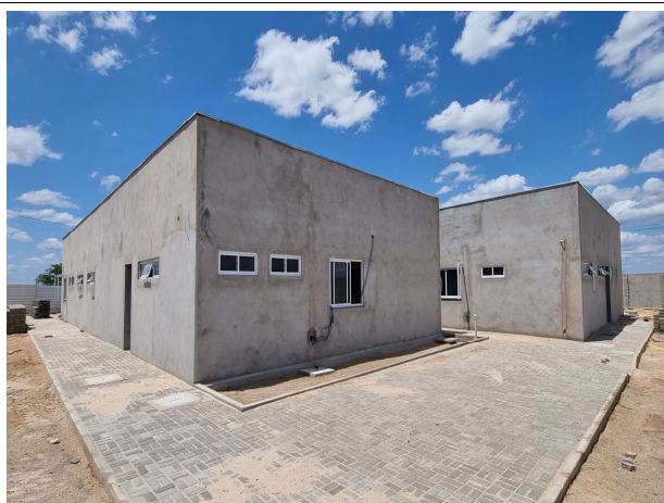
Fig. 17 – execução de calçada
