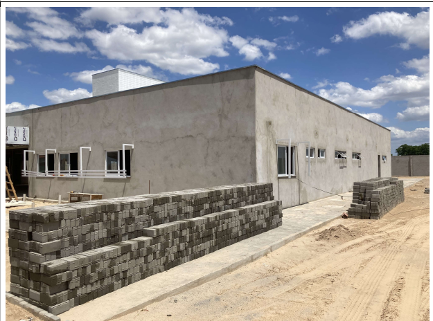
Fig. 6 – calçada e pavimento intertravado
