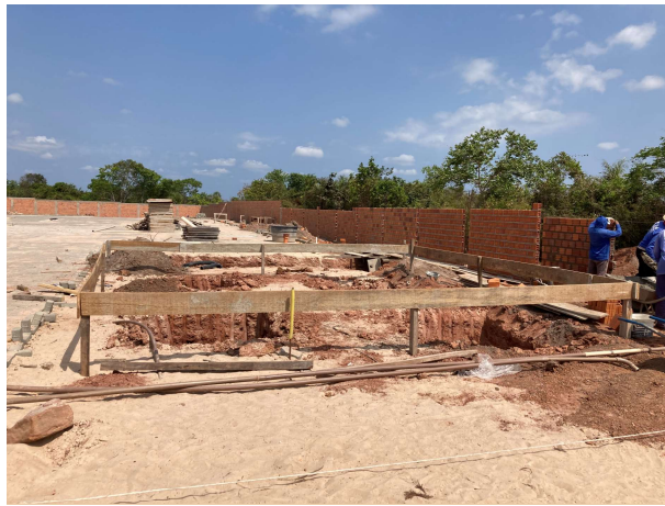
Fig. 13 – locação da guarita
