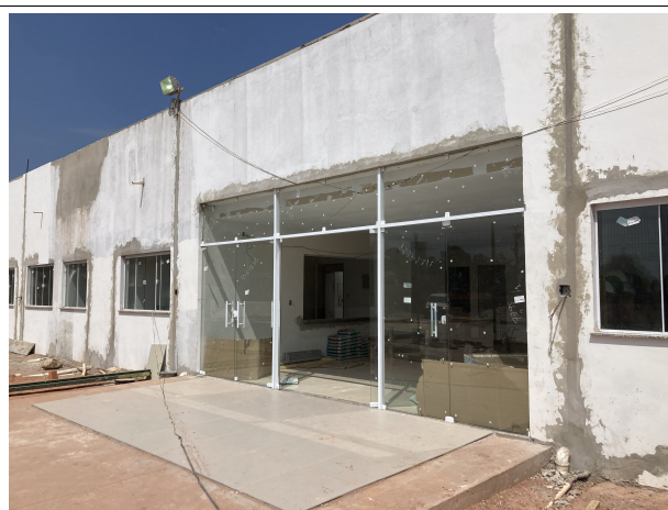
Fig. 2 – esquadrias da entrada do Fórum
