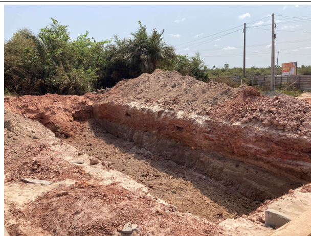
Fig. 4 – escavações da cisterna
