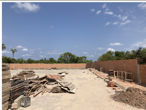
Fig. 3 – execução do muro de arrimo
