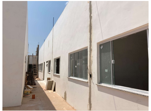
Fig. 14 – execução de pintura e esquadrias
