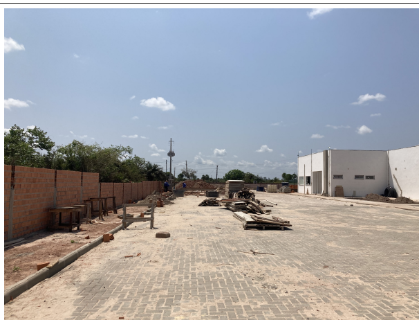
Fig. 11 – execução de pavimento intertravado
