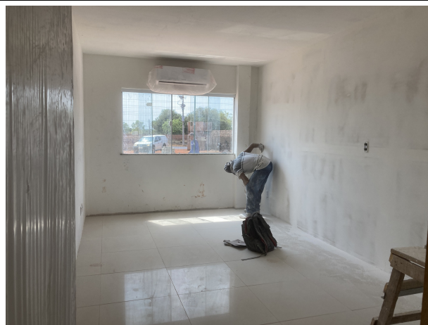
Fig. 6 – execução de pintura
