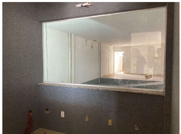
Fig. 10 – execução de carpete e esquadrias
