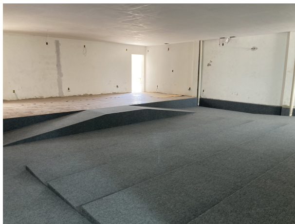
Fig. 9 – execução de carpete e piso vinílico
