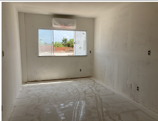
Fig. 7 – execução de pintura e instalações
