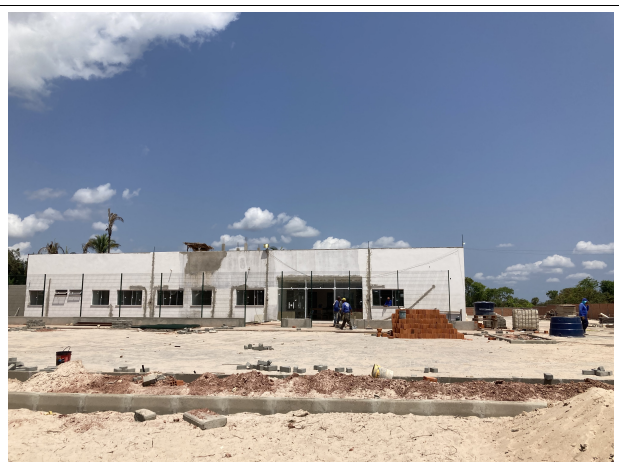
Fig. 12 – instalação do gradil
