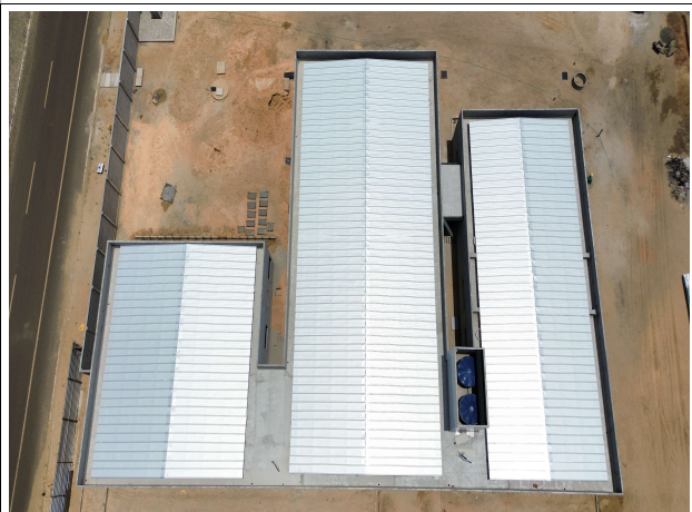
Fig. 8 – execução de cobertura e reservatórios
