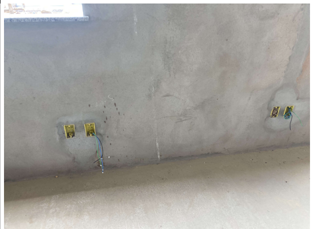
Fig. 12 – execução de instalações elétricas
