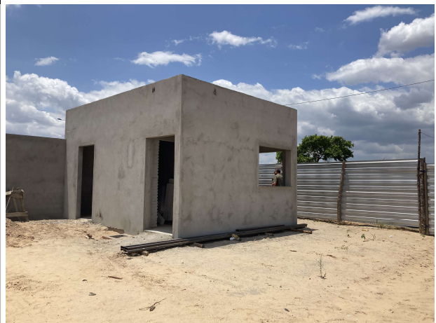
Fig. 4 – construção da guarita
