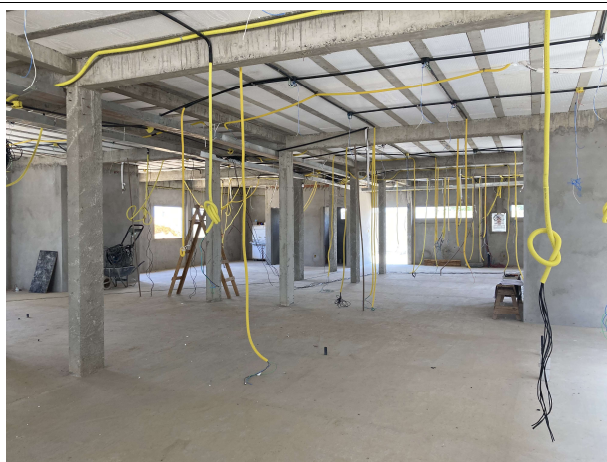
Fig. 5 – execução de instalações elétricas e lógicas
