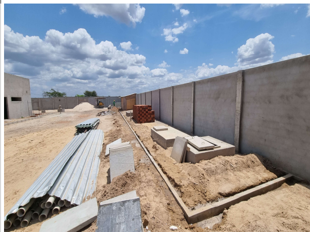
Fig. 11 – execução de cisterna
