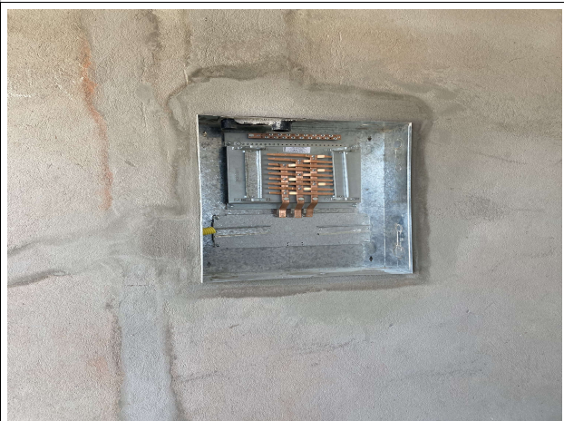
Fig. 14 – execução de instalações elétricas
