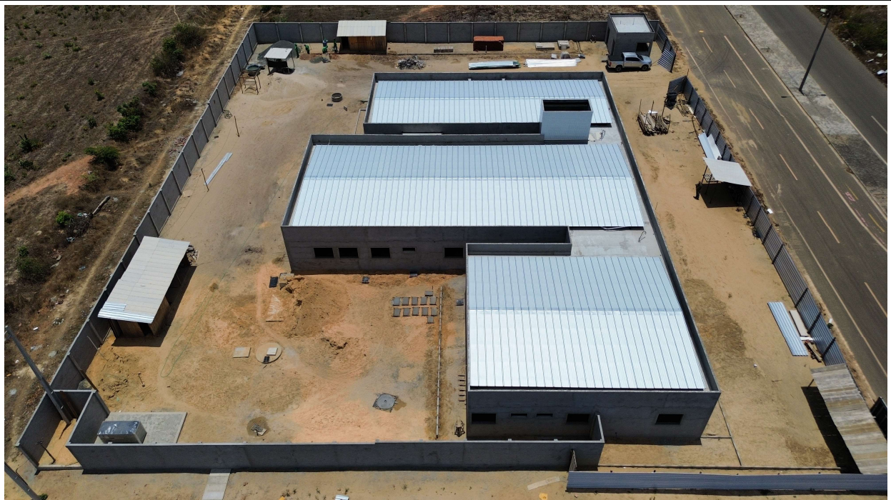
Fig. 2 – Vista aérea da obra
