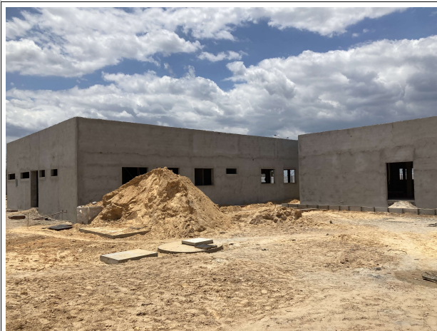
Fig. 13 – execução de reboco externo
