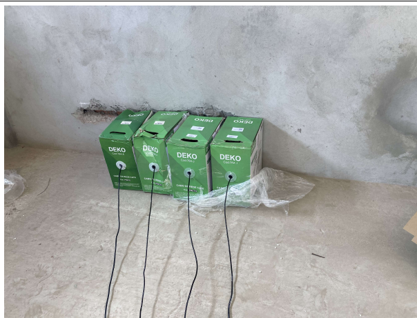
Fig. 17 – execução de instalações lógicas
