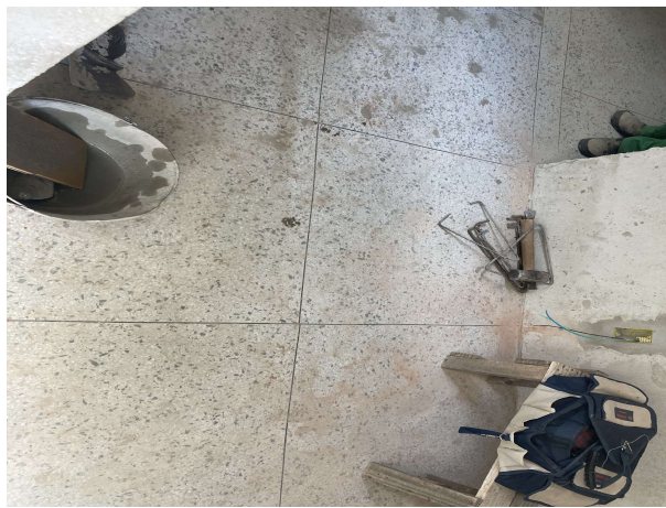
Fig. 15 – execução de piso em granilite
