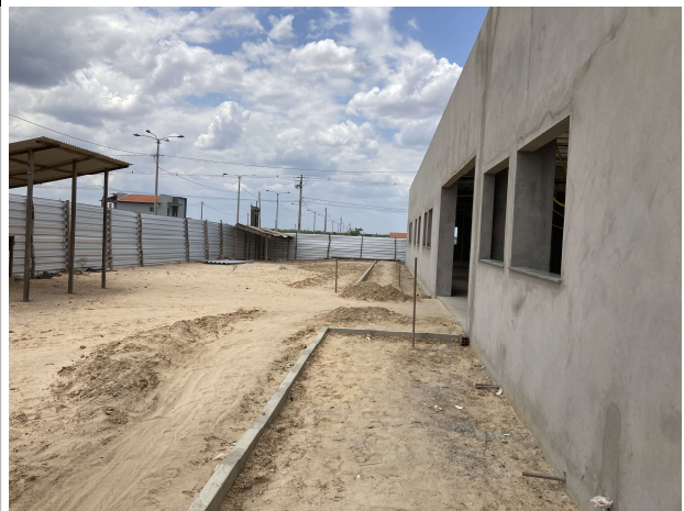
Fig. 10 – execução de meio fio
