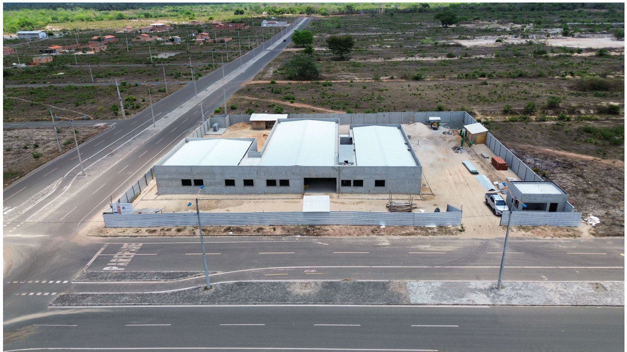
Fig. 1 – Vista aérea da obra
