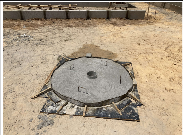
Fig. 18 – execução de instalações sanitárias
