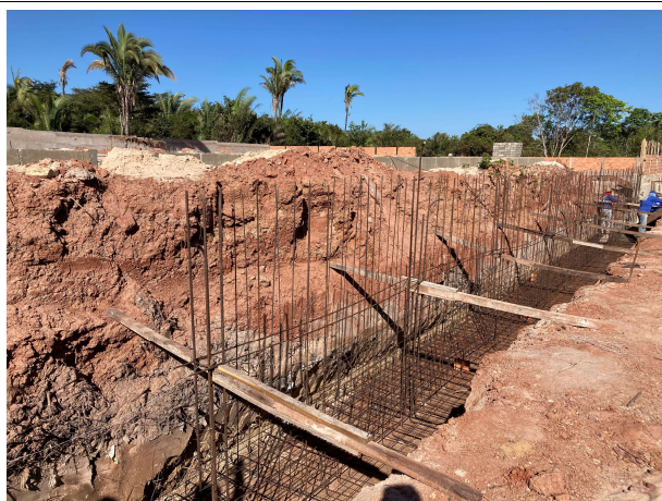
Fig. 3 – execução do muro de arrimo
