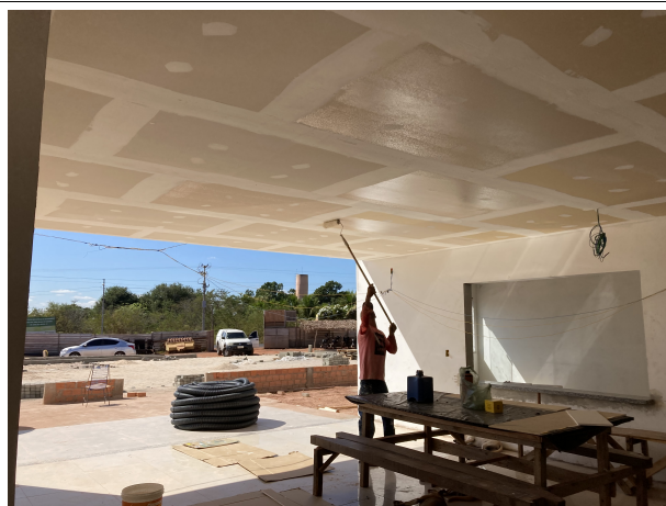
Fig. 16 – execução de pintura do forro
