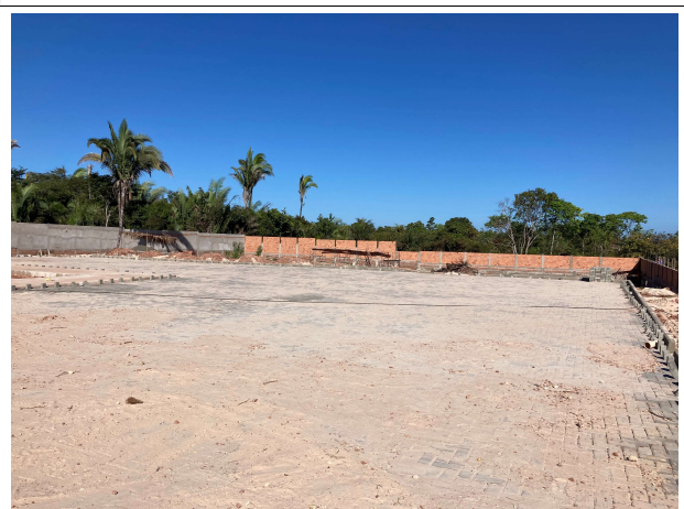
Fig. 12 – execução de pavimento intertravado
