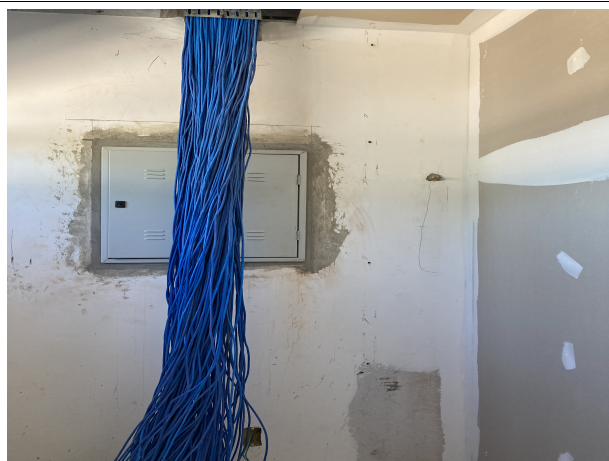
Fig. 15 – instalações lógicas e telefonia
