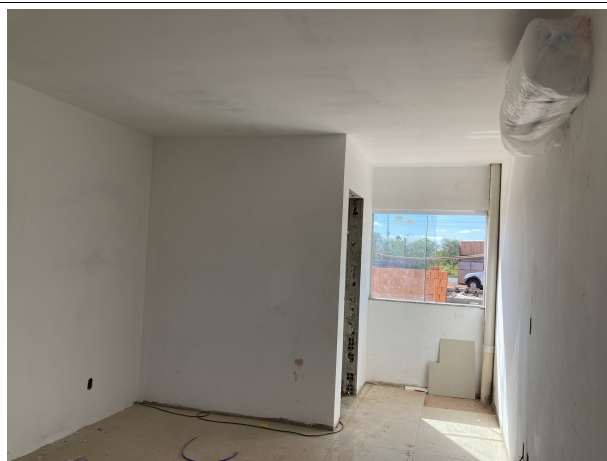
Fig. 14 – execução de pinturas
