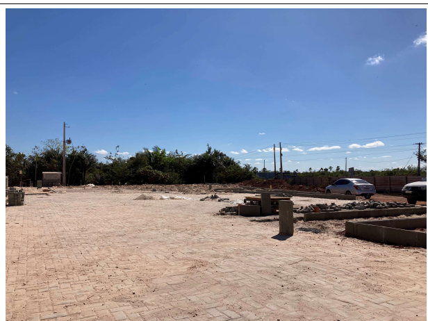
Fig. 11 – execução de pavimento intertravado
