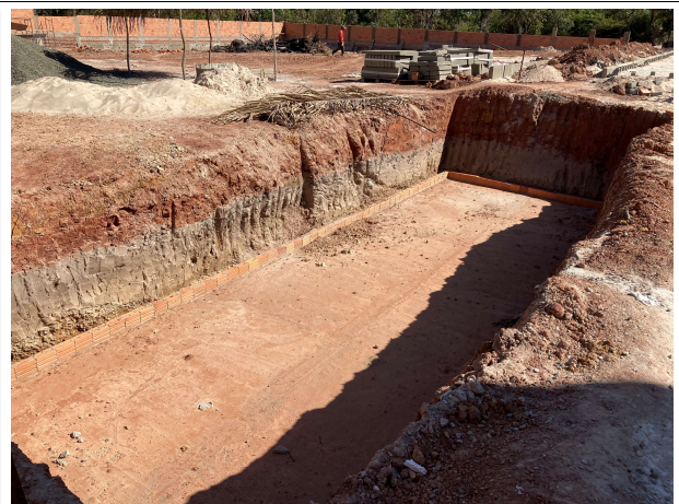
Fig. 10 – execução da cisterna
