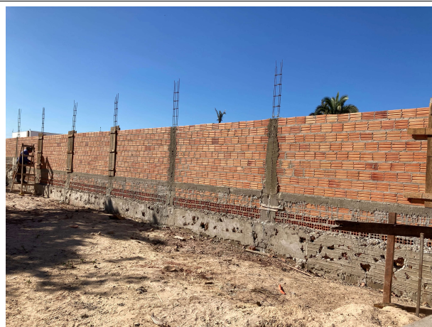
Fig. 4 – execução do muro de arrimo
