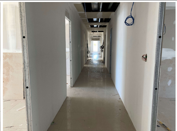
Fig. 8 – paredes de drywall do corredor
