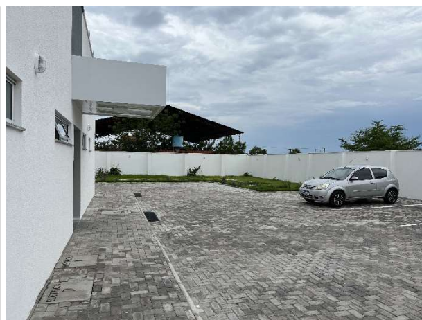
Fig. 15 – execução de pavimentação e muro lateral
