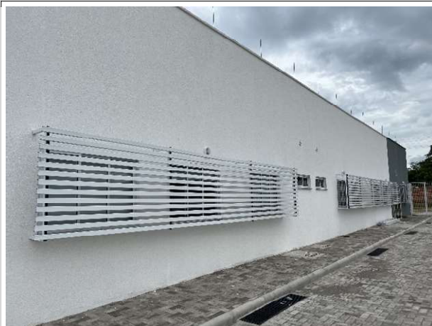
Fig. 17 – montagem de brises metálicos
