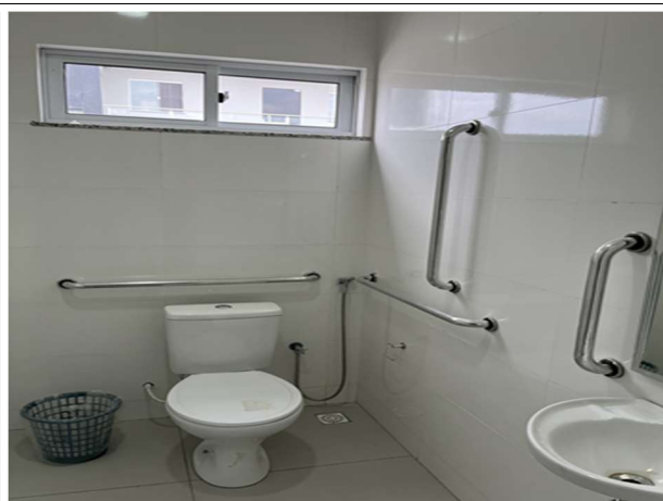
Fig. 10 – instalações hidrossanitárias e revestimentos
