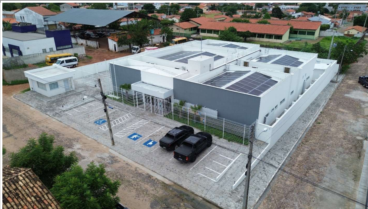
Fig. 1 – Vista aérea da obra
