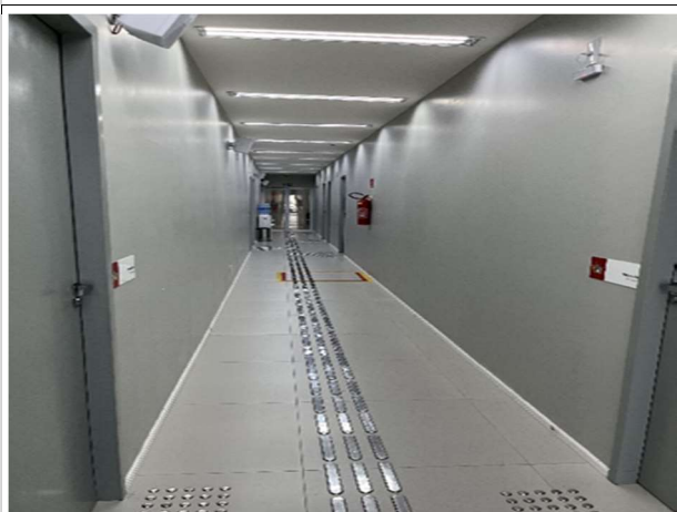
Fig. 11 – execução de portas, pintura e piso tátil
