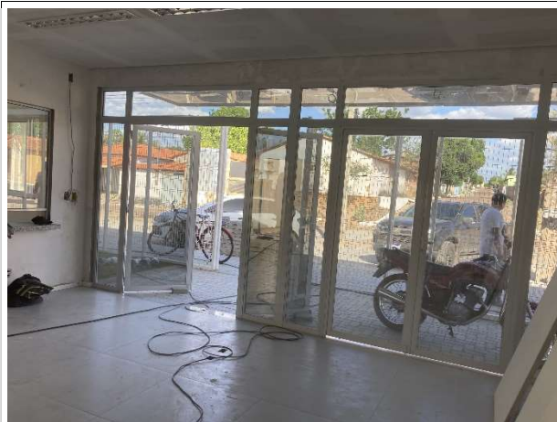
Fig. 9 – esquadrias de vidro (portas)
