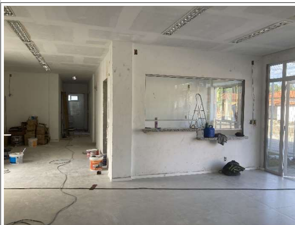
Fig. 7 – execução de piso, forro e esquadrias
