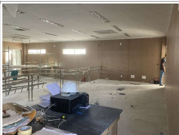
Fig. 11 – revestimento de MDF e forro
