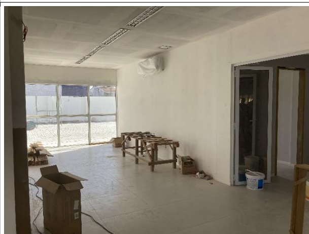
Fig. 6 – instalações elétricas e frigorígenas, piso e forro
