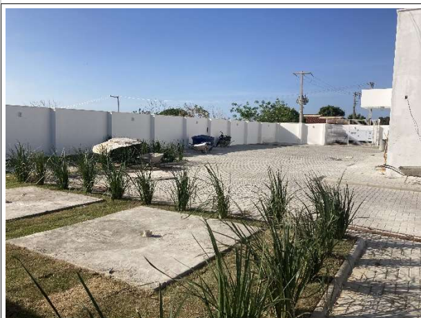
Fig. 13 – assentamento de piso intertravado e paisagismo
