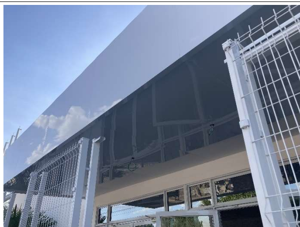
Fig. 20 – marquise de alumínio composto (complementares)
