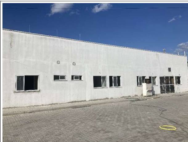
Fig. 19 – execução de esquadrias (janelas) e pintura
