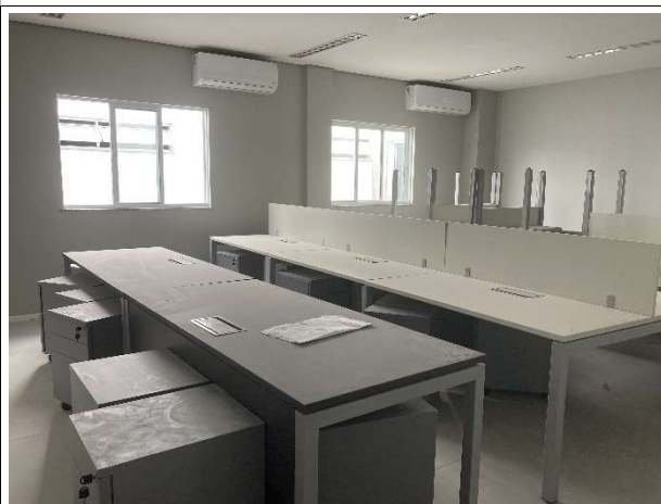
Fig. 8 – instalações elétricas, ar condicionado e pintura
