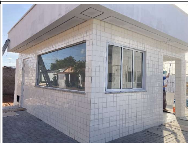
Fig. 5 – execução de revestimentos e esquadrias
