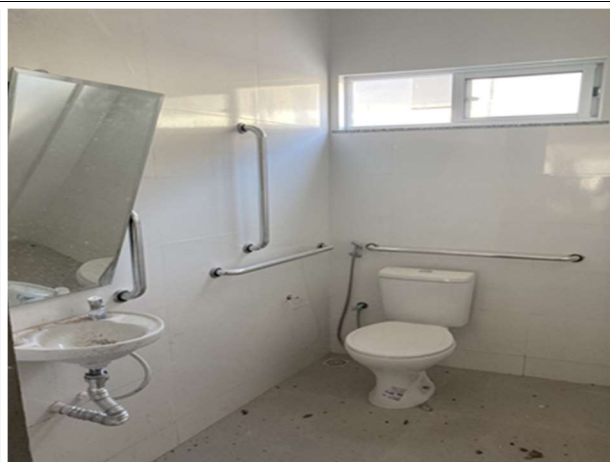
Fig. 10 – instalações hidrossanitárias e revestimentos
