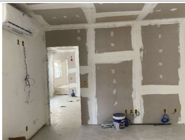
Fig. 8 – execução de parede e forro de drywall
