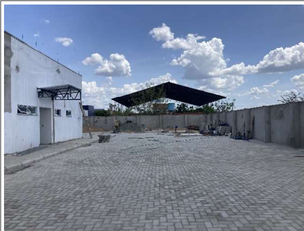
Fig. 13 – assentamento de piso intertravado
