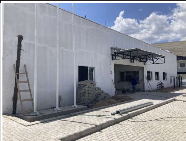
Fig. 3 – fachada da edificação
