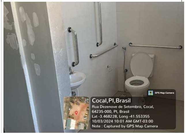
Fig. 10 – instalações hidrossanitárias e revestimentos
