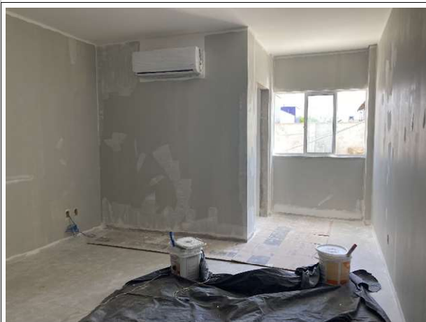
Fig. 7 – pintura de teto e parede, instalação de split
