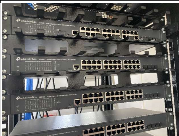
Fig. 11 – instalação de switches
