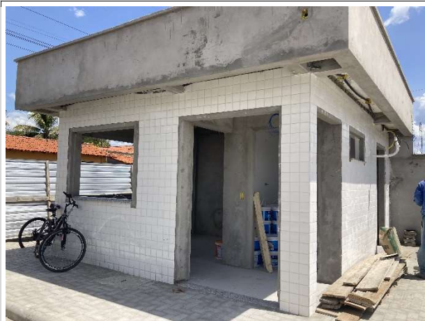
Fig. 5 – execução de revestimentos e instalações
