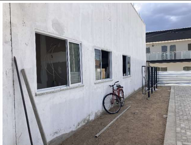
Fig. 4 – execução de esquadrias, pintura e tótem
