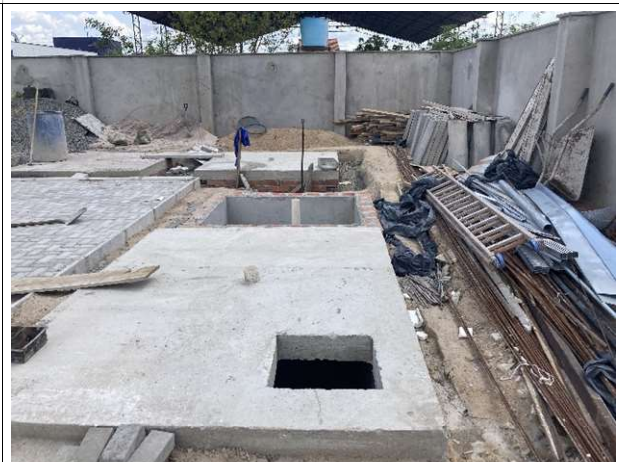
Fig. 20 – fossa e sumidouro (instalações hidrossanitárias)
