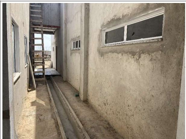
Fig. 14 – execução de paredes e esquadrias
