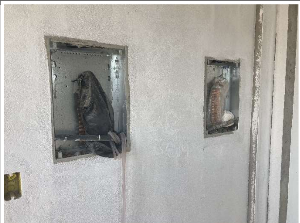
Fig. 12 – montagem de quadro de instalações elétricas
