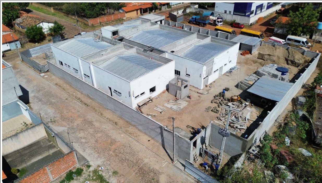
Fig. 2 – Vista aérea da obra em 01/08/2024
