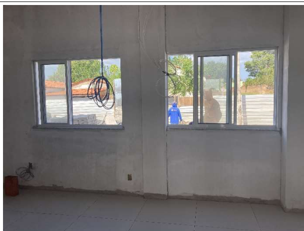
Fig. 13 – execução de pintura e esquadrias
