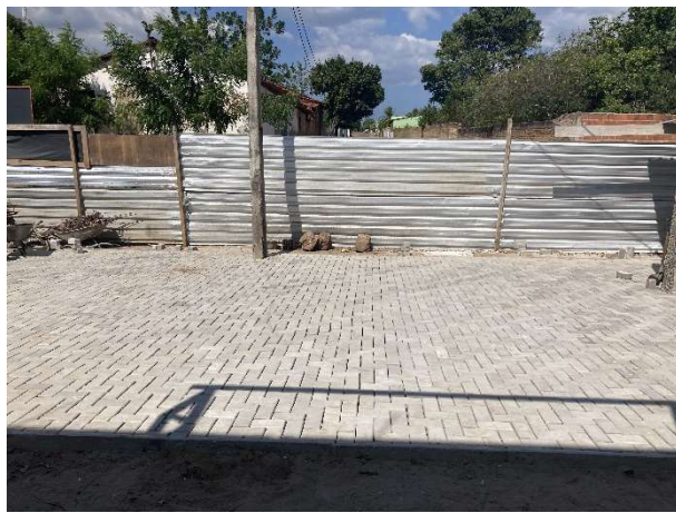
Fig. 15 – execução de pavimento intertravado
