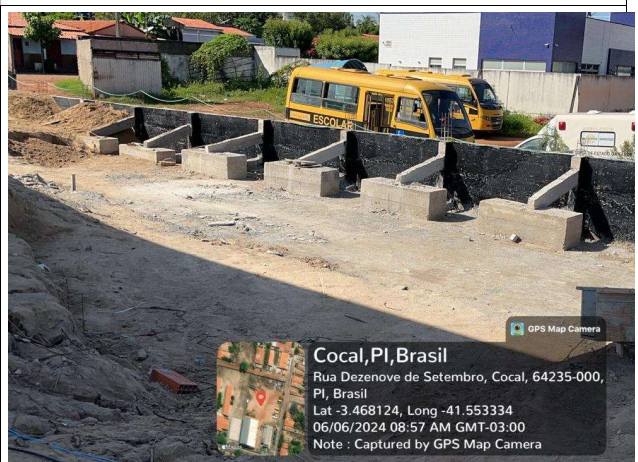
Fig. 20 – impermeabilização de paredes do muro
