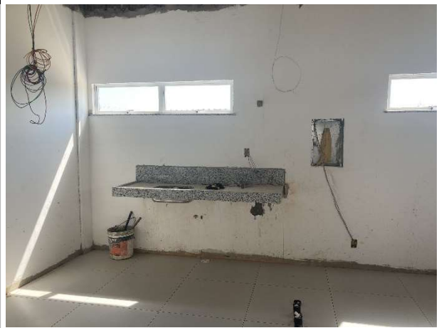
Fig. 10 – instalações hidrossanitárias e emassamento
