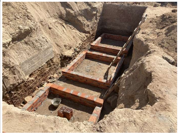
Fig. 16 – execução de sumidouro (instalações sanitárias)
