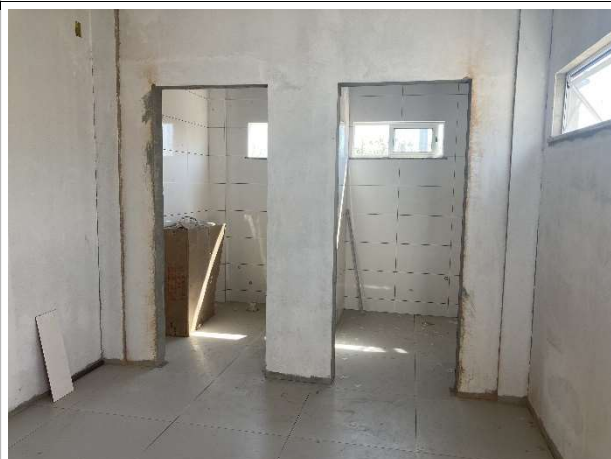
Fig. 6 – execução de revestimentos de piso e parede
