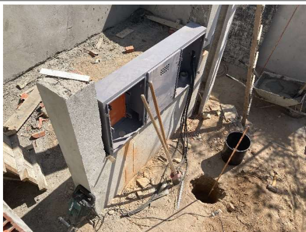
Fig. 17 – entrada de energia
