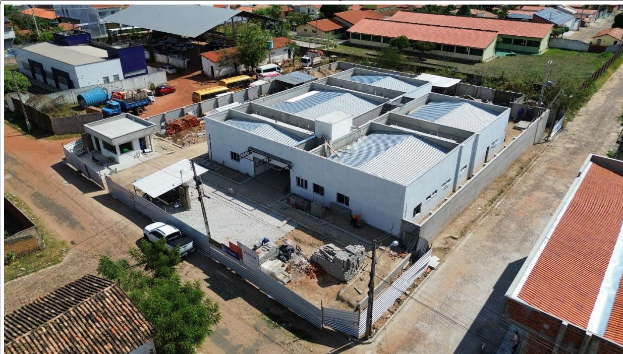
Fig. 1 – Vista aérea da obra em 01/08/2024
