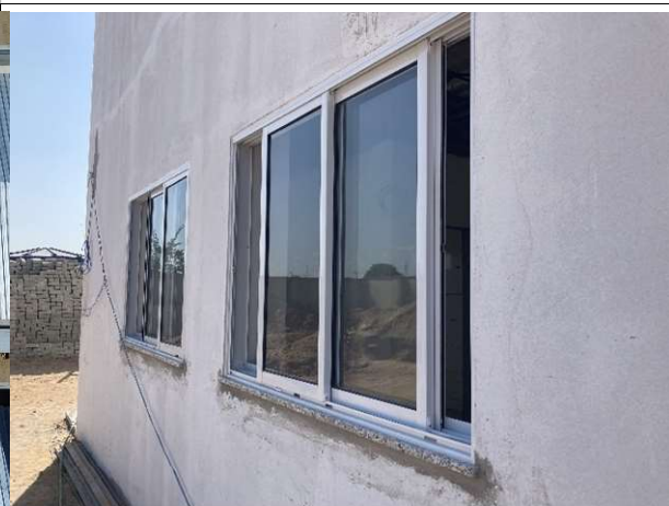
Fig. 8 – instalação de esquadrias de vidro
