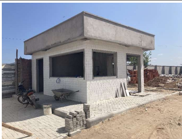
Fig. 3 – execução de revestimentos e piso intertravado
