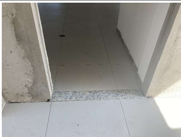
Fig. 11 – assentamento de piso e soleira de granito
