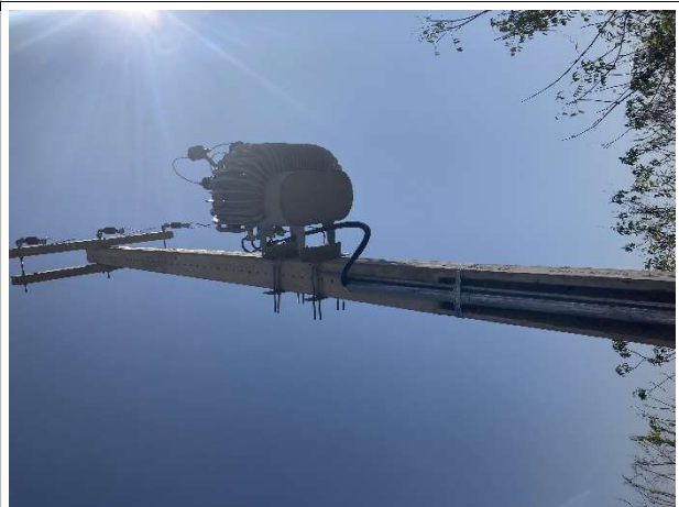
Fig. 18 – subestação aérea
