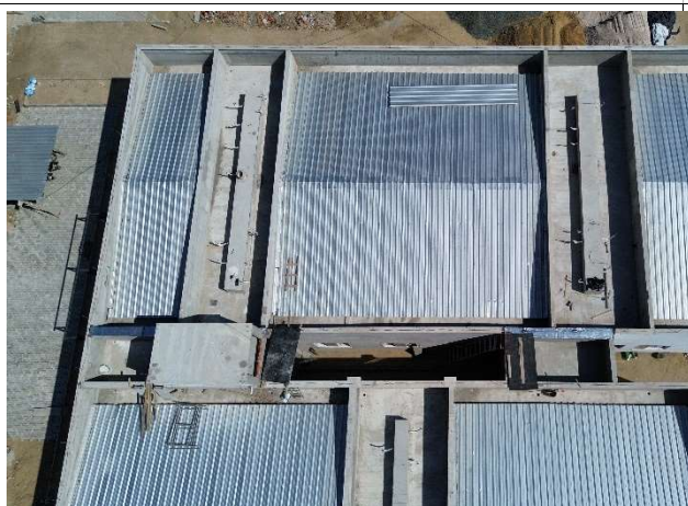
Fig. 7 – execução de cobertura e instalações frigorígenas
