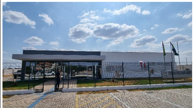
Fig. 4 – Pavimentação e pintura
