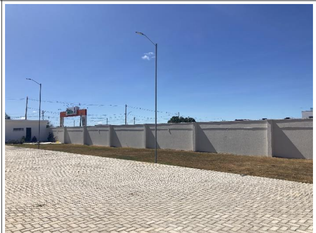
Fig. 12 – Pavimentação e instalações
