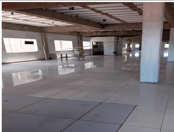
Fig. 3 – execução de piso cerâmico
