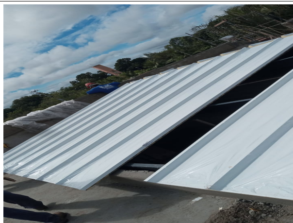
Fig. 5 – execução de telhamento
