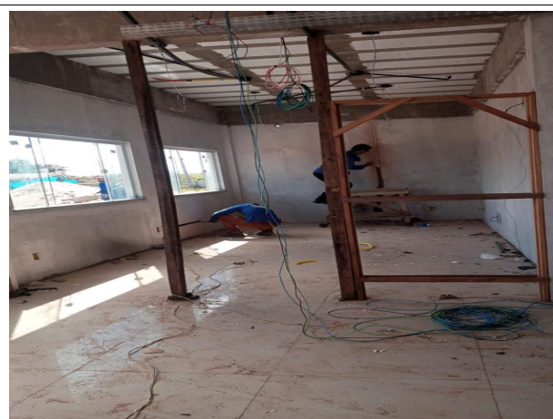
Fig. 11 – execução de instalações elétricas
