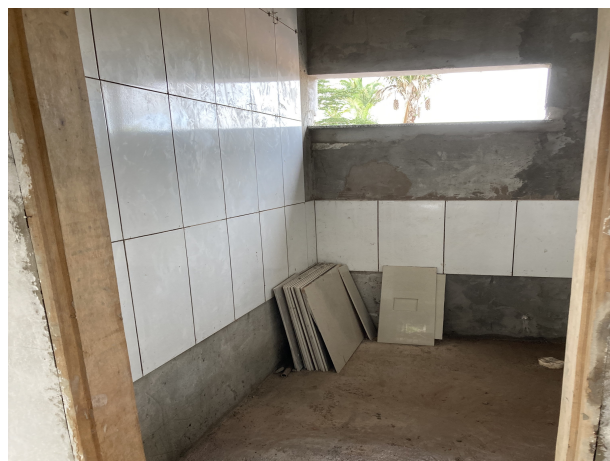
Fig. 9 – execução de revestimentos
