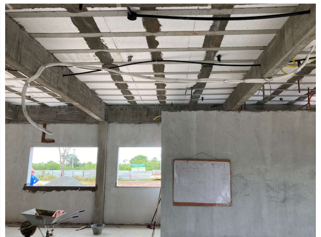
Fig. 10 – execução de rede frigorígena
