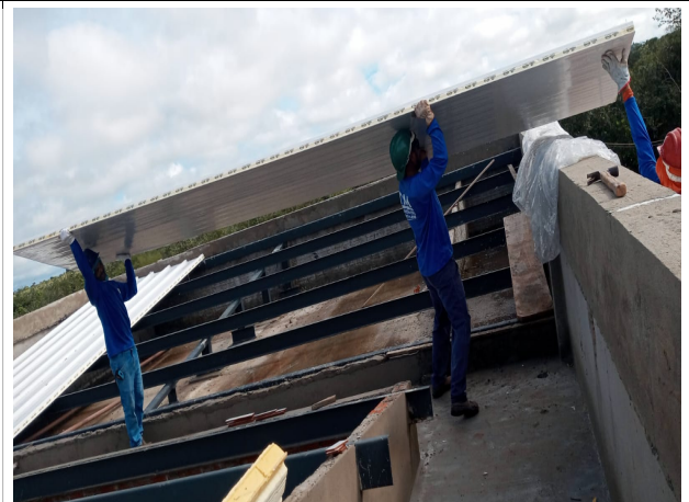
Fig. 4 – execução de telhamento
