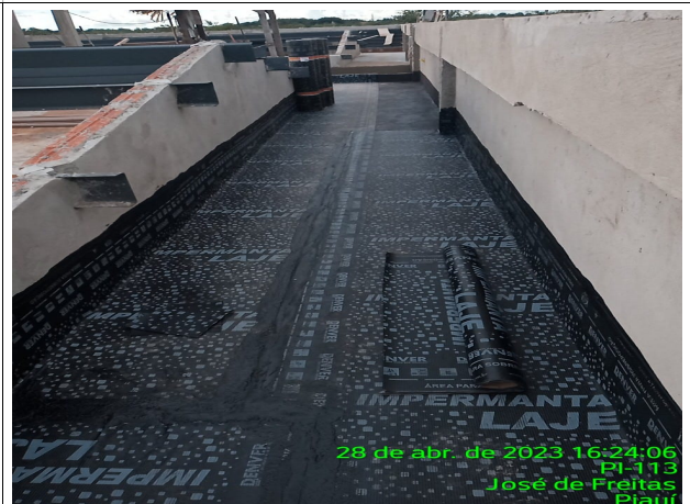
Fig. 6 – execução de impermeabilização
