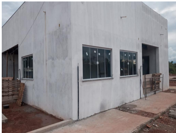
Fig. 1 – execução de esquadrias e emassamento
