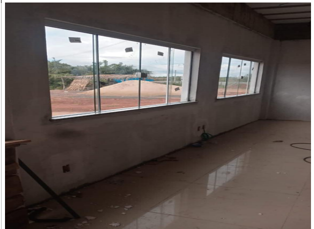
Fig. 2 – instalação de esquadrias e piso
