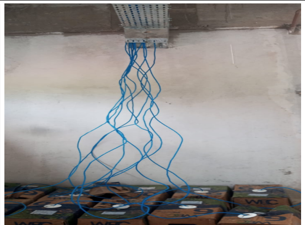
Fig. 8 – execução de instalação lógica
