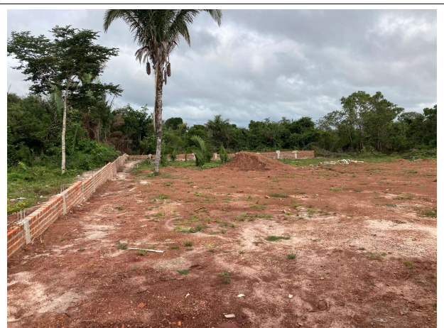
Fig. 12 – execução do muro do terreno
