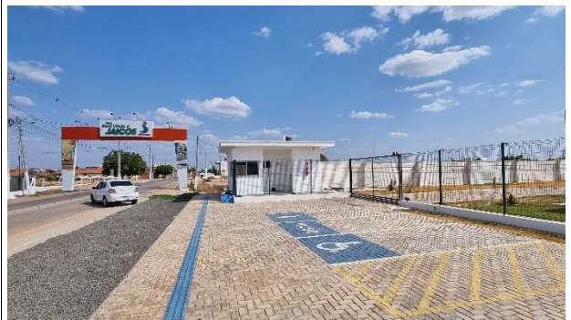
Fig. 4 – Pavimentação e pintura
