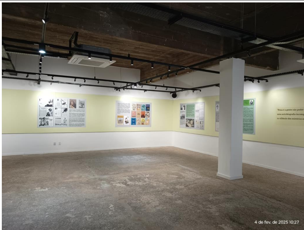
Fig. 12 – Salão de Exposições – Piso, paredes, instalações elétricas e de climatização executados.
