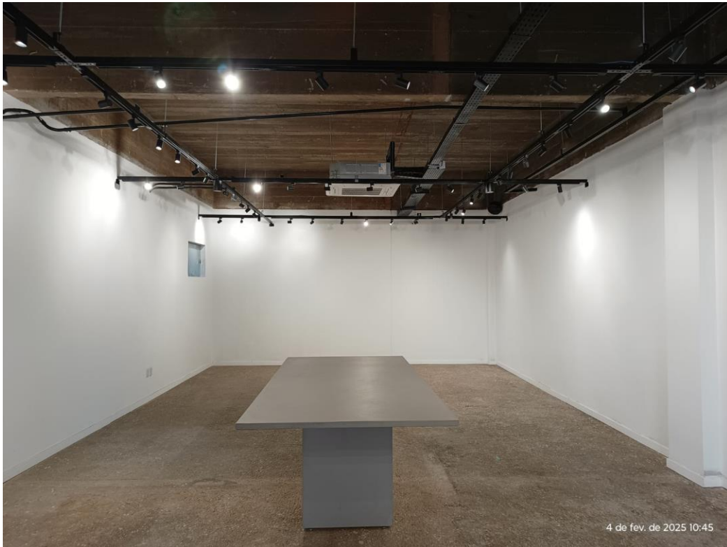
Fig. 11 – CCTJ educativo – Piso, paredes, instalações elétricas e de climatização executados.
