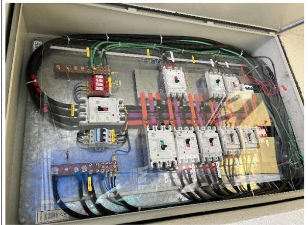
Fig. 16 – quadro geral de instalações elétricas
