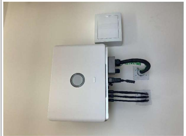
Fig. 16 – inversor (sistema fotovoltaico)
